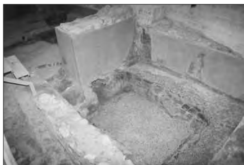
Lámina 10.3. Tepidarium II. Vista general tras la consolidación.
