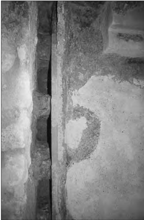
Láminas 8.2. Chimeneas restauradas, detalle.
