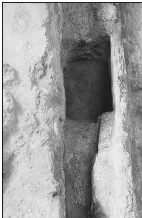
Láminas 8.1. Chimeneas, detalle.
