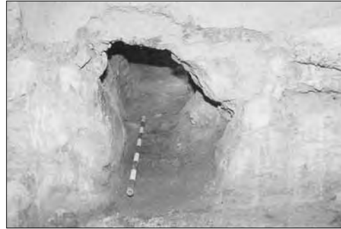
Lámina 9.1. Paso de aire caliente del caldarium II al tepidarium II.
