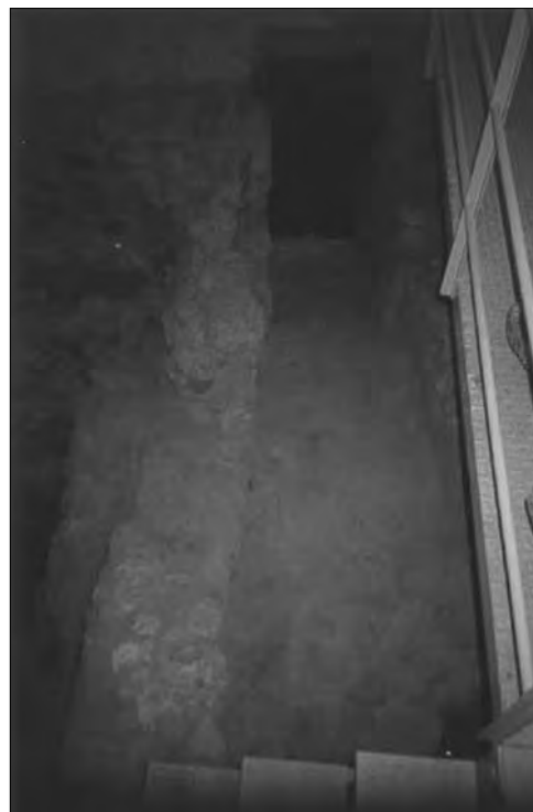
Lámina 11.1. Acceso a la sala medicinal antes de la restauración.
