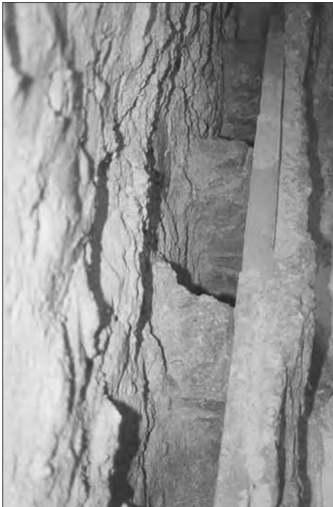
Láminas 8.3. Chimeneas restauradas, detalle.
