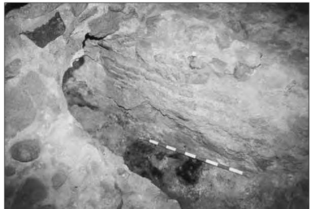
Lámina 3.1. Horno del caldarium II . Detalle del praefurnium .
