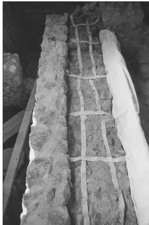
Lámina 15.2. Detalle de la fibra geotextil con la que se separa los muros antiguos de la restauración.
