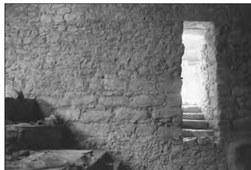
Lámina 12.2. Escalera, vista desde la sala medicinal.
