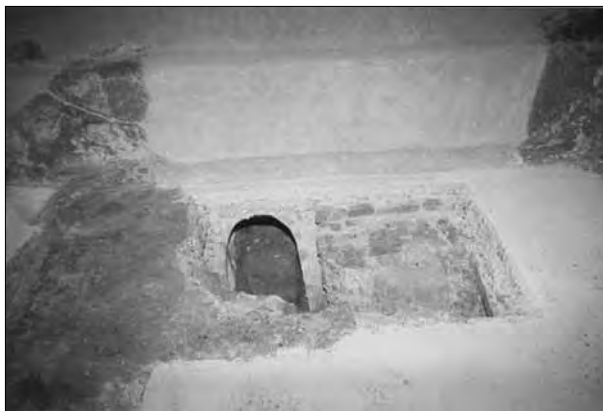
Lámina 3.3. Restauración del caldarium II. Detalle final del præfurnium .
