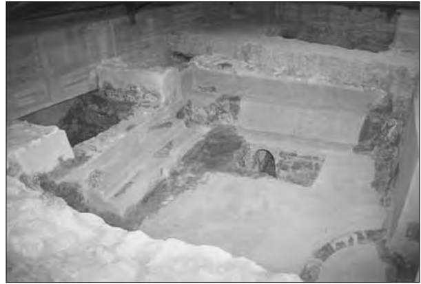
Lámina 2.1. Caldarium II , ya consolidado.
