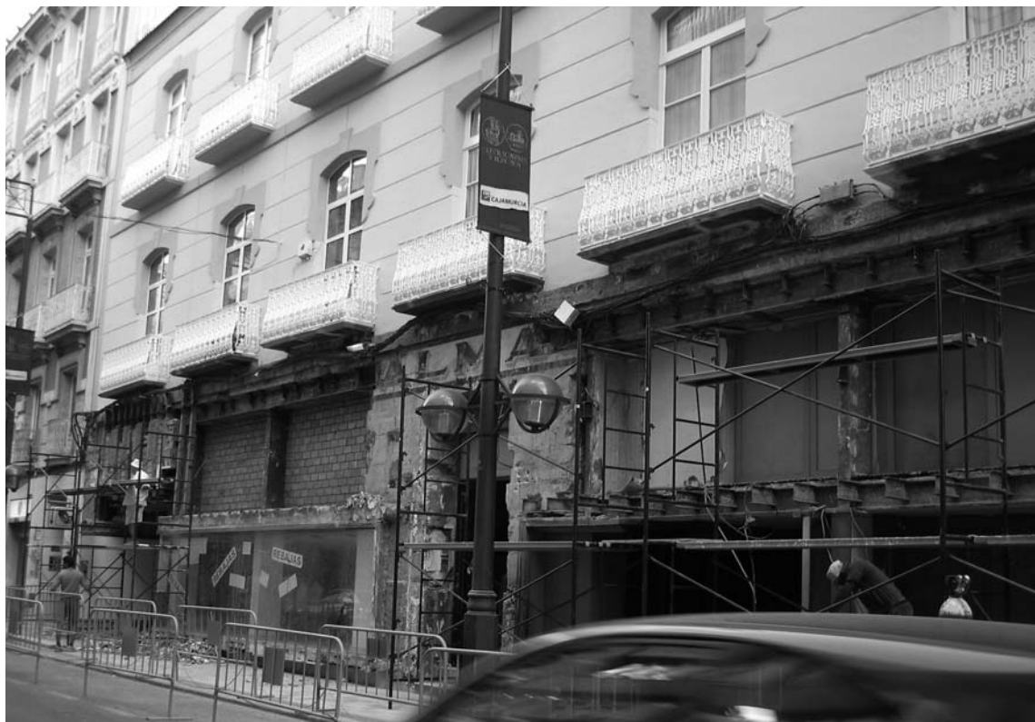
Imagen 11. Edificio en Plaza de Castellini n.º 10. Estado intermedio de la intervención.
