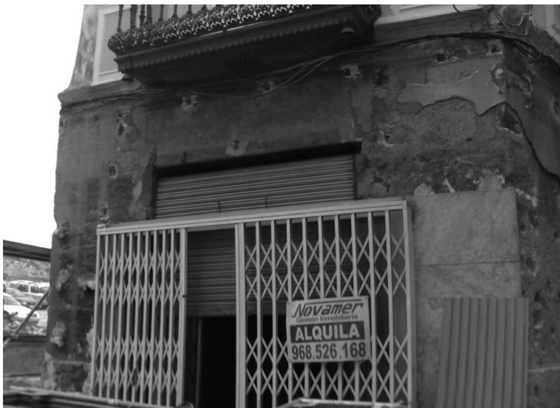
Imagen 8. Aparición de sillares de piedra arenisca natural, tras eliminar aplacados. Edificio en C/. Balcones Azules, n.º 2.
