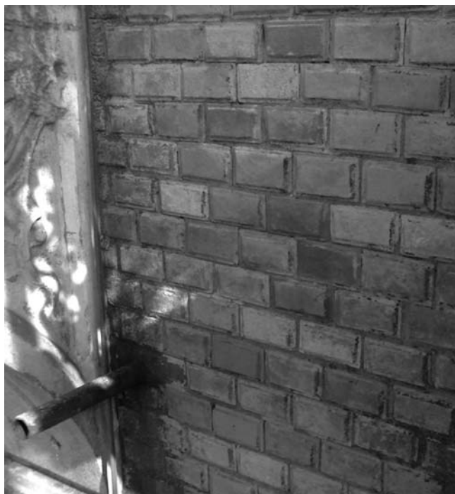
Imagen 9. Estado posterior a la eliminación de pintura sobre ladrillo con chorreo de micro-strip de polvo de aluminio en seco. Edificio en C/. Palas, n.º 12.
