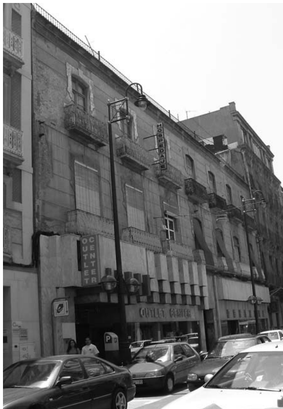
Imagen 10. Edificio en Plaza de Castellini n.º 10. Estado previo a la intervención.
