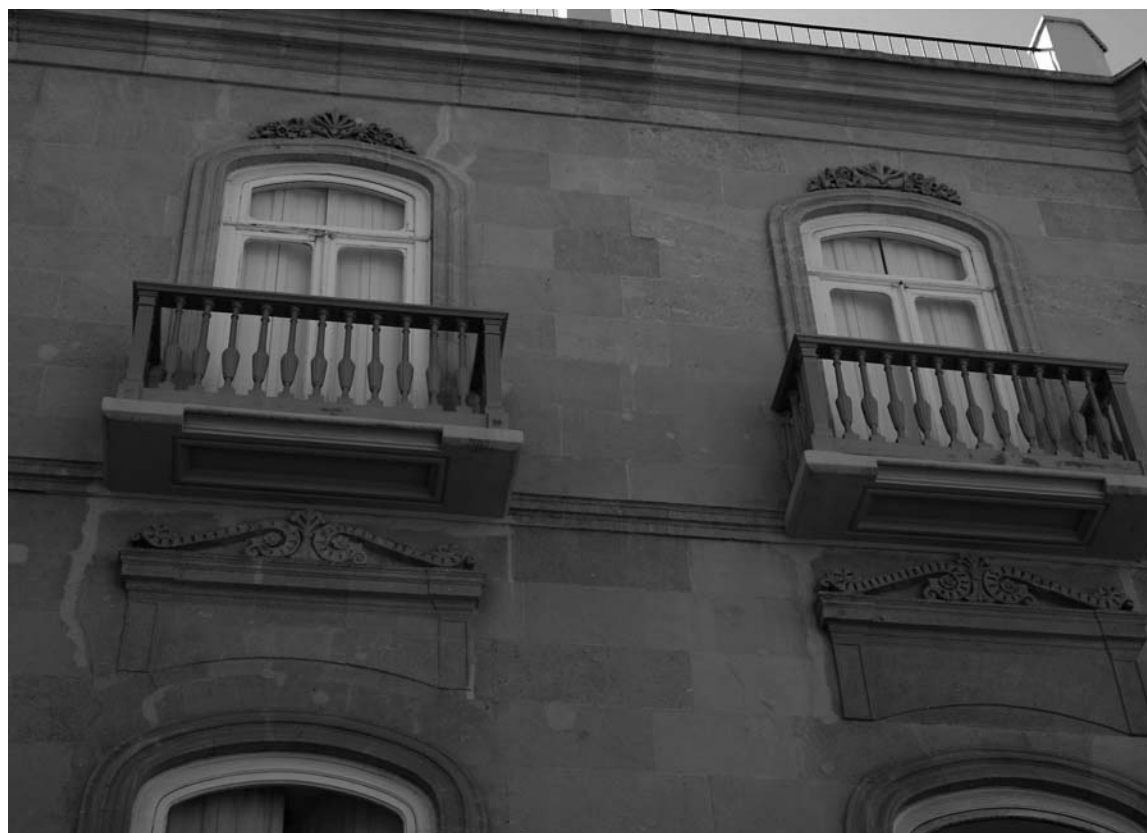
Imagen 1. Detalle balaustrada de cinc plegado. Palacio Spottorno. C/. del Cañón, n.º 6.
