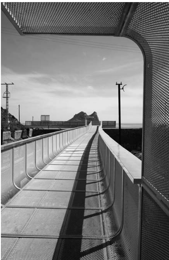
Figura 5. Vista de la pasarela y del mirador (foto: David Frutos).
