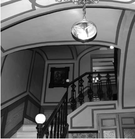
Lámina 10. Detalle de la escalera principal de la Casa-Museo de bóvedas tabicadas y rampas a montacaballo. Año 2008.
