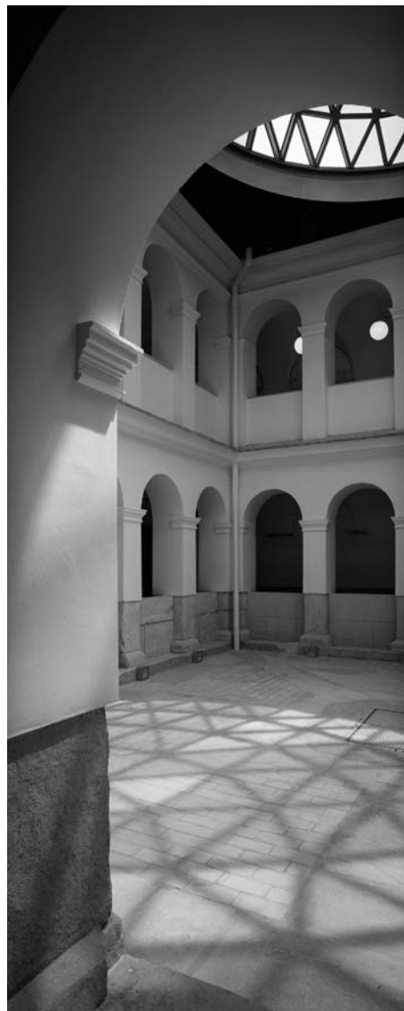
Figura 8. Vistas del interior del Claustro.
