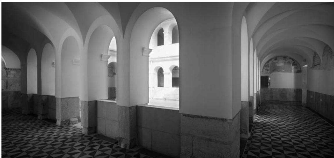
Figura 5. Baldosa hidráulica del interior del Claustro.
