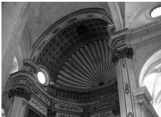
Figuras 5 y 6. Bóveda compuesta por una bóveda de horno y una bóveda de cañón con casetones. Capilla Mayor de la Colegiata de San Patricio. Siglo XVI.
