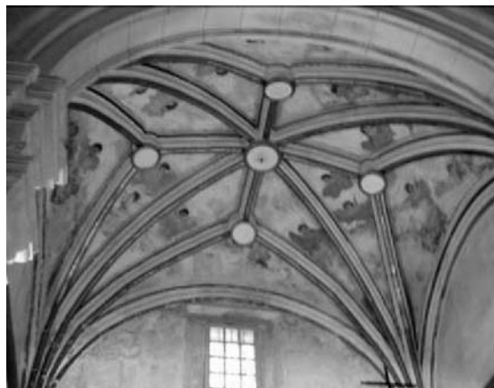
Fig. 13. Bóveda de crucería con terceles. Capilla Colegiata de San Patricio. Siglo XVII.
