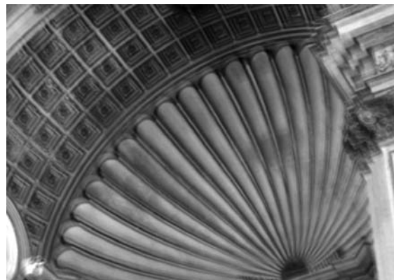
Figuras 5 y 6. Bóveda compuesta por una bóveda de horno y una bóveda de cañón con casetones. Capilla Mayor de la Colegiata de San Patricio. Siglo XVI.
