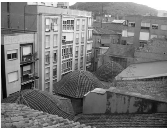
Figura 12. Imagen general de las distintas tipologías de cubierta. Al fondo se aprecia la utilización de placas de fibrocemento en las naves laterales, sin un criterio correcto de intervención para la categoría de edificio.
