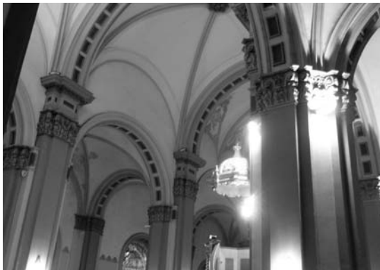
Figura 4. Vista general de las bóvedas de las naves central y laterales.
