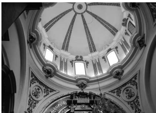
Figura 3. Cúpula, tambor y pechinas de la Capilla de Jesús del Prendimiento.
