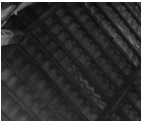
Figura 6. Detalle del interior de la Nave de la Epístola de la Iglesia. Se observa que el material de cubrición es el fibrocemento. (Fotografía cedida por la empresa constructora Geocisa).
