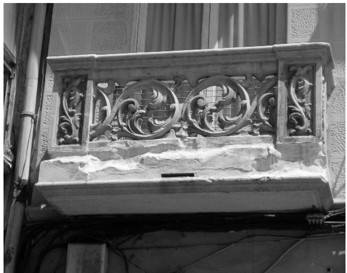
Figura 2. Balcón en fachada de la calle San Francisco n.º 65
