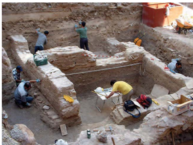
Lámina 1. Panorámica del proceso de intervención.
