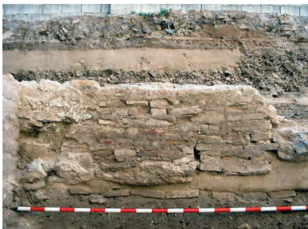
Lámina 5. Detalle de estructuras de cimentación pertenecientes al siglo XVII sobre las cimentaciones de los siglos XV-XVI.
