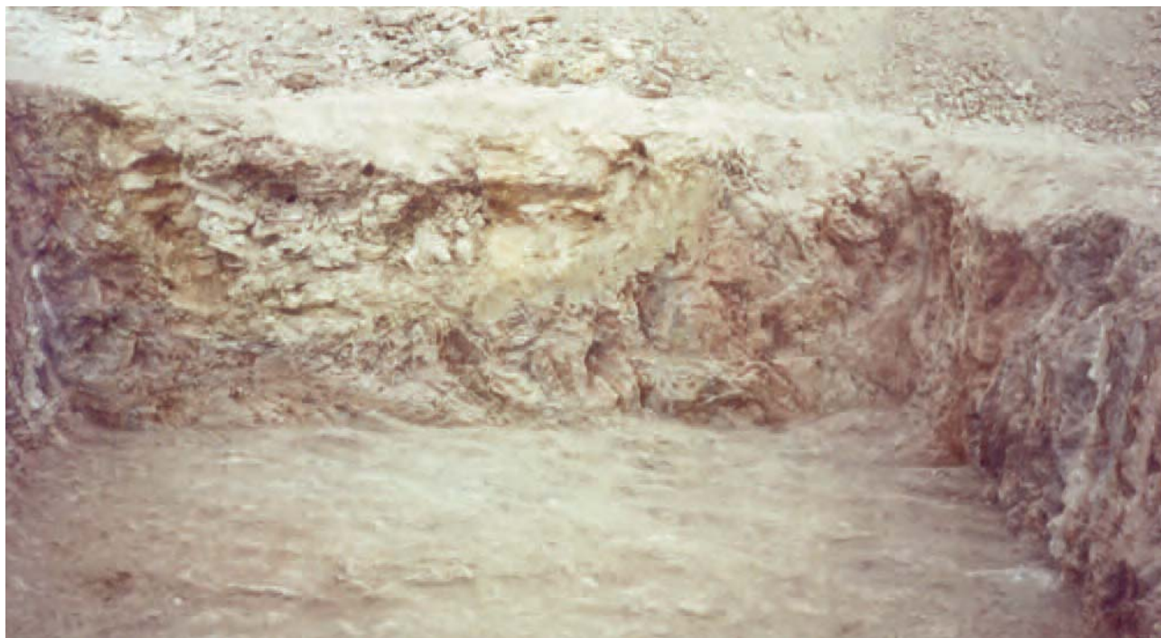
Lámina 1. Cata 1. Semisótano y niveles de roca.
