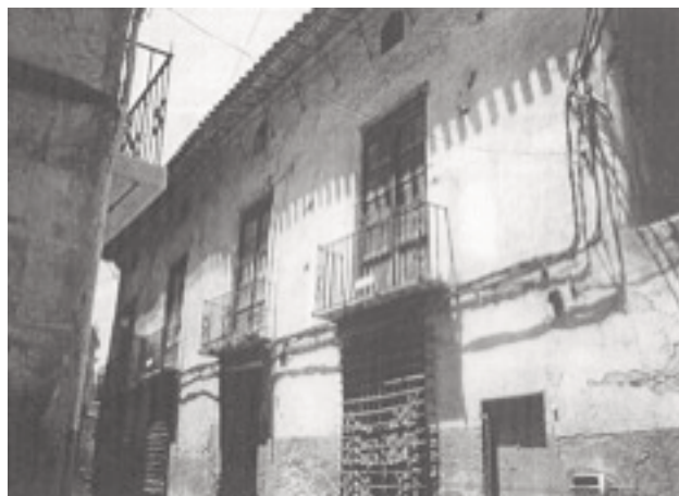
Lámina 2. Fachada principal antes de la intervención.
