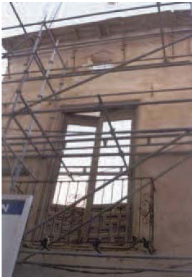
Lámina 3. Detalle balcones segunda planta y ventanas de la tercera, de la fachada calle Zapatería.
