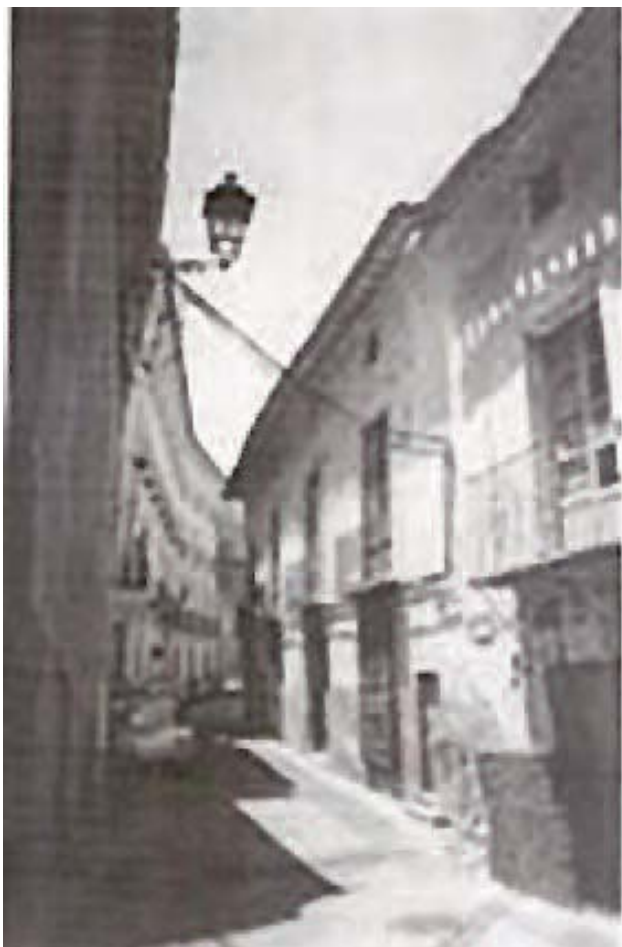
Lámina 1. Fachada principal calle Zapatería antes de la intervención.
