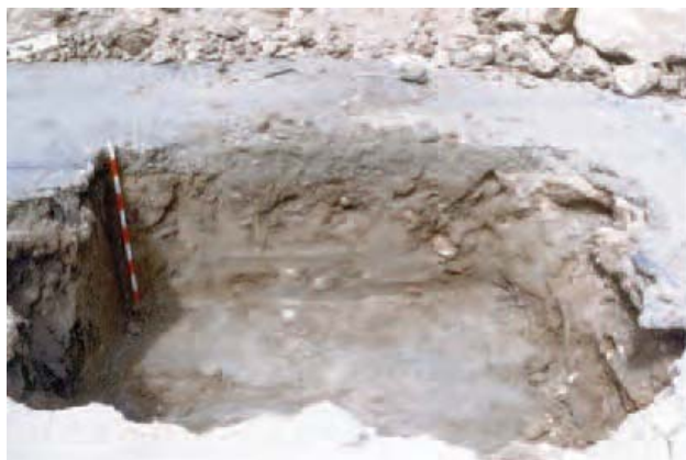
Lámina 8. Sondeo del hueco del ascensor.
