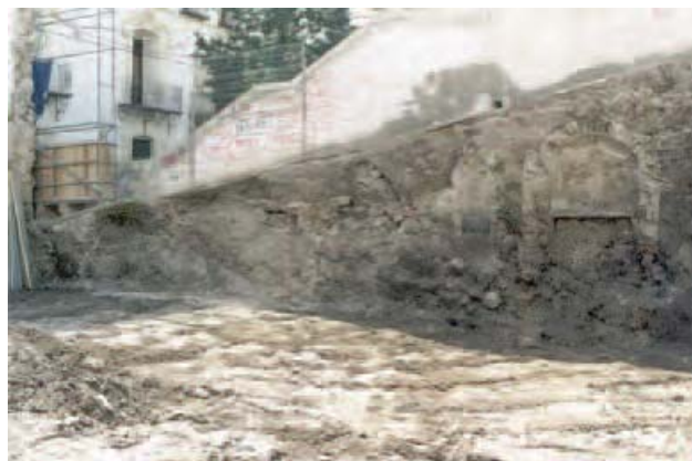
Lámina 5. Estructuras de la vivienda empotradas bajo la calle Vaquero. Perfil sur, en el suelo horizontal nivel geológico de arcillas.
