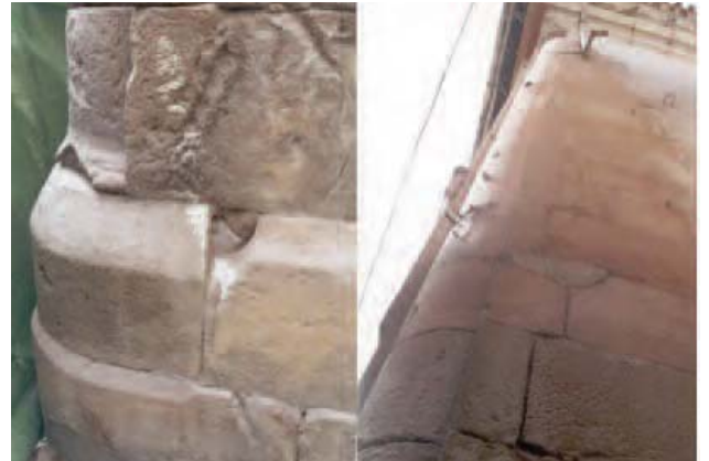
Lámina 9. Esquina de sillería calle Selgas-Marmolico.
