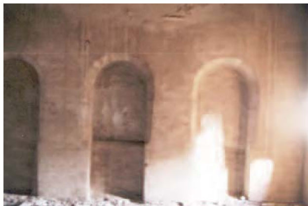
Lámina 4. Arcos tapiados que forman la galería superior o logia.
