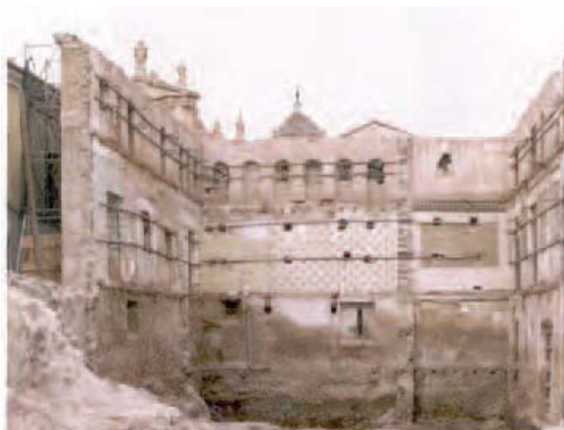
Lámina 25. Galería superior y cerramientos de la misma.
