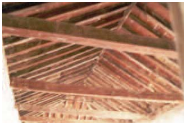
Lámina 6. Artesonado que forma el tejado a dos aguas.
