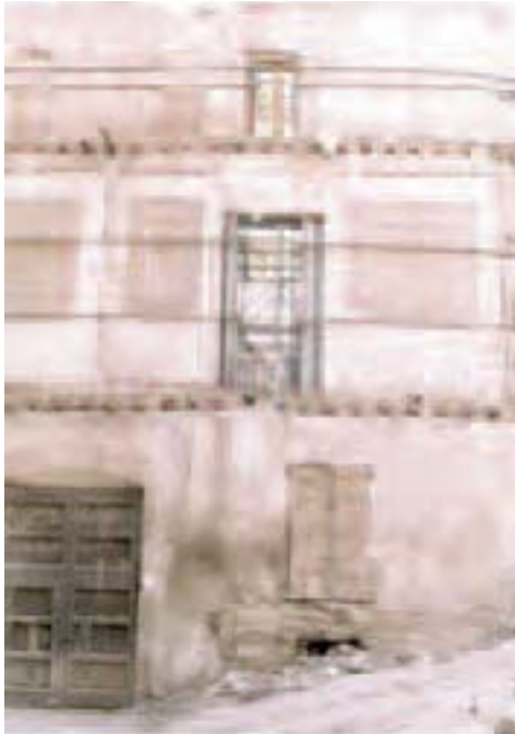
Lámina 8. Fachada calle Selgas, interior.
