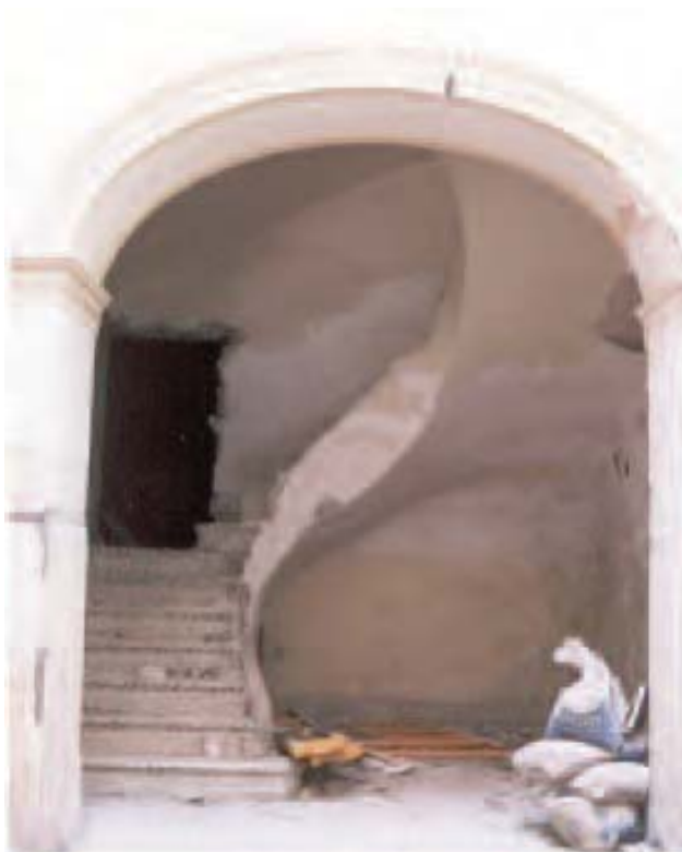
Lámina 30. Escalera realizada en 1852.
