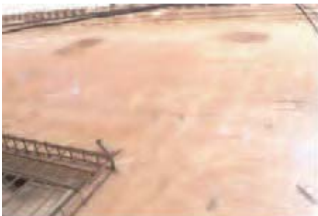
Lámina 11. Exterior fachada calle Marmolico.
