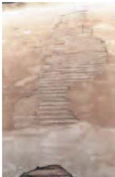
Lámina 12. Exterior fachada calle Marmolico. Detalle de la fábrica del muro.
