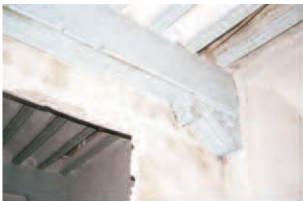
Lámina 5. Vigas con ménsulas labradas.
