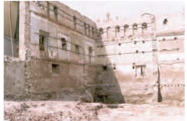
Lámina 10. Interior paramentos de las calles Marmolico y Aguadores.
