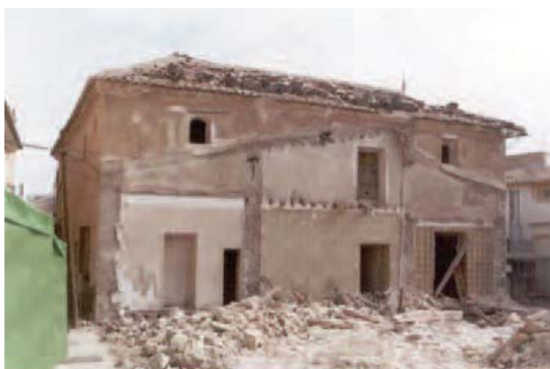
Lámina 15. Fachada oeste y adosados posteriores.
