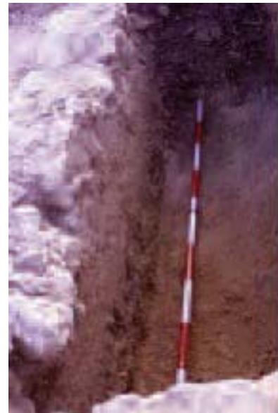
Lámina 4. Cara del muro encofrado.
