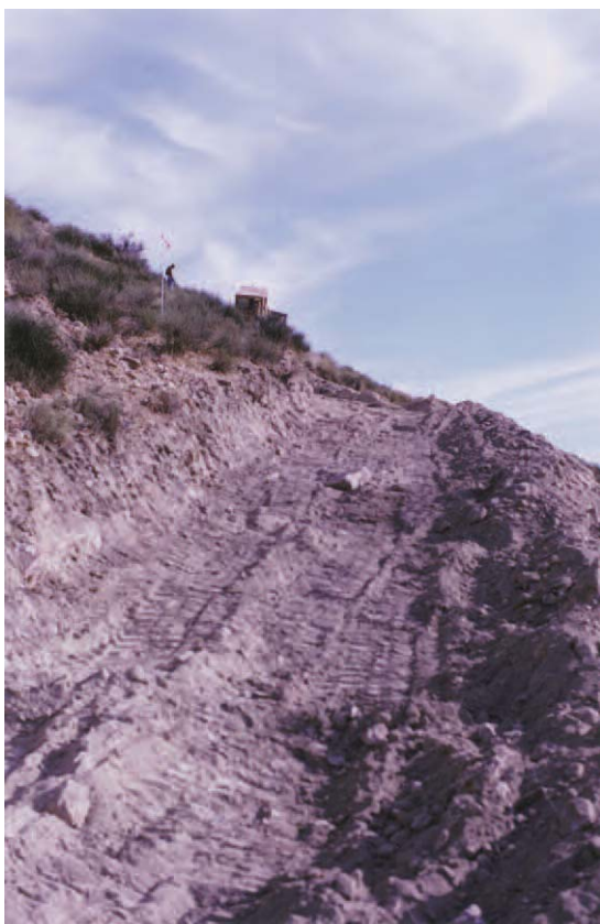
Lámina 3. Construcción del camino.
