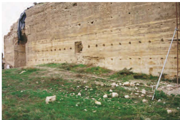
Lámina 4. Lienzo de muro del recinto interior.
