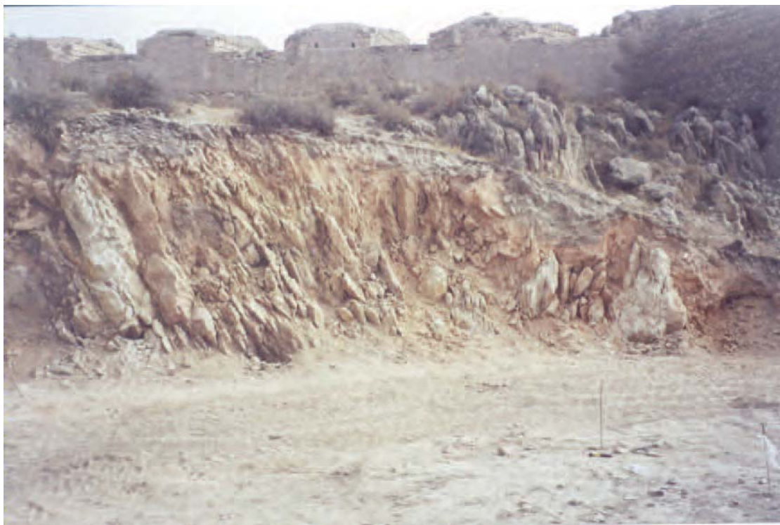
Lámina 1. Desmonte de la ladera para ubicar la Máquina del Tiempo.
