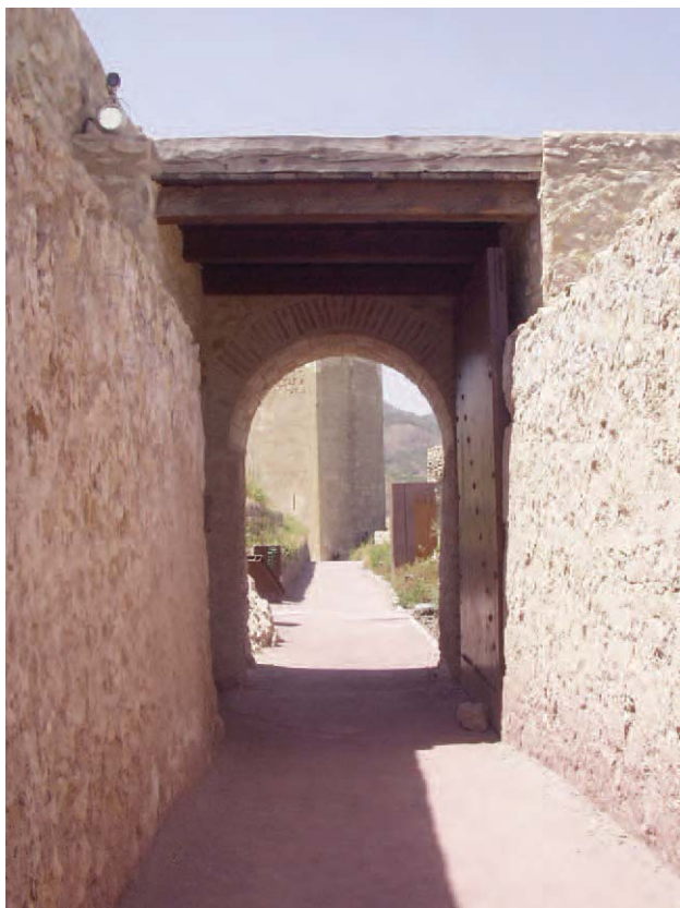
Lámina 2. Corredor cubierto y poterna restaurados.
