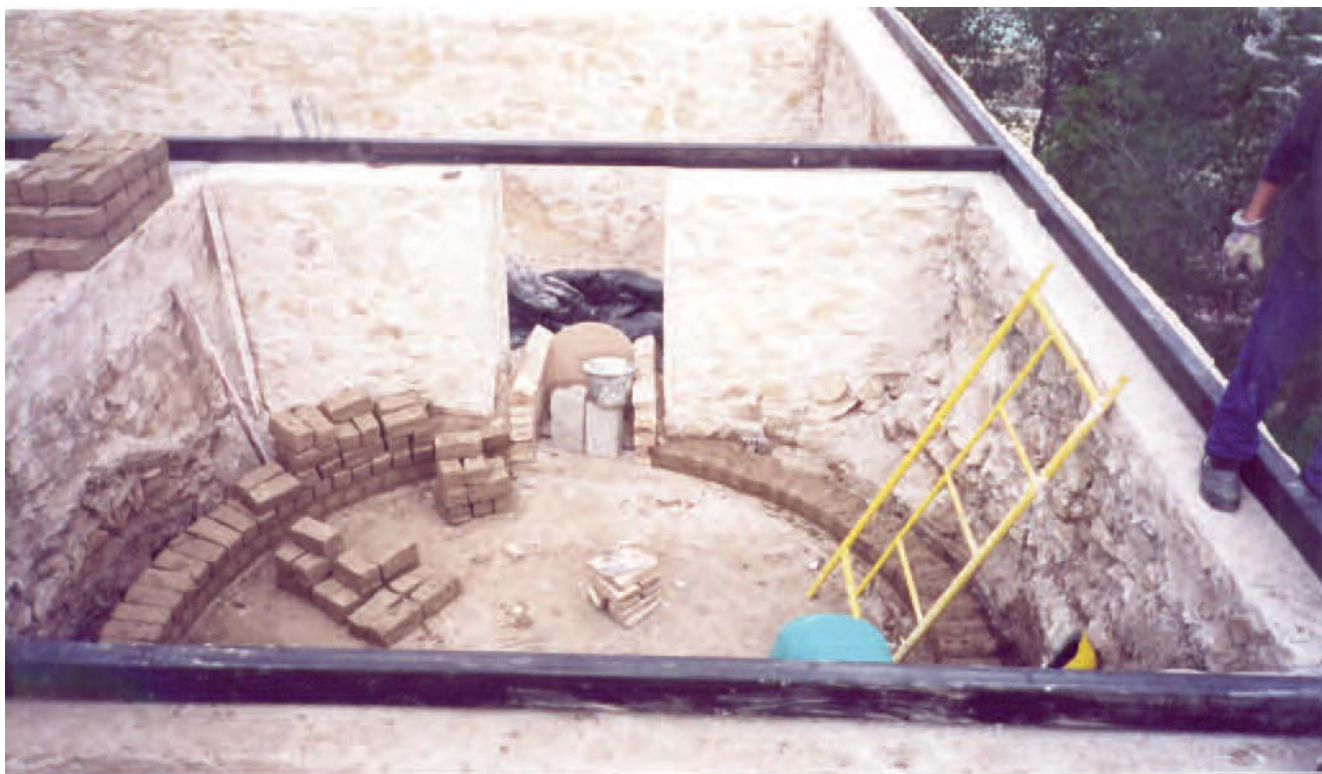
Lámina 7. Restauración de los hornos.
