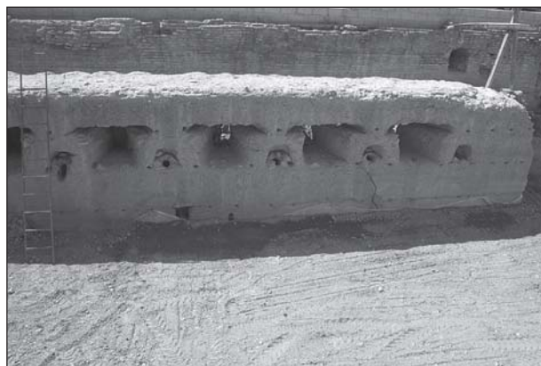
Figura 5: Detalle del antemuro II, jalonado por saeteras y lanceras.
