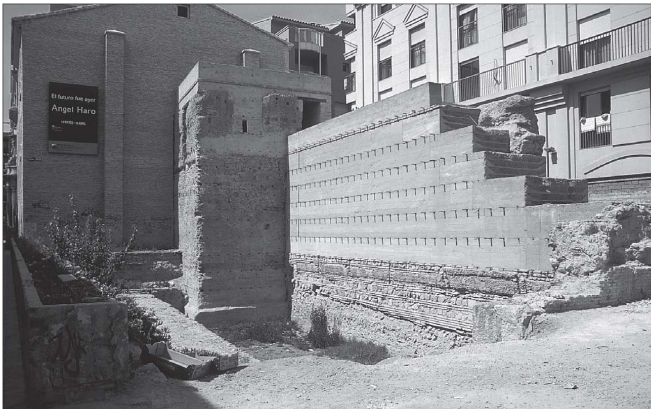
Figura 9: Estado actual de las defensas tras la restauración.
