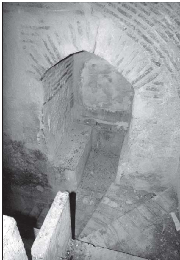
Figura 5. Torre del Homenaje. Segunda planta. Puerta ventana. Vista desde el este.
