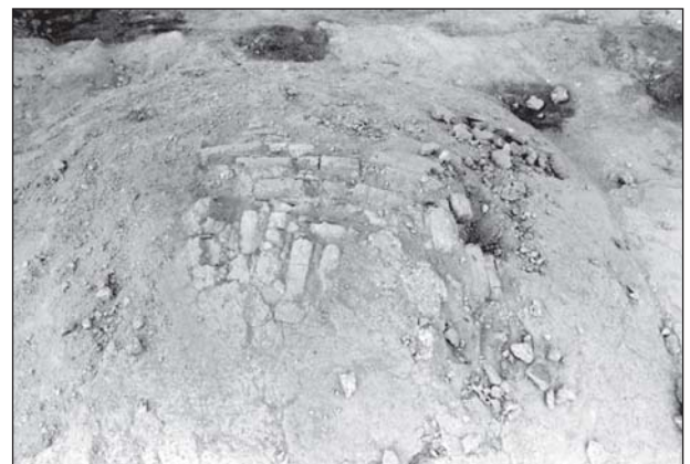
Figura 16. Torre del Homenaje. Terrado original del edificio. Extradós de una bóveda.
