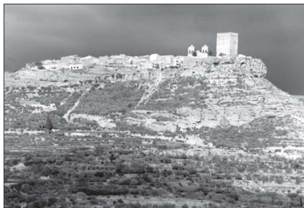
Figura 1. Villa medieval de Aledo. Vista desde el oeste.
