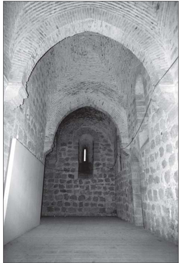
Figura 3. Torre Alfonsina. Segunda planta. Vista desde el norte.
