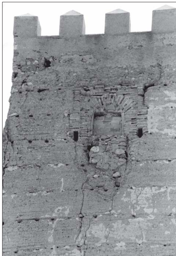
Figura 13. Torre del Homenaje. Segunda planta. Puerta-ventana desde el exterior. Vista desde el oeste.
