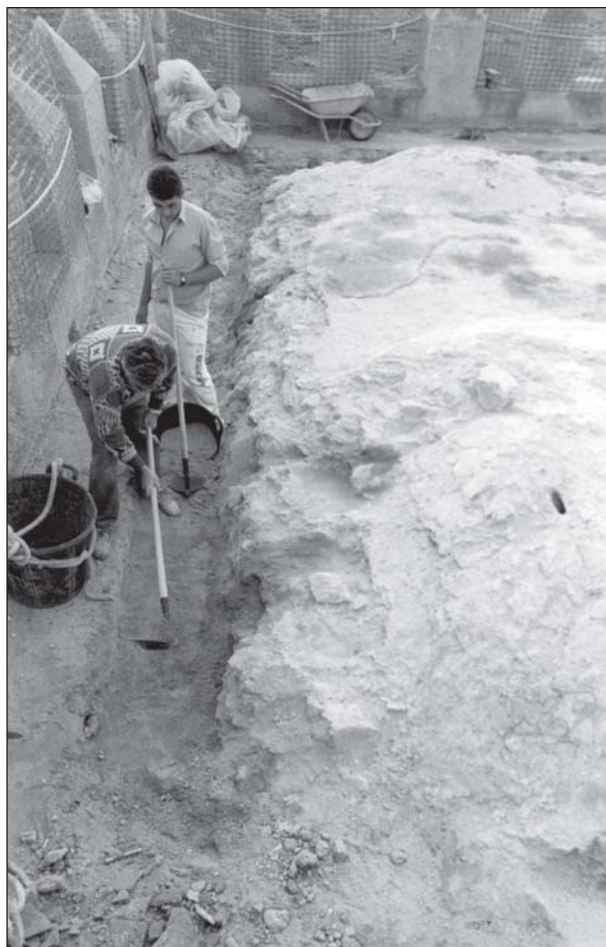
Figura 18. Torre del Homenaje. Terrado original del edificio. Labores de limpieza del perímetro interior del terrado.
