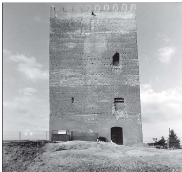
Figura 7. Torre del Homenaje. Fachada este. La entrada original del edificio corresponde al vano intermedio.
