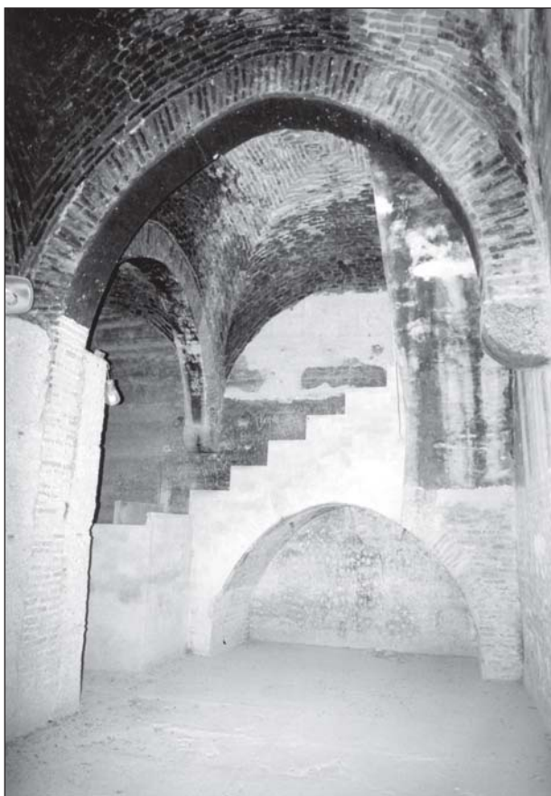
Figura 10. Torre del Homenaje. Primera planta. Vista desde el oeste.
