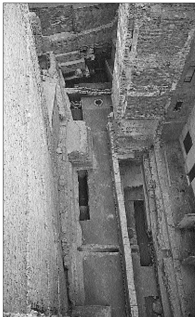
Fig. 2. Líneas de fortificación reutilizadas parcialmente en las construcciones actuales. A la izquierda muralla y torreones y a la derecha antemuralla. En el centro del solar se observa un muro que divide la liza en época cristiana.
