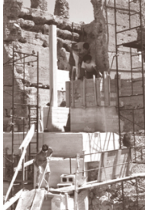
DURANTE LA INTERVENCIÓN. CONSTRUCCIÓN DE MUROS
