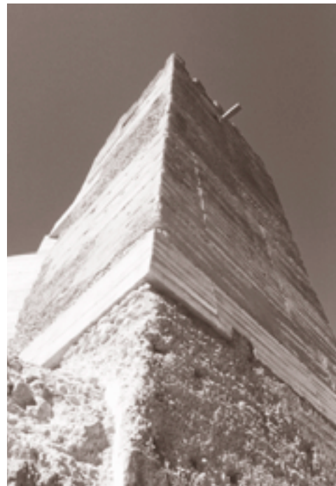
POSTERIOR A LA INTERVENCIÓN
