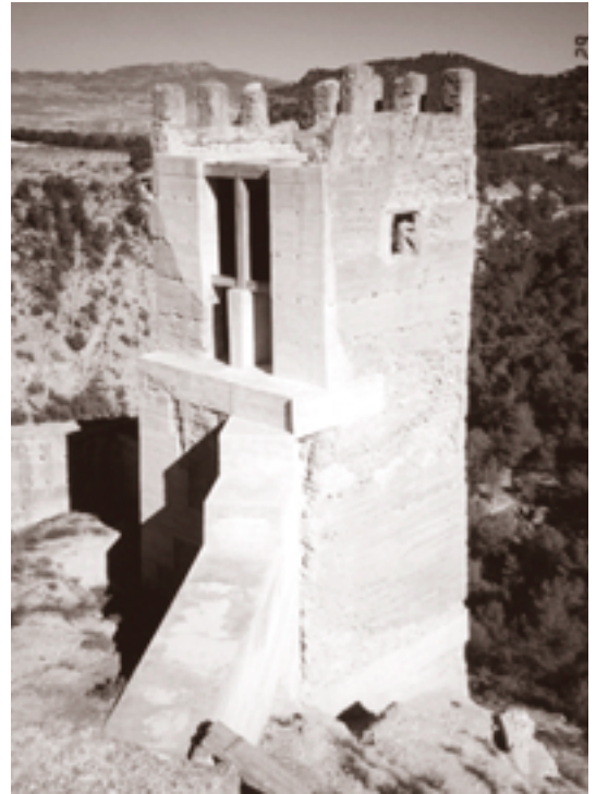
POSTERIOR A LA INTERVENCIÓN
