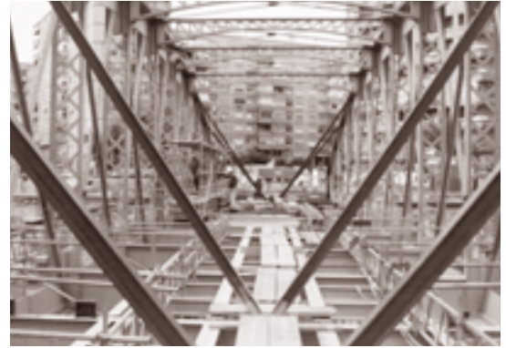
DURANTE LA INTERVENCIÓN
