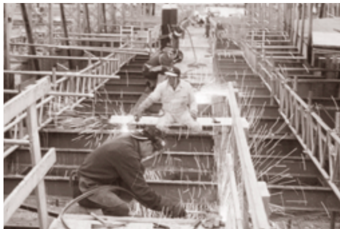
DURANTE LA INTERVENCIÓN
