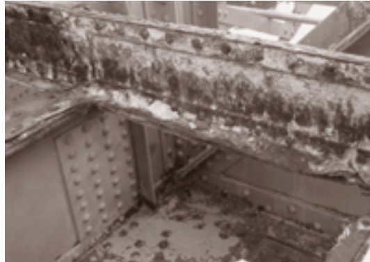
ANTERIOR A LA INTERVENCIÓN
