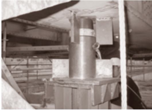
DURANTE LA INTERVENCIÓN
