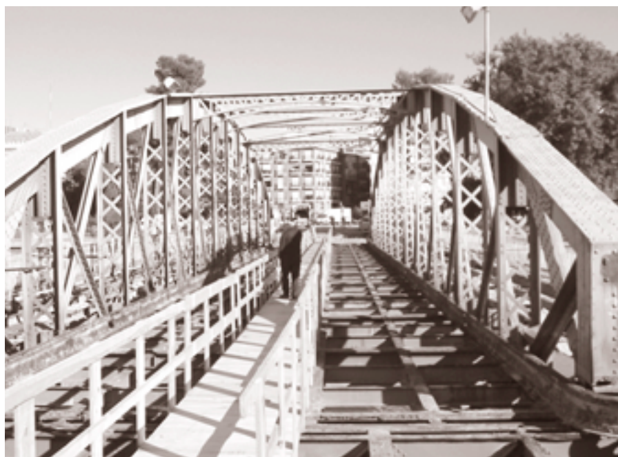
DURANTE LA INTERVENCIÓN
