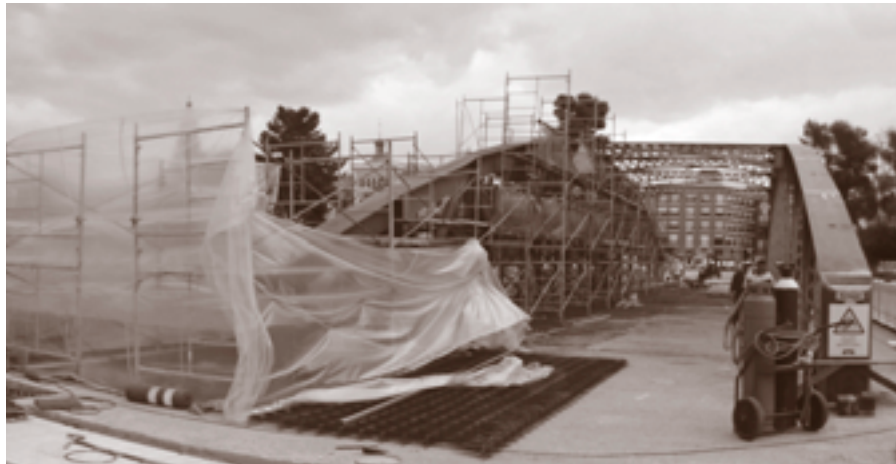
DURANTE LA INTERVENCIÓN
