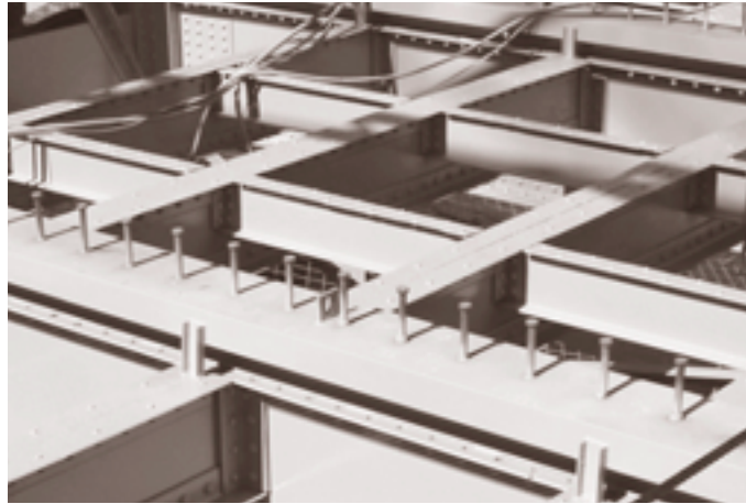
DURANTE LA INTERVENCIÓN
