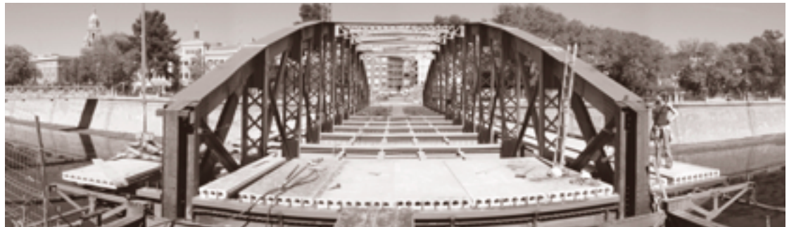
DURANTE LA INTERVENCIÓN
