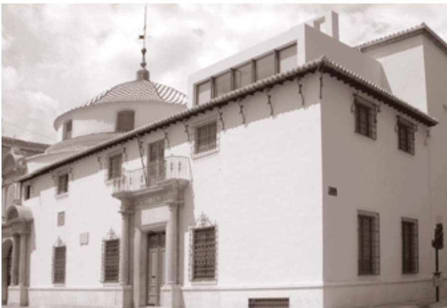
POSTERIOR A LA INTERVENCIÓN
