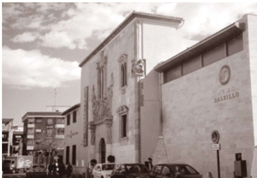
POSTERIOR A LA INTERVENCIÓN
