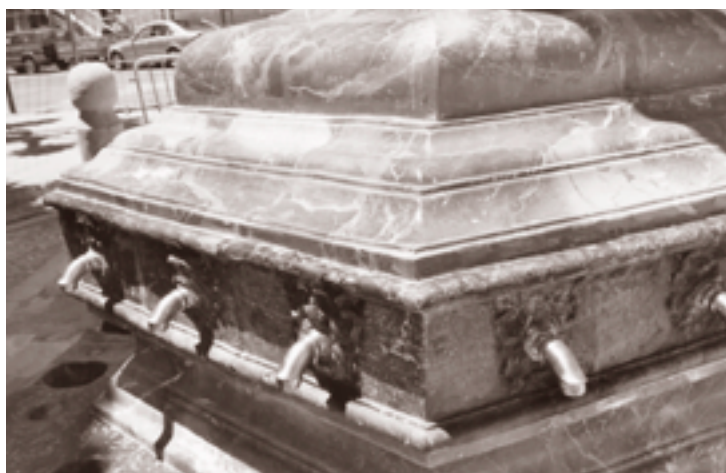
POSTERIOR A LA INTERVENCIÓN
