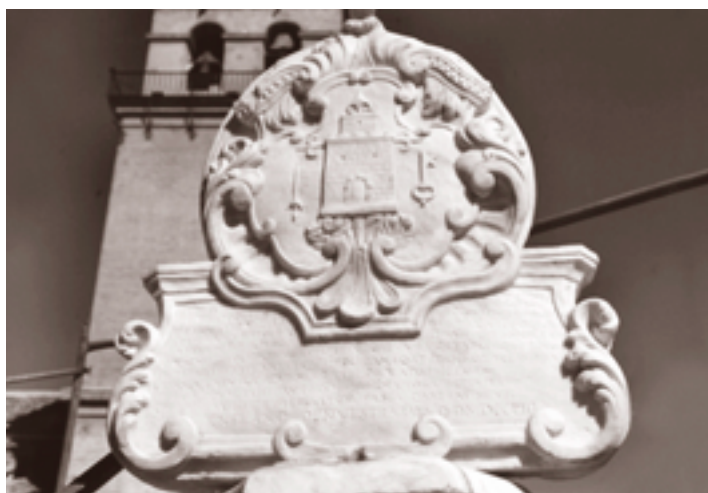
POSTERIOR A LA INTERVENCIÓN
