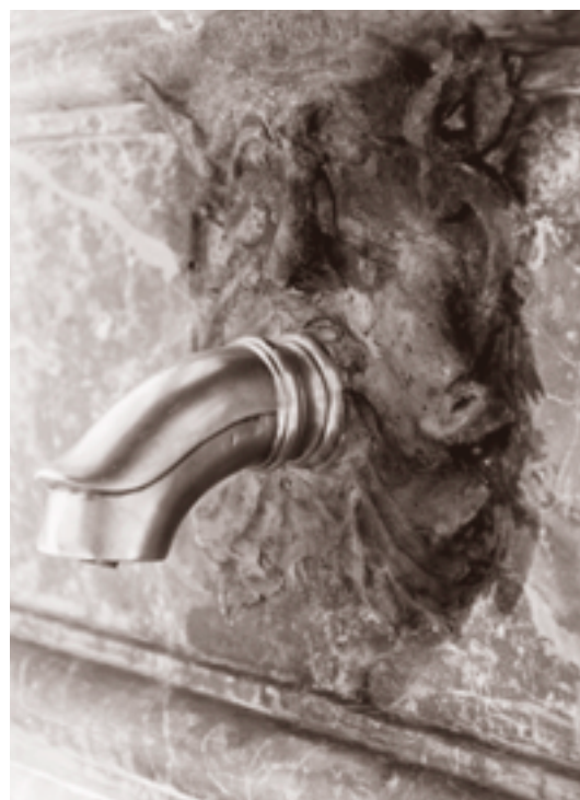
POSTERIOR A LA INTERVENCIÓN
