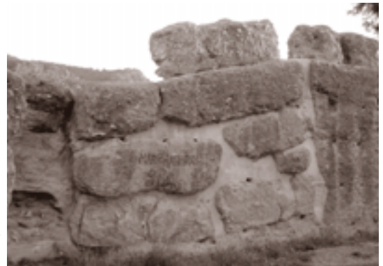
RELLENO DEL VACÍO ENTRE TAPIAS. POSTERIOR A LA INTERVENCIÓN
