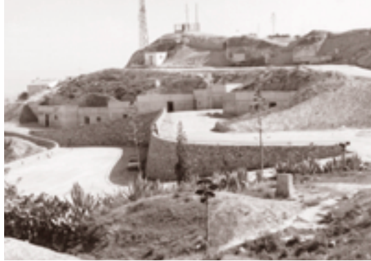
DURANTE A LA INTERVENCIÓN
