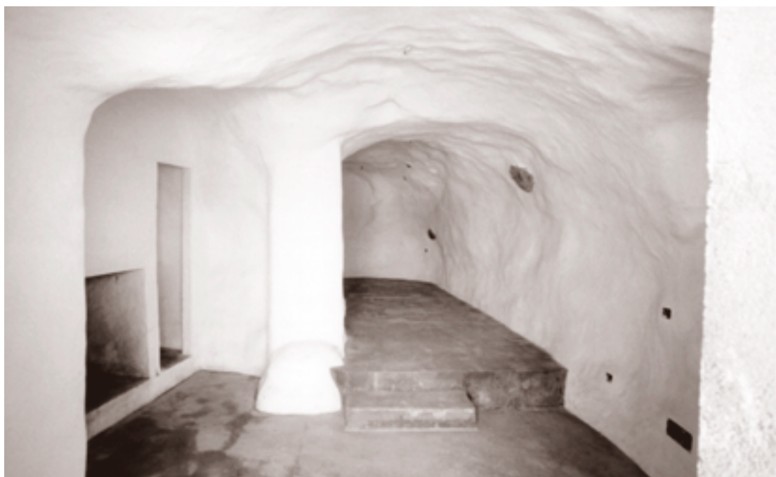
POSTERIOR A LA INTERVENCIÓN
