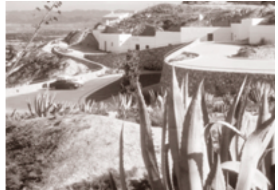
POSTERIOR A LA INTERVENCIÓN
