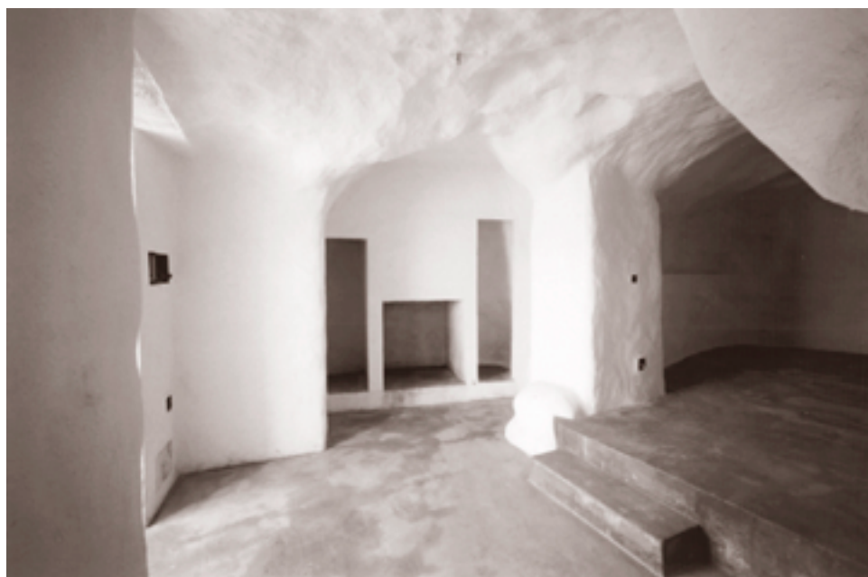
POSTERIOR A LA INTERVENCIÓN
