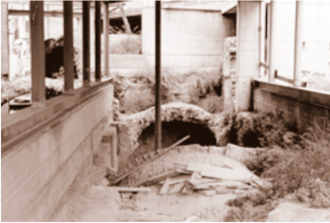
BAÑOS DE ALHAMA. ANTERIOR A LA INTERVENCIÓN
