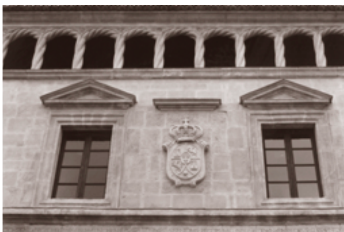
POSTERIOR A LA INTERVENCIÓN
