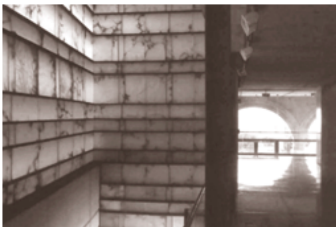
POSTERIOR A LA INTERVENCIÓN
