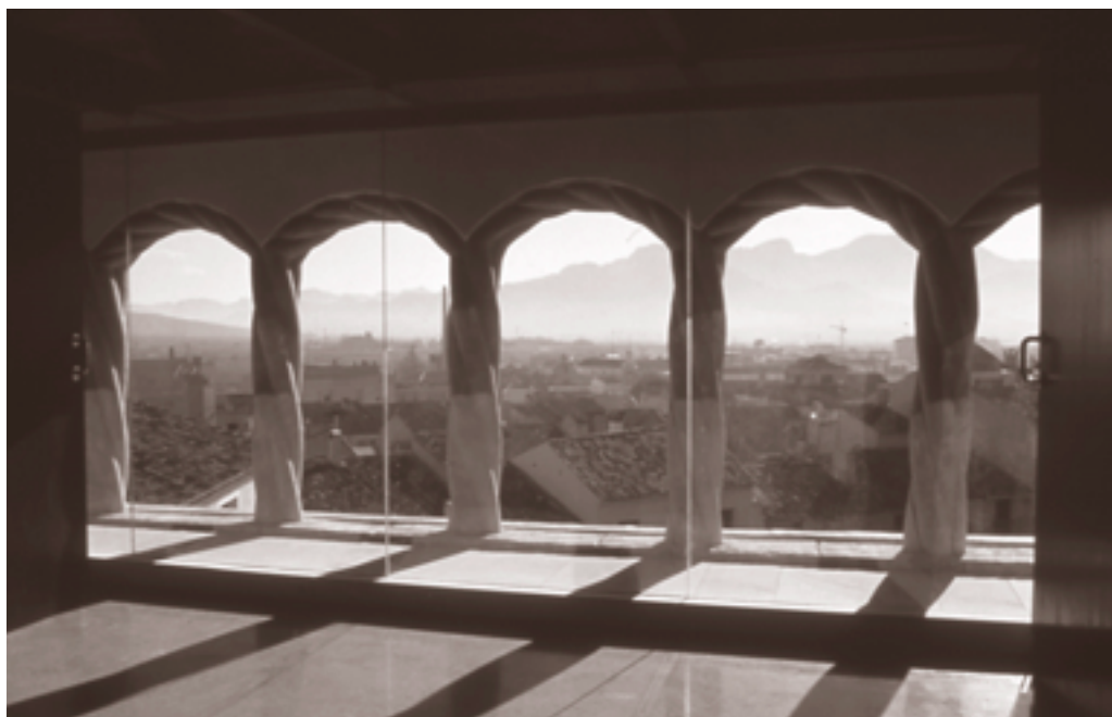
POSTERIOR A LA INTERVENCIÓN
