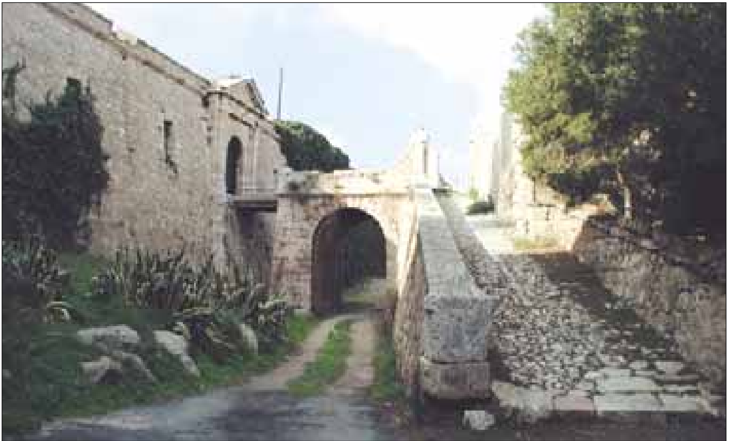
Rampa, foso, puente y puerta.
