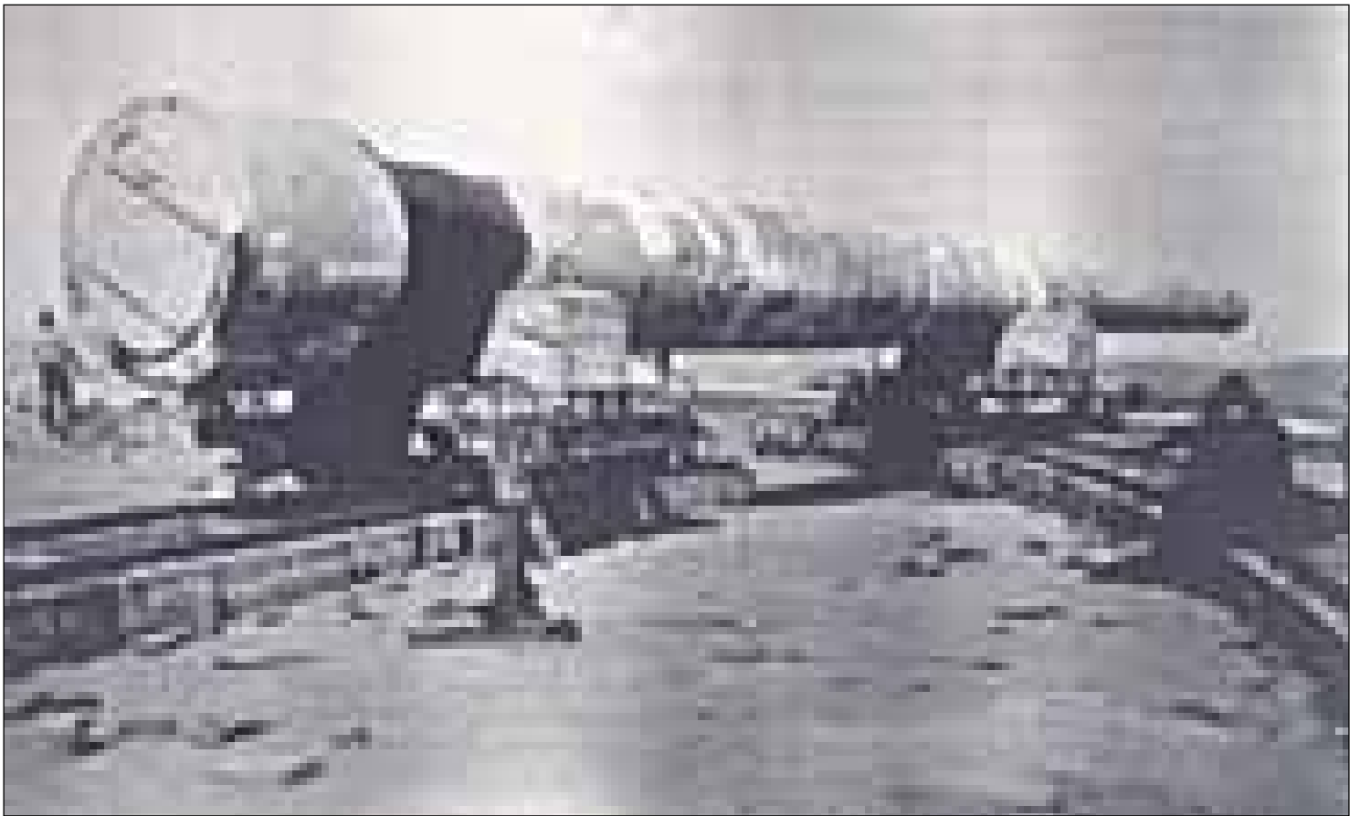
Detalle de la fase de montaje en la explanada.
