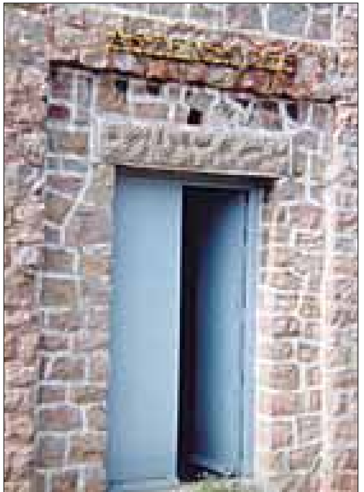
Detalle de la entrada a uno de los edificios de servicio.
