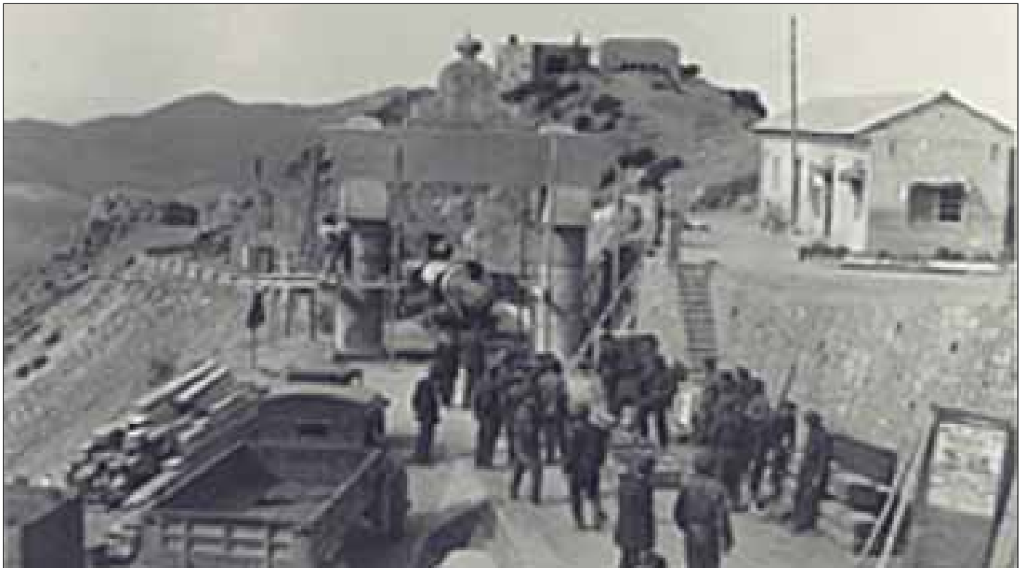
Detalle de la llegada de uno de los tubos a la batería para su montaje.
