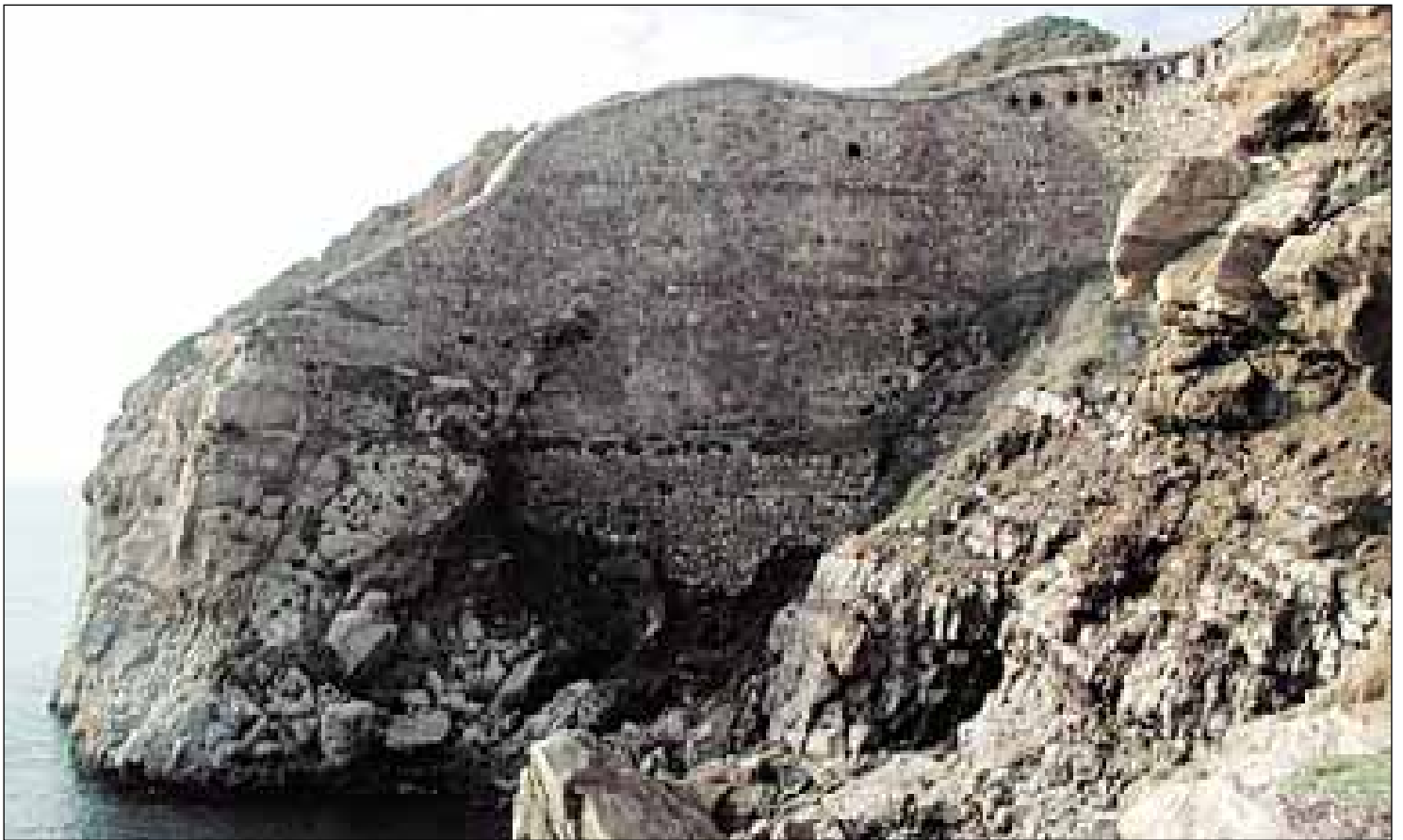
Muro para contener el lateral de la batería.
