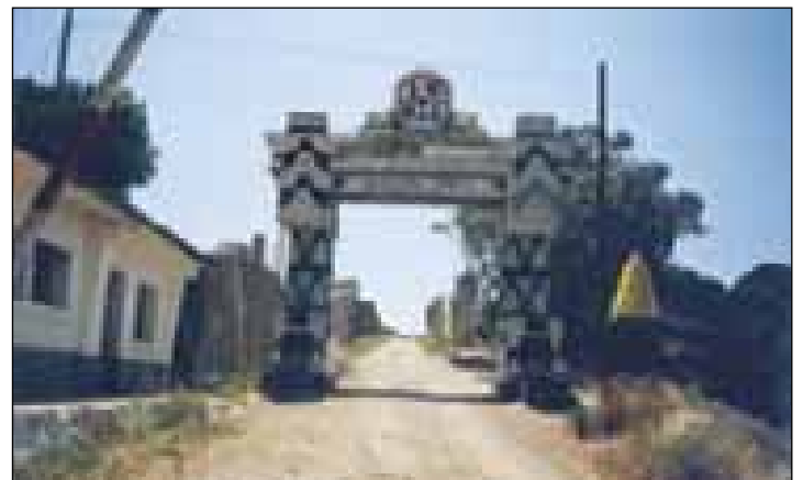
Detalle de la fachada del acceso principal.
