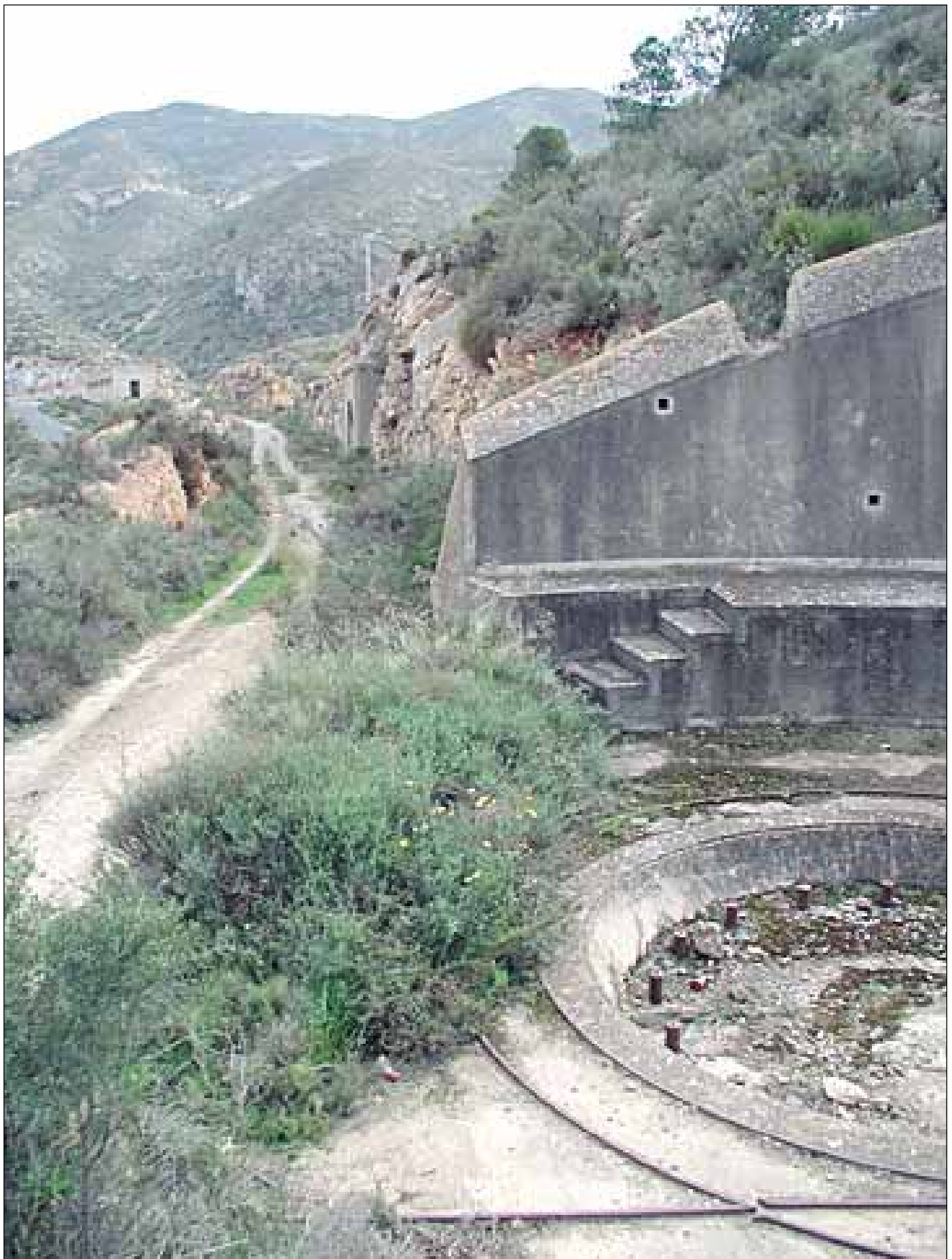
Acceso a la batería.
