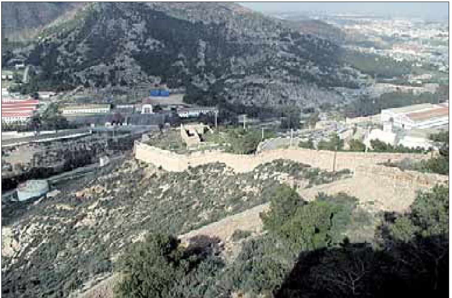
Tramo de muralla en el Monte de Galeras, detalle de un baluarte, con puerta al exterior y cuerpo de guardia en su interior.
