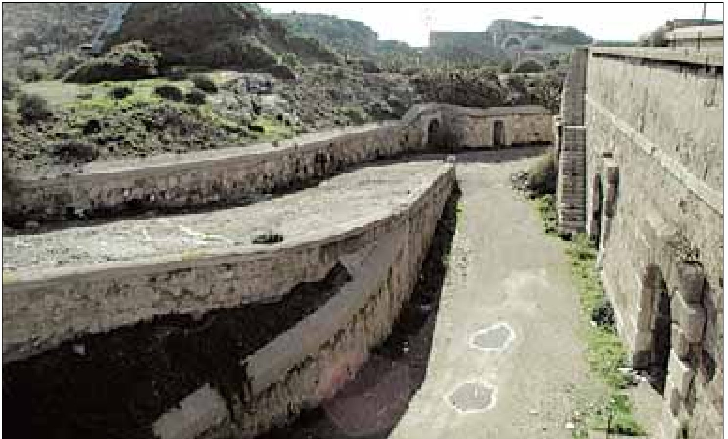
Detalle de los accesos a los polvorines.
