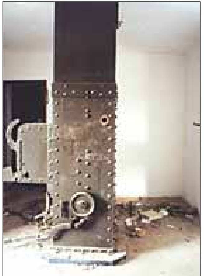
Detalle de un ascensor de munición.
