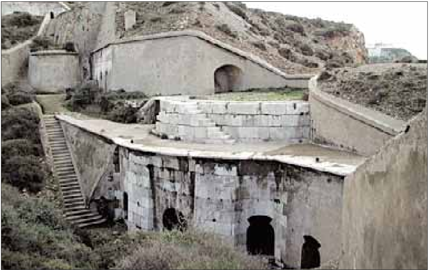
Detalle del asentamiento de una pieza.
