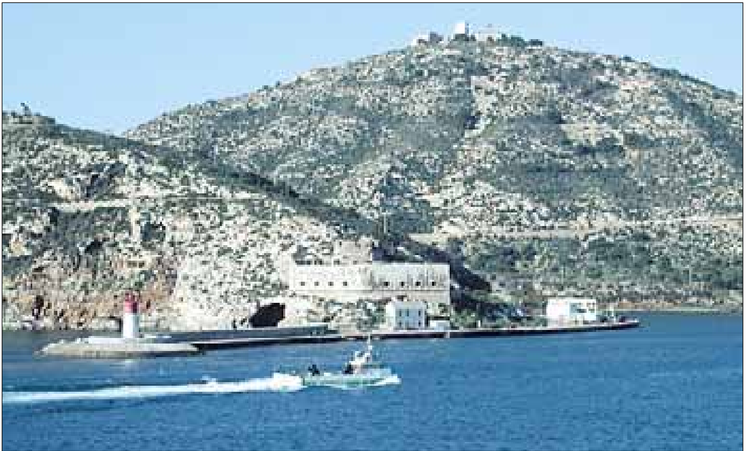
Vista general donde se observa su ubicación.
