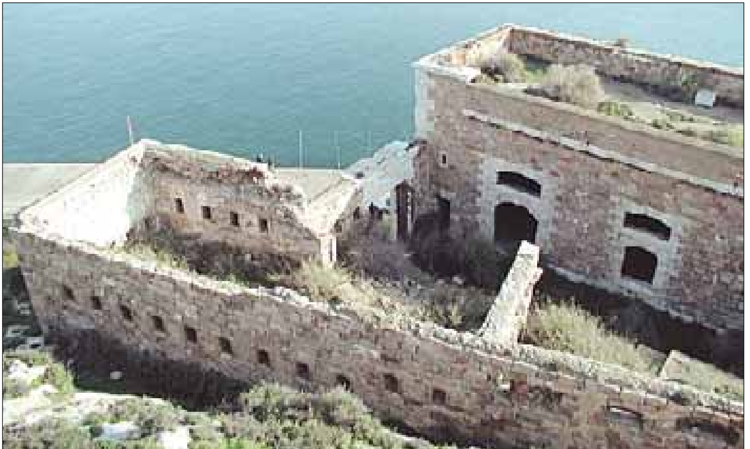
Detalle del acceso y de las aspilleras para fusileros.
