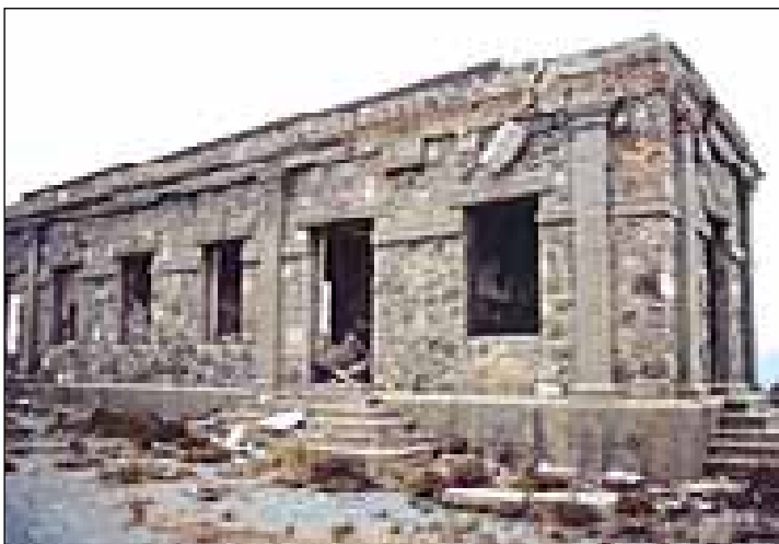
Detalle del estado actual de uno de los edificios auxiliares.
