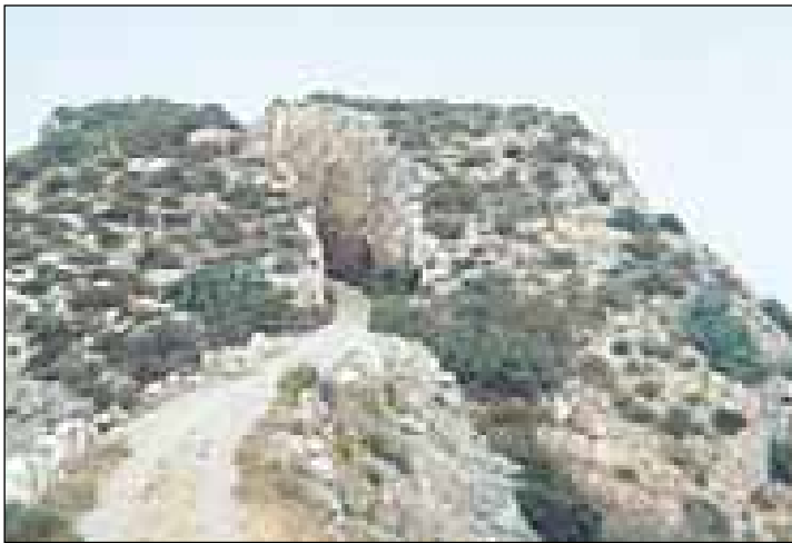
Detalle del monte seccionado para construir la carretera de acceso.
