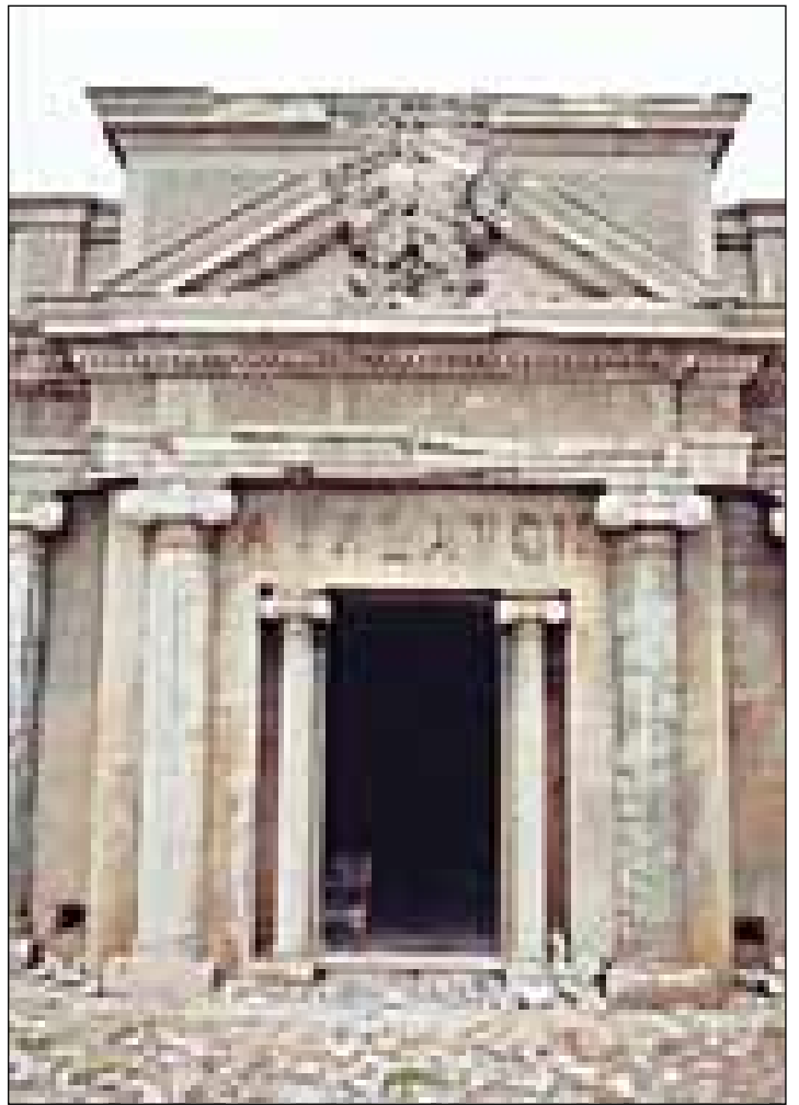
Detalle del acceso al edificio principal.
