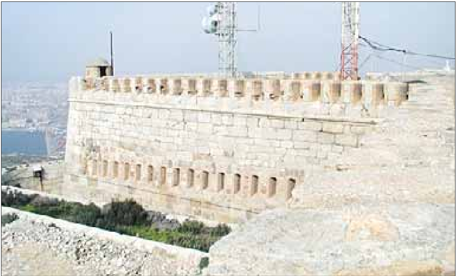
Aspilleras para fusiles en el flanco del acceso.
