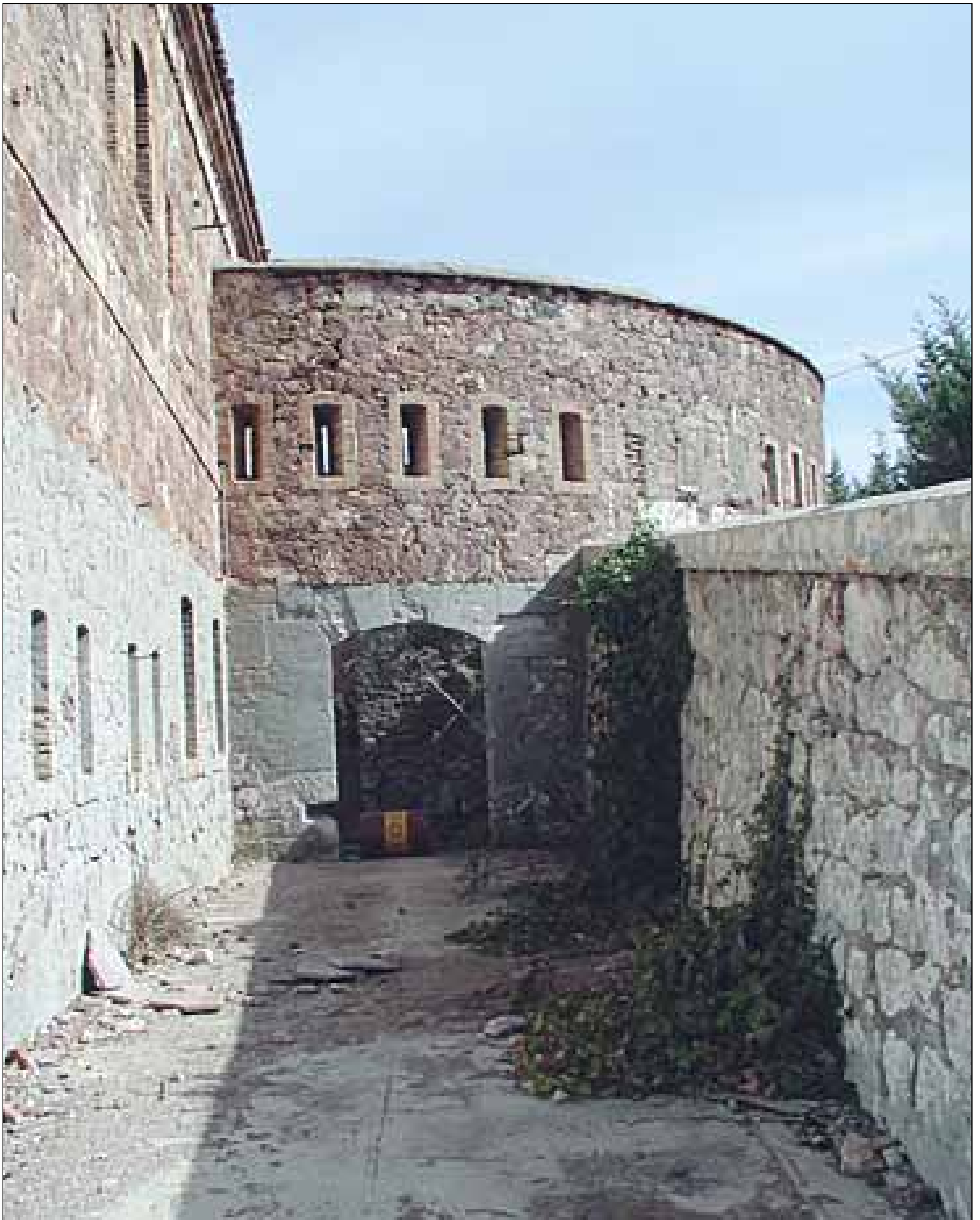
Tambor donde se sitúa el acceso acodado al Cuartel defensivo.
