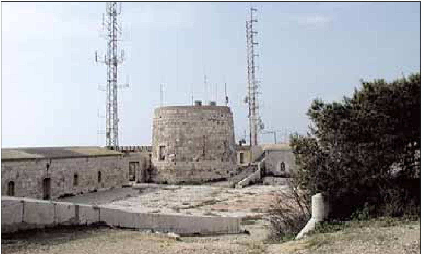
Patio y torre circular.
