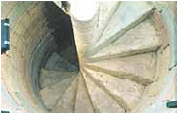
Escalera de acceso a la planta superior del «Macho».
