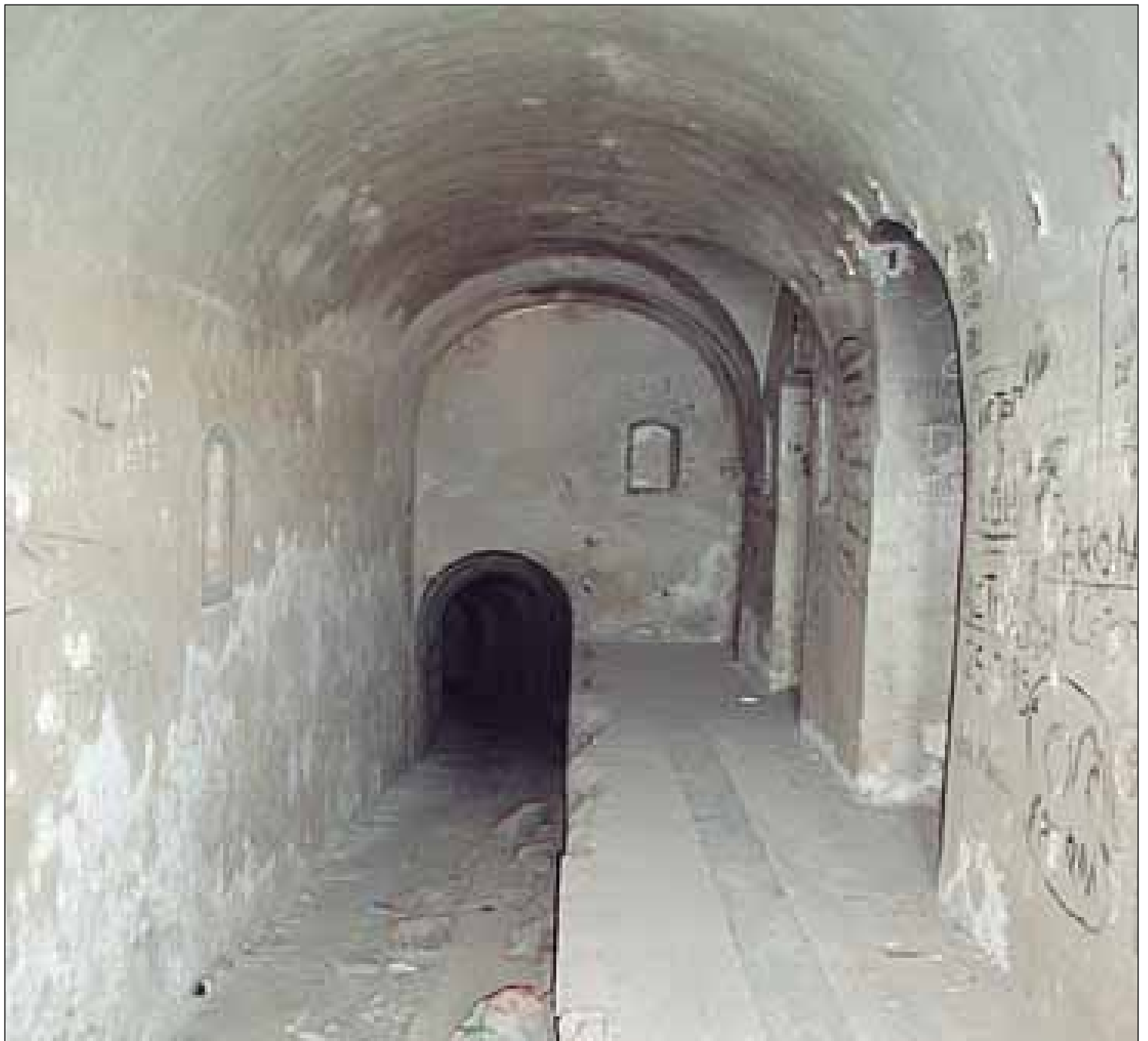
Comunicación entre el polvorín y la batería mediante túnel.
