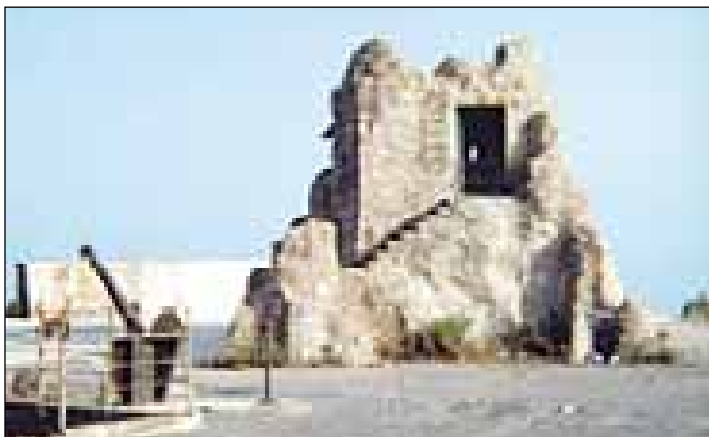
Detalle de uno de los puestos de mando.
