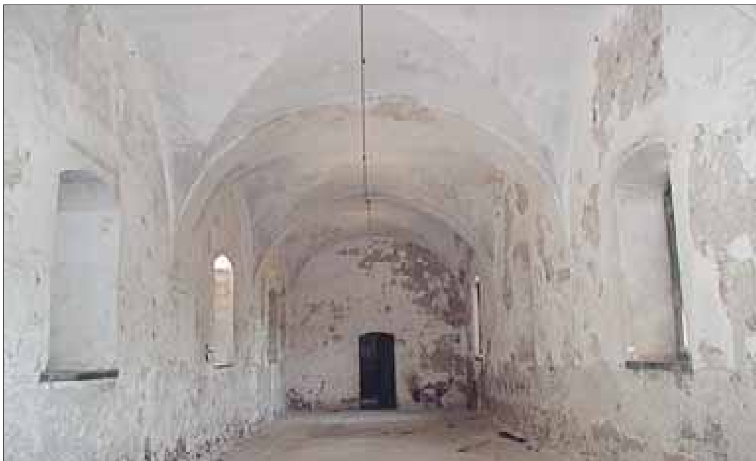
Detalle cubiertas planta inferior Cuartel defensivo.
