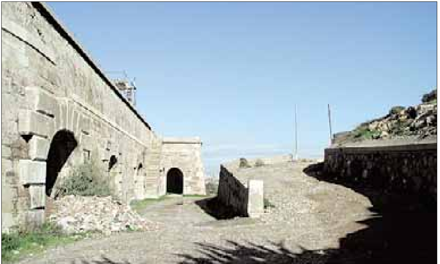
Detalle del acceso a las casamatas.
