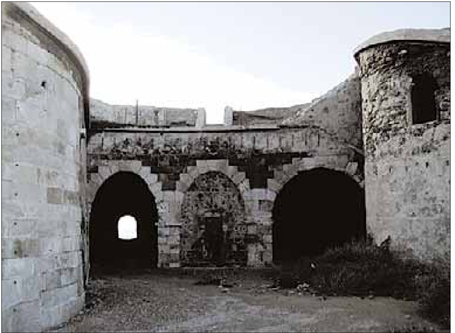
Interior detalle de las casamatas por la gola.
