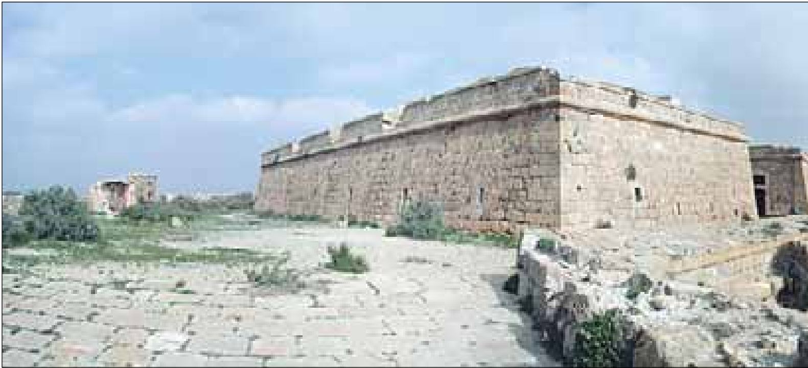
Edificio central con bóvedas a prueba.
