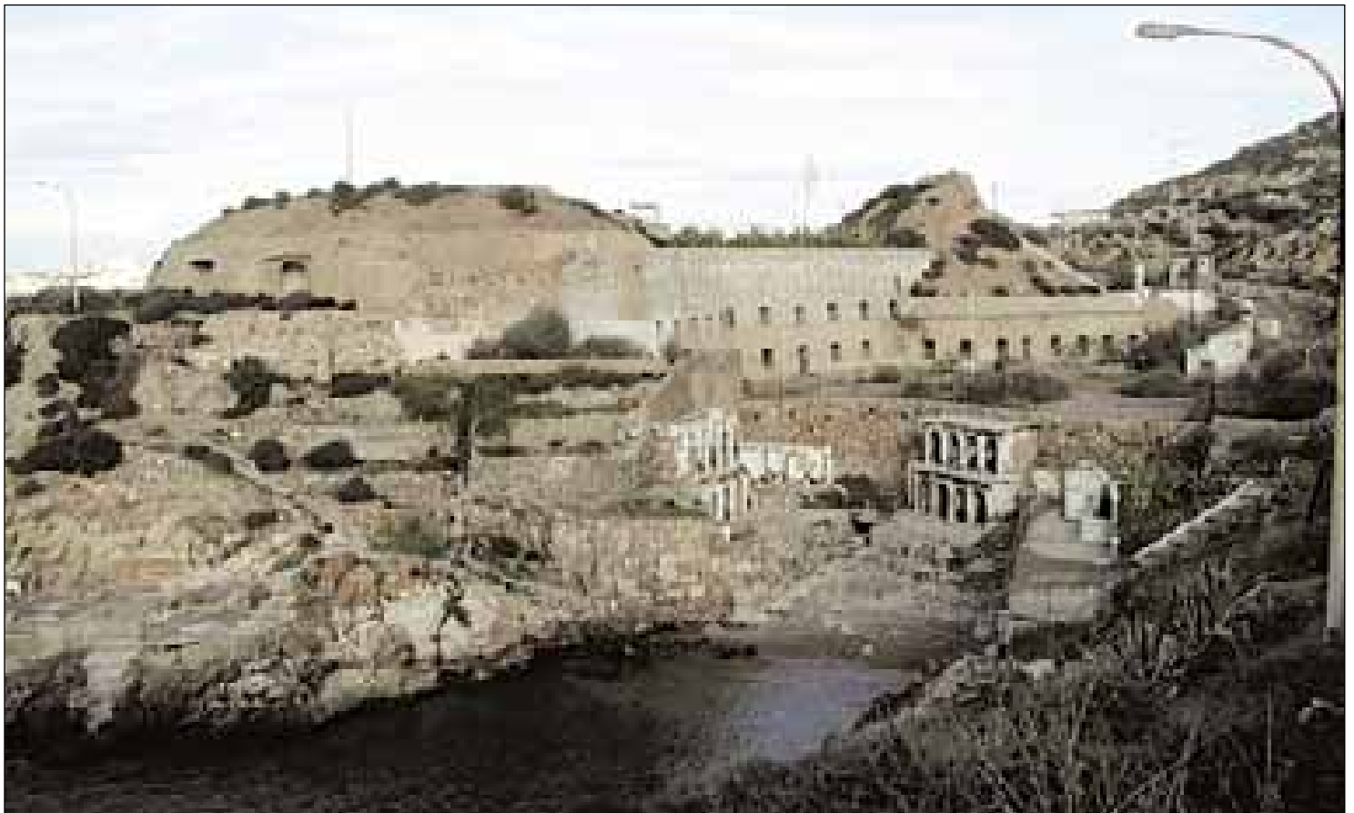
Vista general desde Santa Ana Acasamatada.
