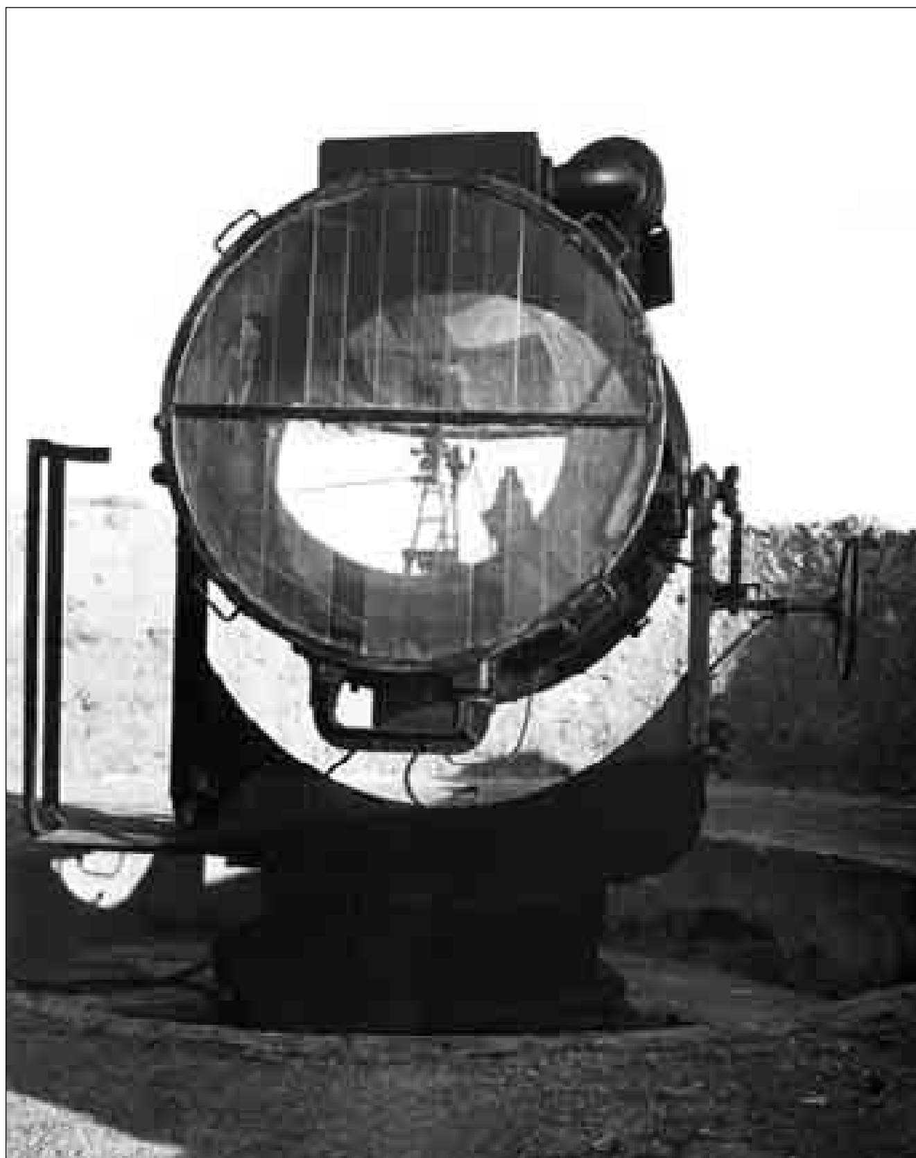
Lám. 152: Para el tiro nocturno las baterías se sirvieron de potentes focos como este, un proyector de 105 cm de diámetro para costa.
