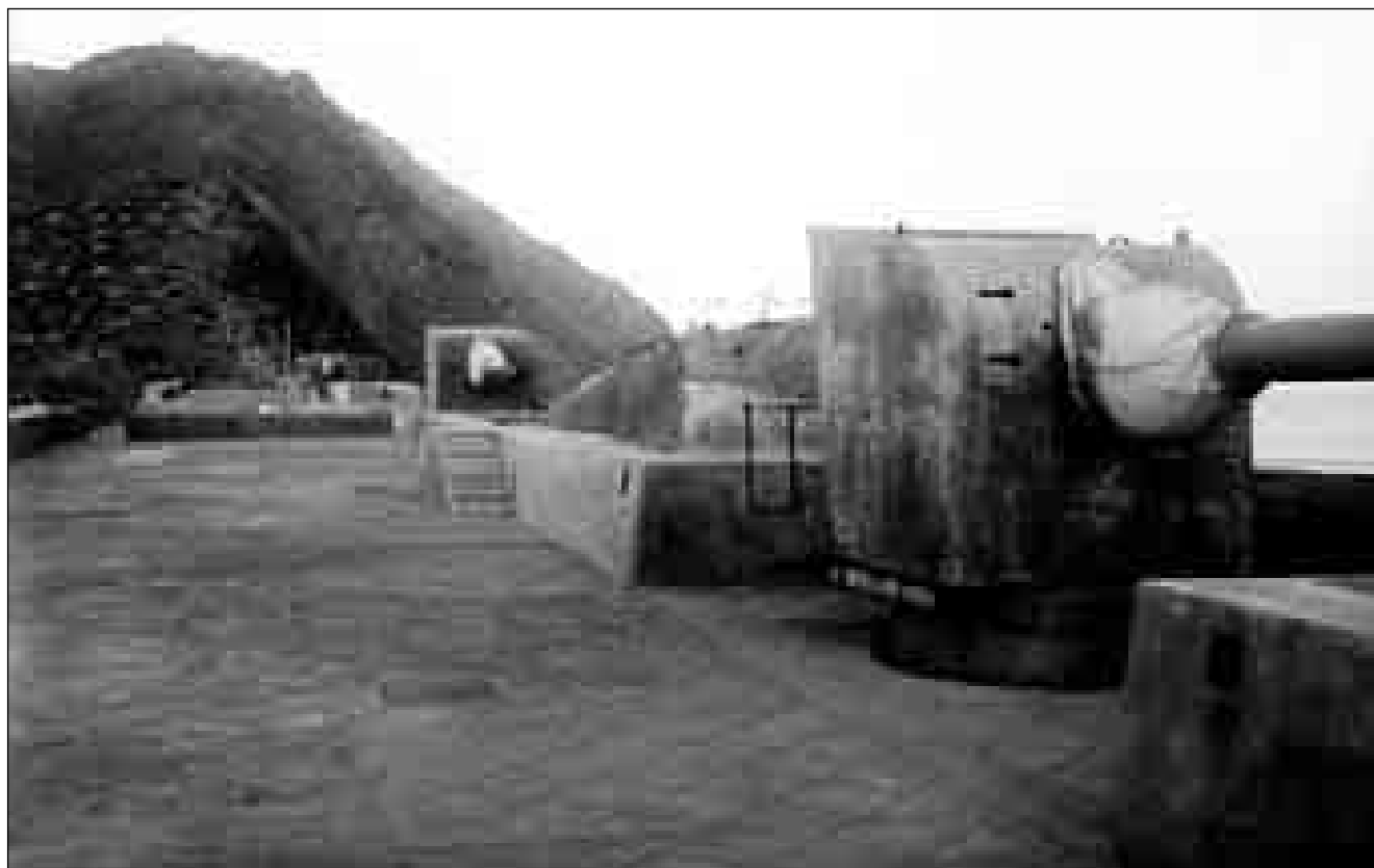
Lám. 119: Magnífica imagen de las piezas de 15'24 recién montadas en La Chapa.
