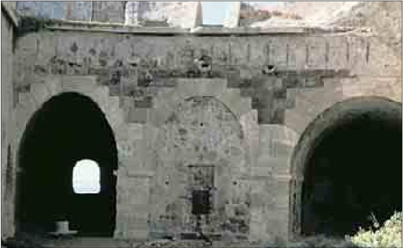
Lám. 27: No obstante de cubrir las piezas, las baterías expuestas al fuego enemigo, en montaje de costa, debían de quedar convenientemente ventiladas por la gola, pues pocos disparos hacían falta para colmatar el espacio donde se encontraba la pieza que había hecho fuego. En la imagen, los accesos posteriores a los cuartos donde se instalaron los cañones en Santa Ana Acasamatada.
