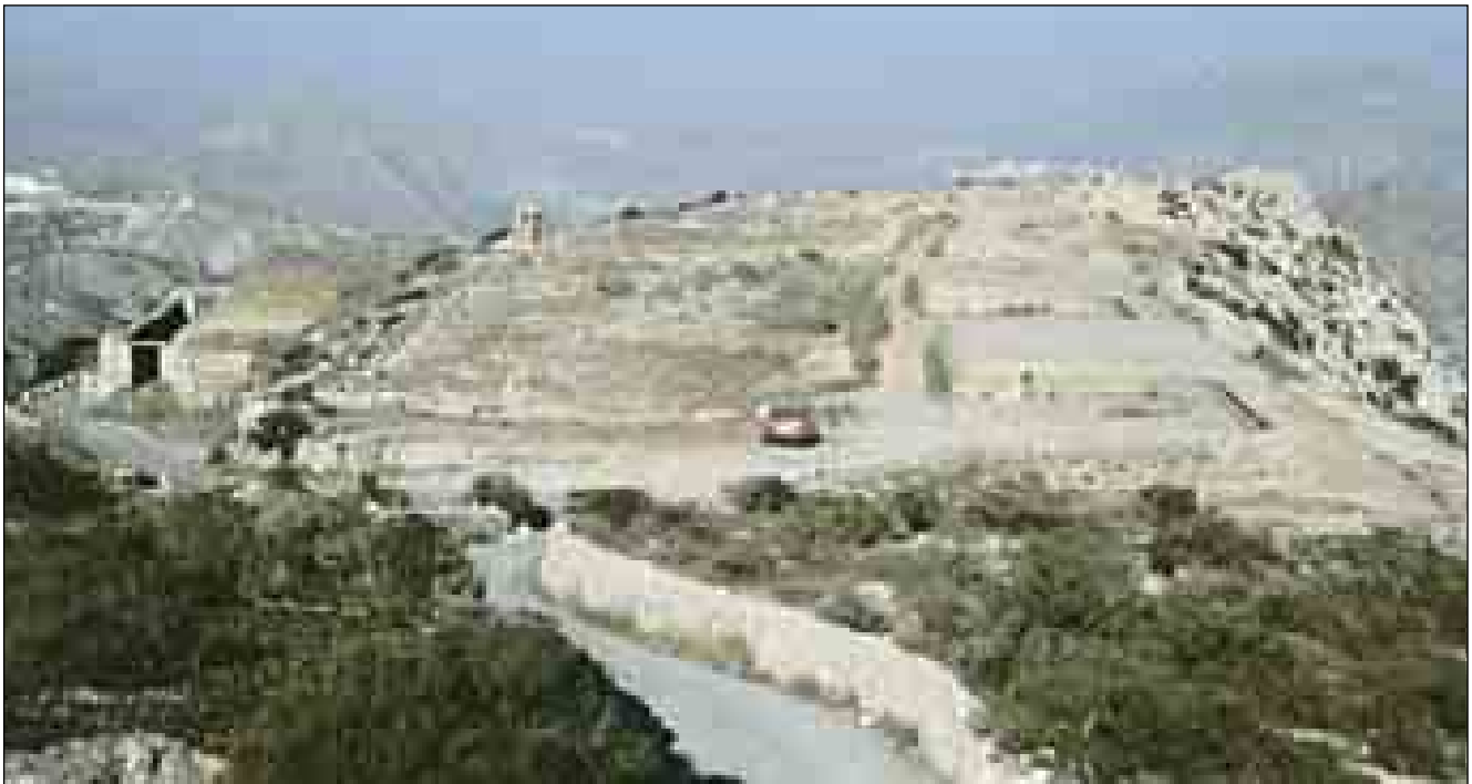
Lám. 67: Muy poco después de la terminación del fuerte de San Julián se vería que su valor militar era ya, como mínimo, muy limitado. Así, al construirse a la sombra de su cara sureste la batería General Ordóñez, el castillo quedaría como su acuartelamiento. En esta batería se construyeron emplazamientos a barbata dobles para situar obuses.
