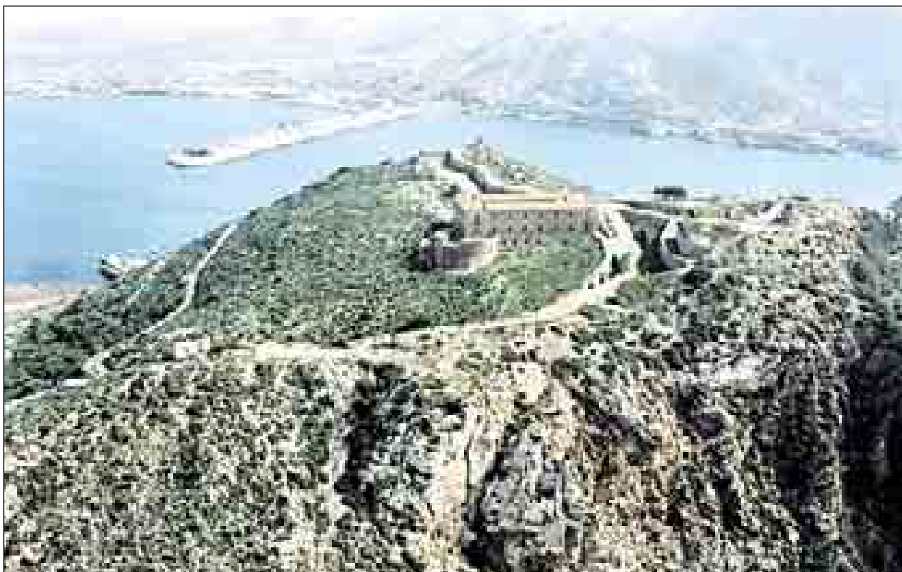
Lám. 22: Sin duda el Cuartel Defensivo Fajardo constituye hoy, junto a Despenaperros y San Julián, el edificio más representativo de los sistemas arquitectónicos militares del siglo XIX español, y, sin duda, una de las construcciones más bellas de Cartagena. Un gran edificio cuadrangular de dos órdenes y elevado sobre un semisótano, se articula en torno a un gran patio central. En dos vértices opuestos del cuadrilátero se levantan sendos tambores aspillerados que flanquean sus muros.
