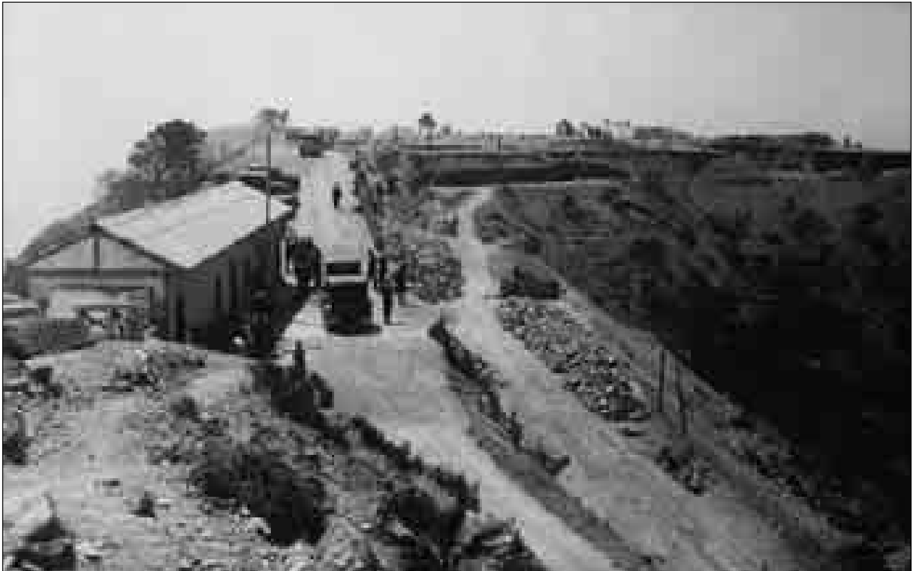
Lám. 110: Finalmente se llegaba a las alturas del monte de Cenizas. Entonces comenzarían las explanadas y las variadas construcciones que servirían a las piezas.
