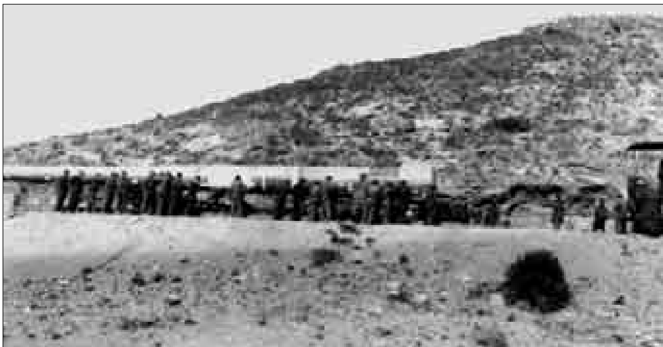
Lám. 93: Otra instantánea del transporte de las piezas del 38'1. Si dura era la subida, la bajada era más peligrosa. Tirando del tubo, La Cotorruela . Nótese la cantidad de operarios y trabajadores que requirieron las obras.
