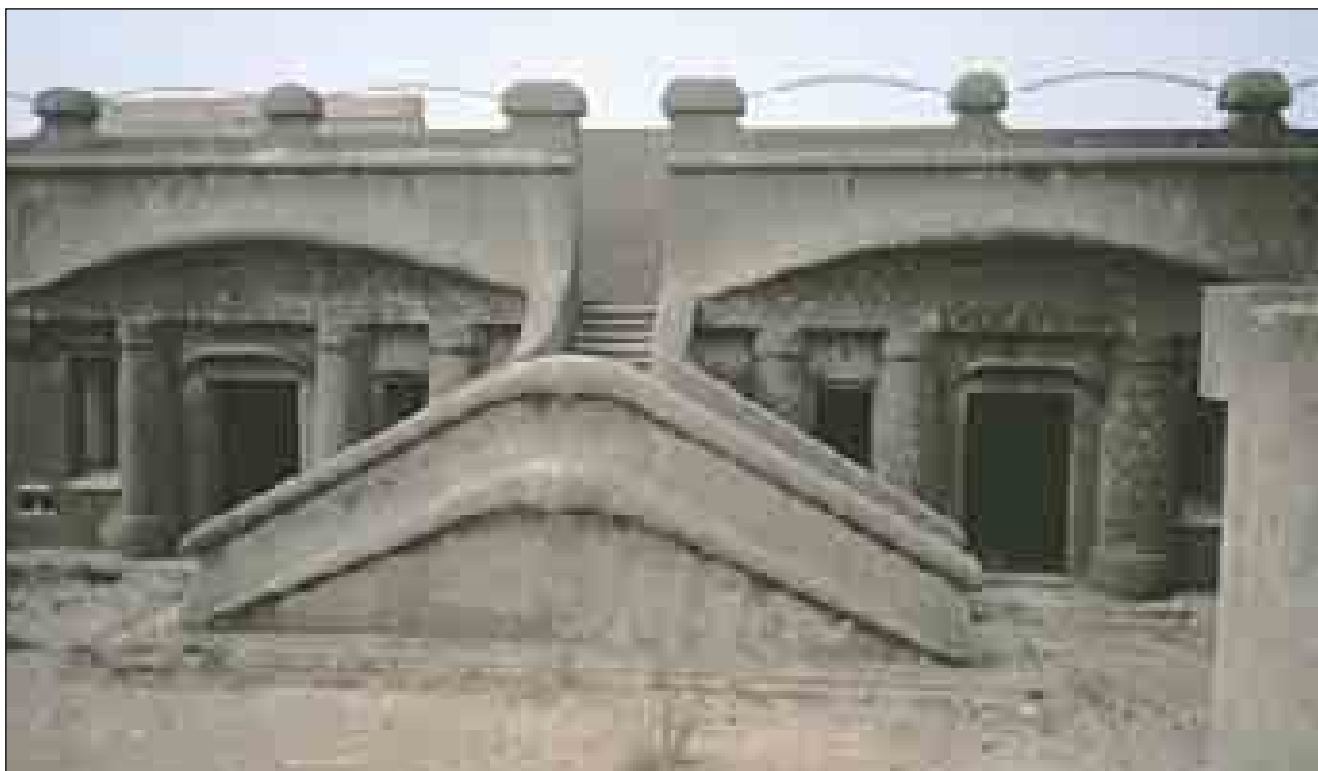
Lám. 176: La batería antiaérea de Roldán fue finalmente desartillada conforme a la reorganización Menéndez Tolosa , a partir de 1965, tras treinta y cinco años formando parte del despliegue contra aviones de la Base Naval. Sus espléndidas edificaciones, paradigmas del modernismo en las construcciones militares, aún se mantienen en pie.
