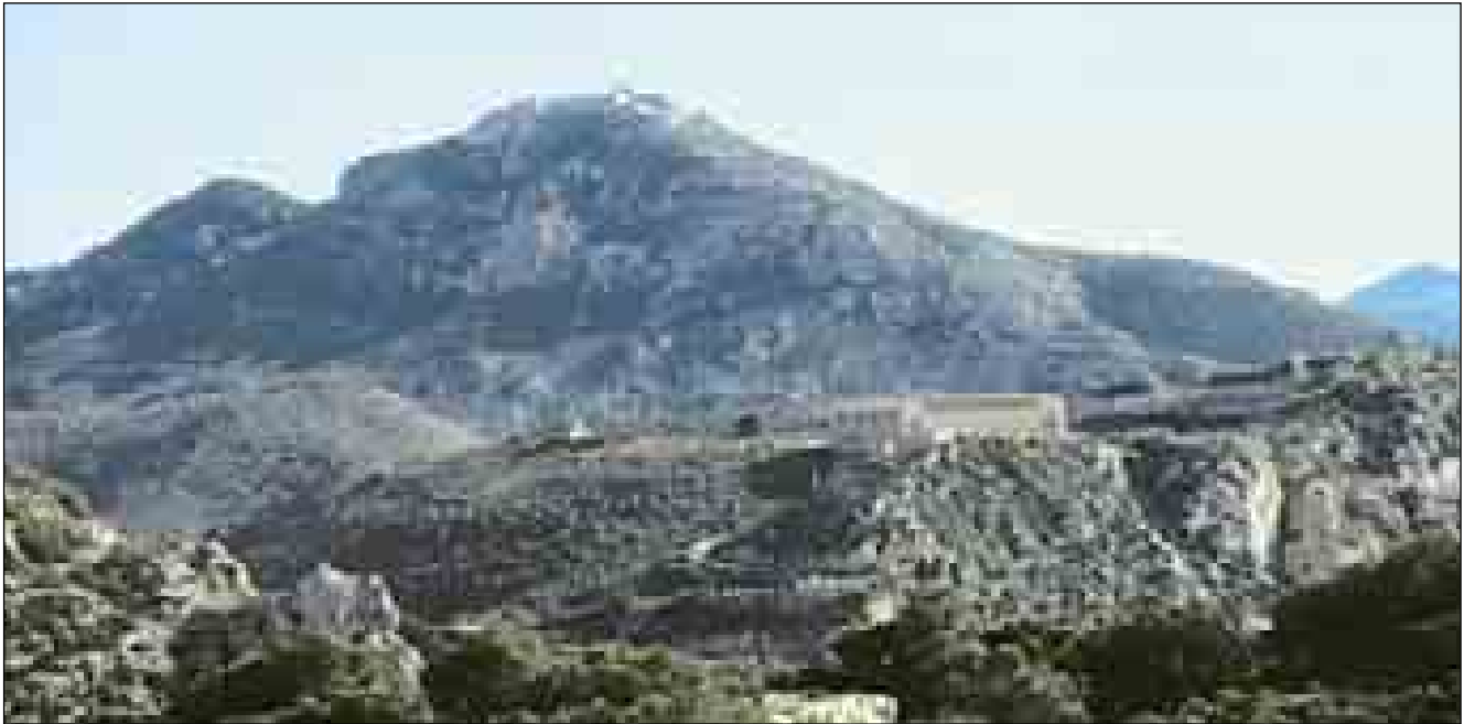
Lám. 16: La preocupación fundamental del Plan de Defensa de 1860 fue que, en principio, se cubriese el frente marítimo. Y una de las obras que dieron comienzo fue el fuerte de San Julián, cuyo proyecto se remontaba al siglo anterior.
