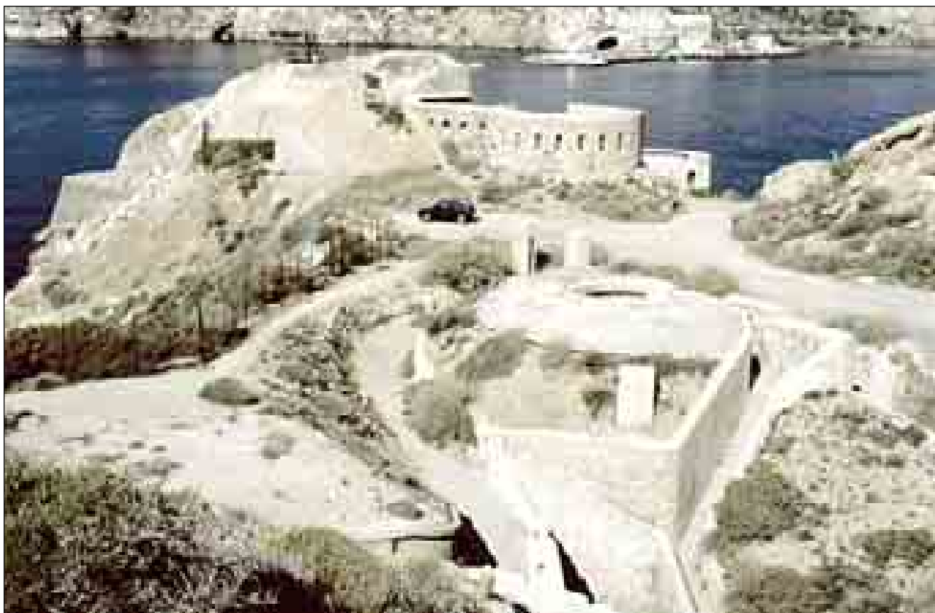
Lám. 44: A unas cotas de 29 y 18 metros sobre el nivel del mar, se montaron, sin dirección de tiro, los dos Krupp 30'5 en Santa Ana Complementaria. Adquiridos en 1888, sirvieron a la fábrica de pólvora de Murcia para experimentar los modernos propelentes sin humo.
