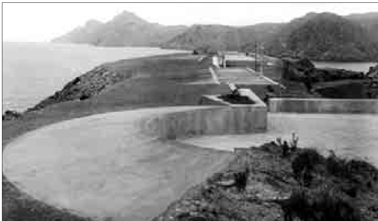
Lám. 118: Como baterías secundarias a las del 38'1 de Portmán, se establecieron en La Chapa las cuatro piezas Vickers de 15'24, en la imagen a la espera de su montaje.
