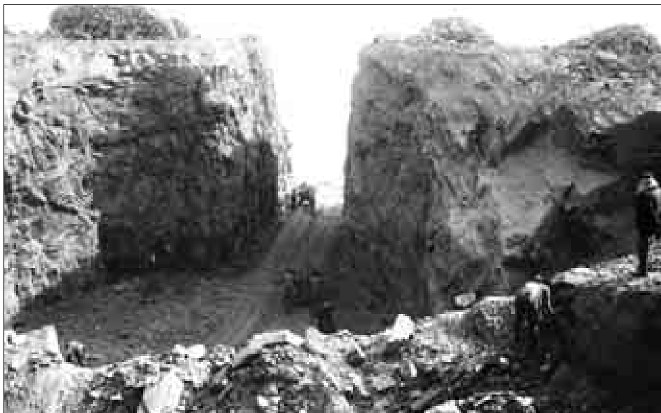
Lám. 112: Otro de los grandes vaciados de material lo constituyó la construcción de los pozos donde se instalarían las piezas.
