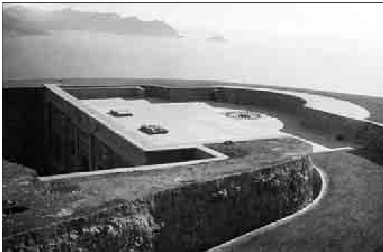
Lám. 98: Las obras fueron extraordinariamente complejas, pues requerían de infinidad de desmontes y túneles para establecer las dependencias. Véase el emplazamiento de uno de los 15'24 de La Parajola recién terminado.
