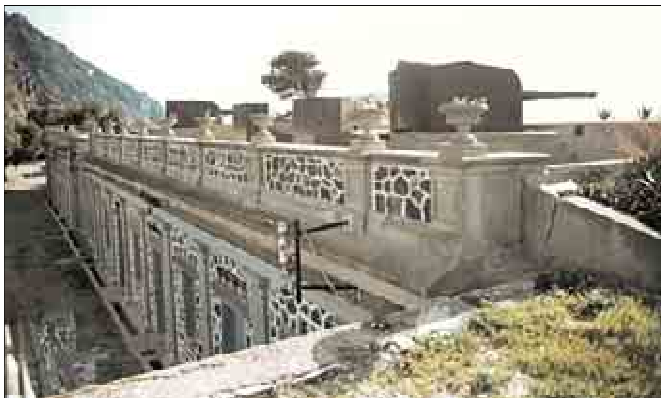
Lám. 158: La batería de La Chapa, poco antes de su desartillado, armada con sus cañones Vickers con su carapacho cerrado. Se aprecian también, detrás de las piezas, los ascensores de municionamiento.
