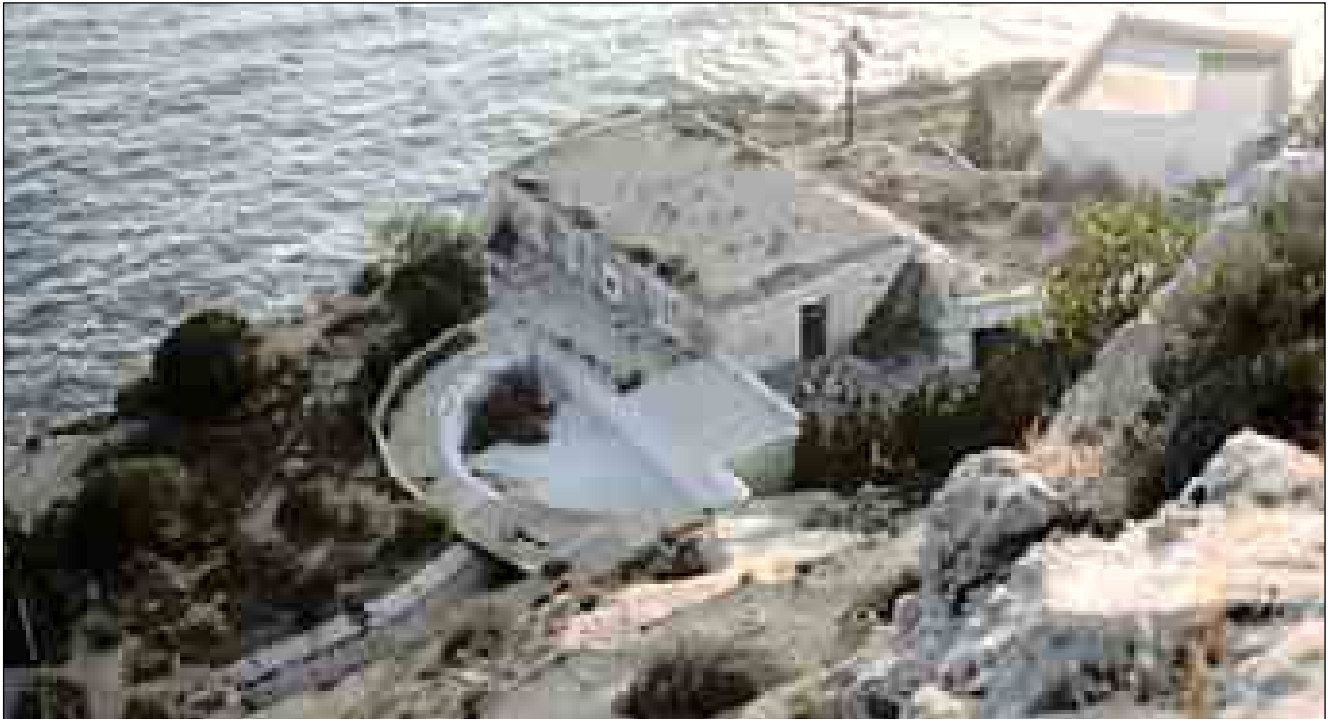
Lám. 46: En Trincabotijas Baja se montaron los otros dos cañones Krupp 30'5, en este caso modelo 1887 de giro central, en 1898, sobre una cota de 50'3 m. Las piezas fueron desmontadas en 1942 y trasladadas a Tarifa, donde fueron emplazadas en la batería del Palmero. Desde febrero de 1960, Trincabotijas Baja está afecta a la Armada, donde se estableció la estación desmagnetizadora.
