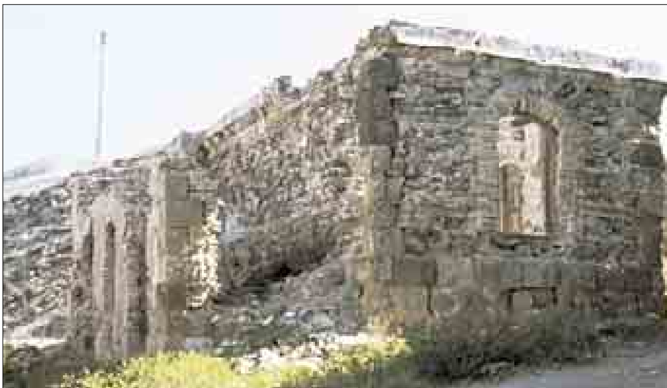
Lám. 50: En la actualidad, el conjunto del complejo defensivo establecido a las faldas de San Julián presenta un regular estado de conservación por los años que lleva abandonado. No obstante, la proliferación de edificios auxiliares que requirieron estas baterías, ha dado lugar a que ciertas zonas presenten una ruina casi total, con un grado de mantenimiento lamentablemente bajo.
