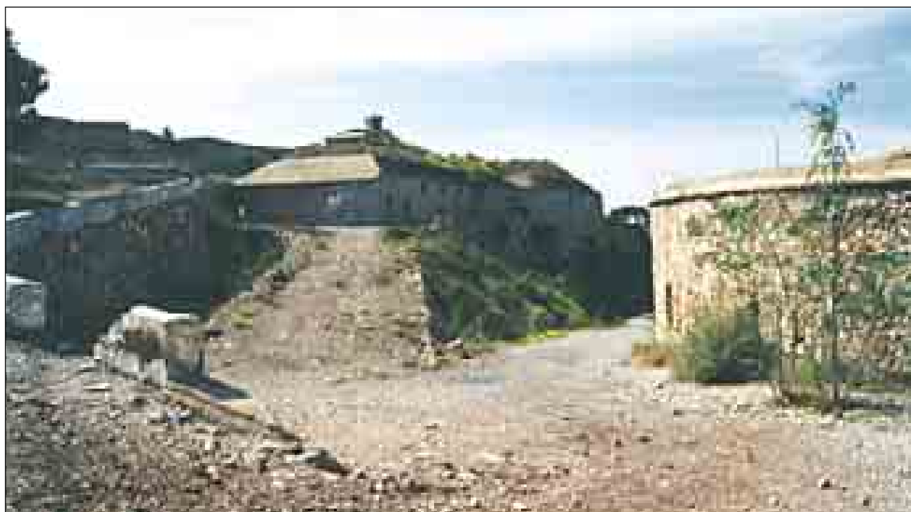
Lám. 55: Las baterías del complejo defensivo de Fajardo, artilladas con el material Ordóñez, se establecieron todas a barbata, y sus dependencias (polvorines, túneles, etc.) quedaron soterradas y abiertas mínimamente por la gola.
