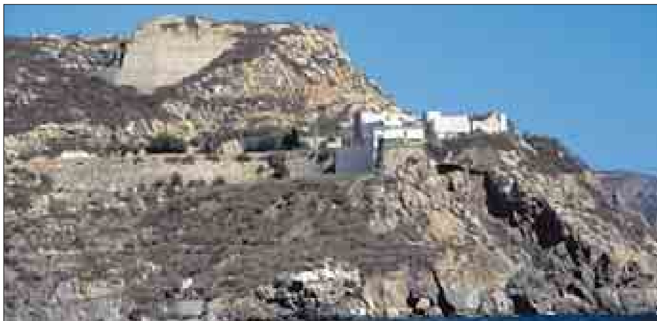
Lám. 31: Una de las baterías de costa más antiguas de Cartagena, organizada en Alta y Baja, Trincabotijas continuó cumpliendo su vela en la entrada del puerto tras la aplicación del Plan de Defensa de 1860.
