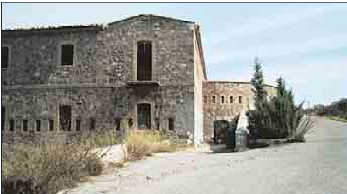
Lám. 72: Detalle de la puerta al Cuartel Defensivo Fajardo, a la que se llegaba tras recorrer un pasillo asfáltico al frente y a la izquierda. El acceso, en recodo, se efectuaba a través del tambor.
