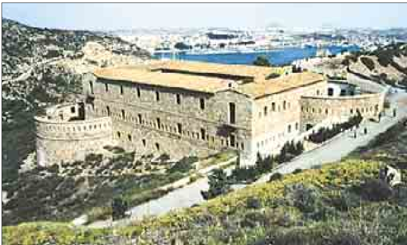
Lám. 37: No es difícil encontrar semejanzas en el estilo de las construcciones militares levantadas a mediados del siglo XIX en Cartagena, construidas con un estilo sobrio, clásico y original. En este caso, el magnífico Cuartel Defensivo Fajardo, con sus dos tambores aspilleros.
