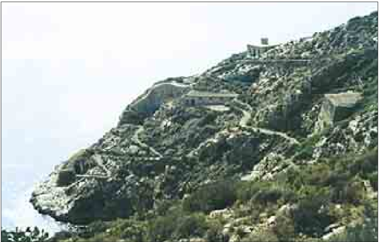
Lám. 68: Hasta el fin de la Guerra Civil estuvo artillada esta batería con las viejas piezas Krupp, bajo el faro de La Podadera. Obsérvese el aljibe para la recogida y almacenamiento de las aguas pluviales de escorrentía a la derecha de la imagen.
