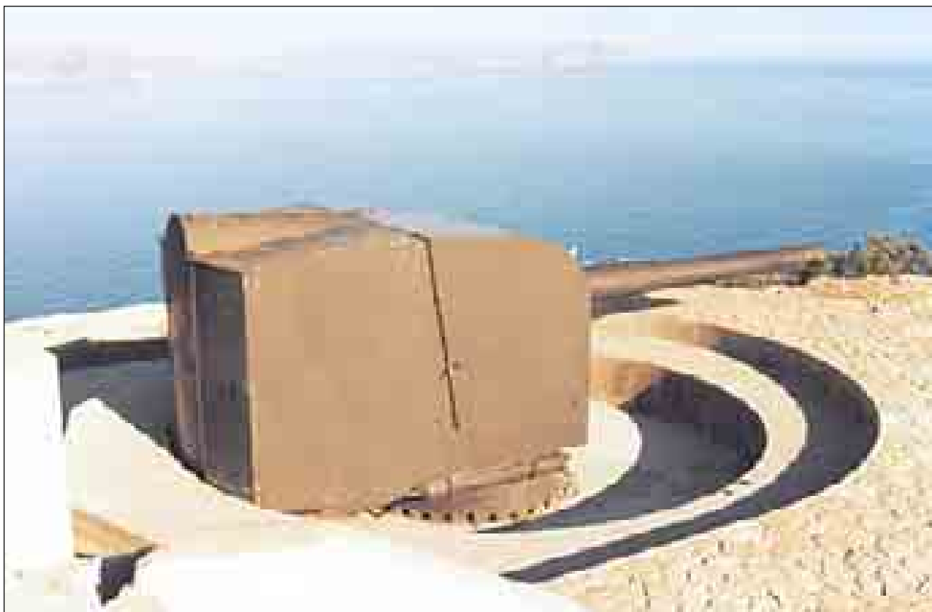
Lám. 182: Lo cierto es que, para la defensa de la Plaza, la artillería de tubo había dejado de tener sentido desde hacía mucho tiempo. El Vickers 15'24 de El Jorel, aún vela la costa.
