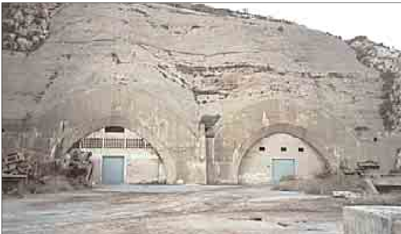
Lám. 169: Los búnkeres del Despalmador, que iban a constituir una base protegida para los submarinos, estuvieron, como poco, influidos por la tecnología alemana, que era con la que, en teoría, habría de construirse la flota submarina española tras la Guerra Civil. Los dos túneles, en los que a la postre no entró ni submarino ni agua, tienen unos cien metros de profundidad y están unidos en su sector bajo la roca. Hoy día funcionan como almacén de Marina y enmarcan un desguace provisional que termina por romper el descuidado aspecto de la zona.
