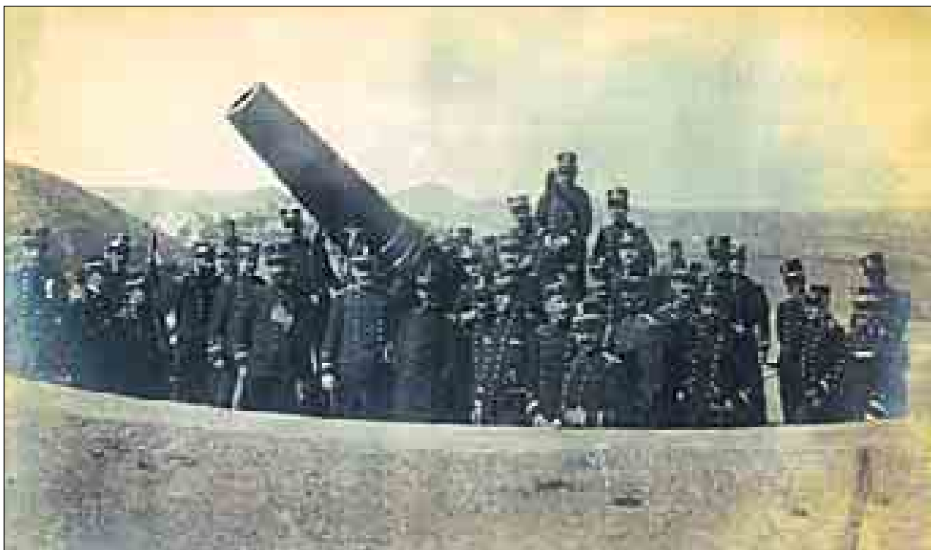
Lám. 51: Los obuses resultaban el complemento necesario a los cañones, pues por lo general cumplían unas funciones contra los buques que los cañones no realizaban, gracias a su sistema de tiro curvo, cubriendo ángulos muertos bajo las propias baterías y perforando verticalmente las corazas de los buques. La imagen, un grupo de militares a comienzos del siglo XX fotografiados con lo que parece un obús de hierro sunchado Ordóñez modelo 1891 de 21 cm, establecido en la batería de Fajardo.
