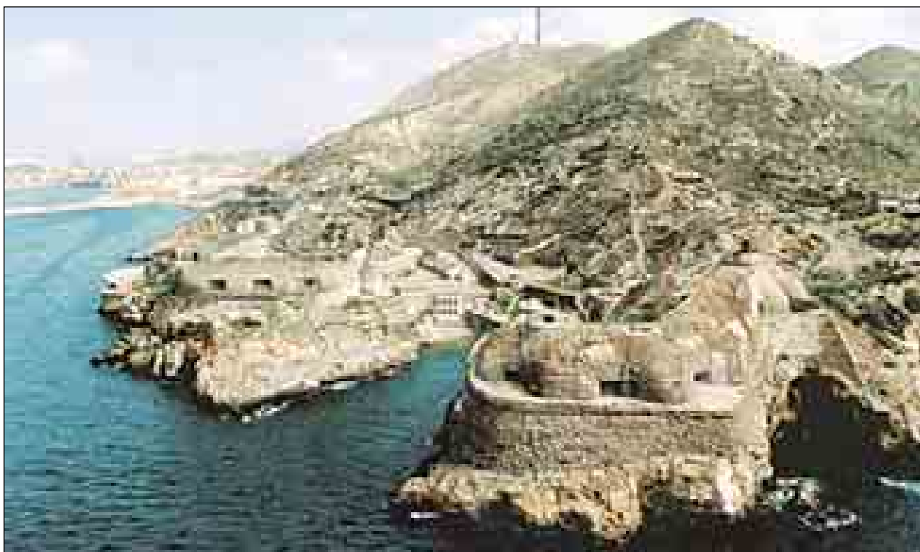
Lám. 49: Una instantánea del tipo de fortificación costero realizado a finales del siglo XIX. La batería de San Isidoro y Santa Florentina, unidas ya en una, y Santa Ana Acasamatada; las dos dotadas de bóvedas a prueba realizadas con hormigón y separadas por un diminuto embarcadero.
