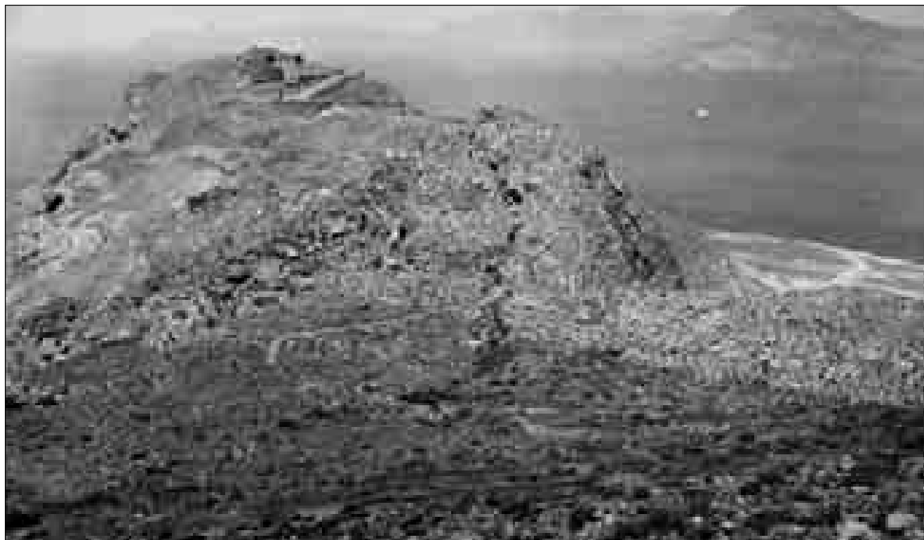
Lám. 128, 129 y 130 (en página siguiente): Una de las obras más impresionantes que se ha conservado en fotografía fue la de la apertura de la carretera que unía la batería de Aguilones con la antiaérea de El Conejo. Nótese el progresivo desmonte de cerro que separaba los dos emplazamientos, y la construcción de la vía por el centro de la elevación.
