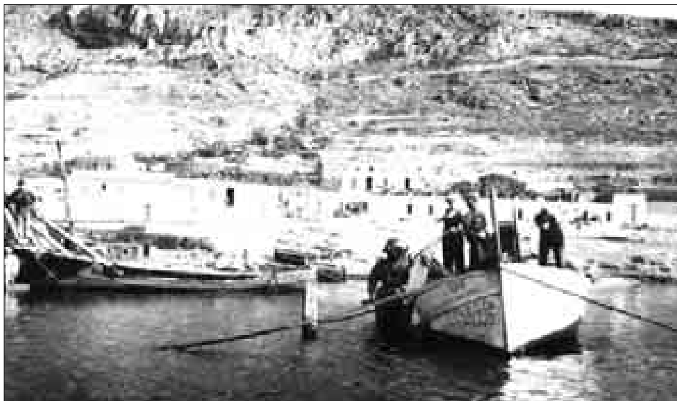
Lám. 85: El pilotaje de lo que iba a ser el nuevo espigón de La Azohía comenzó por los trabajos de los buzos.
