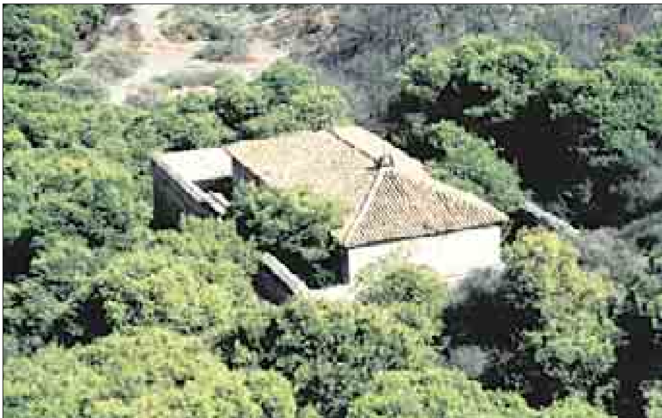
Lám. 74: Aún subsiste muy degradado este típico polvorín, muy cercano a la playa del Despalgador. Su disposición siempre era la misma en la época, con un edificio cuadrangular de una planta cubierto a dos aguas, rodeado de una cerca de obra.
