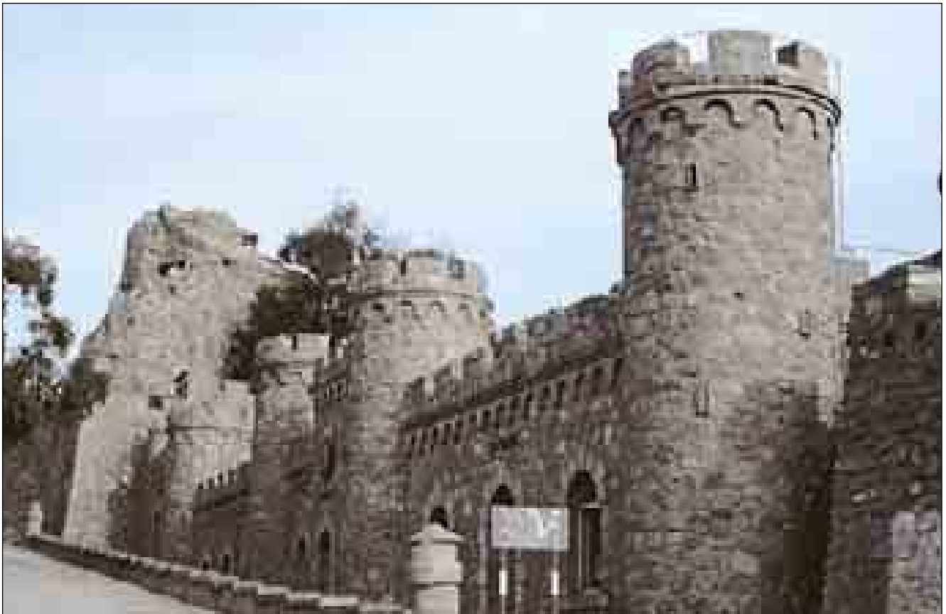
Lám. 143: También es evidente el aire historicista que se le dio a la batería de Castillitos en su gola, queriendo asemejarse a una sólida fortificación medieval; aunque, realmente, sólo aparece como un decorado que da paso a una poderosa batería.
