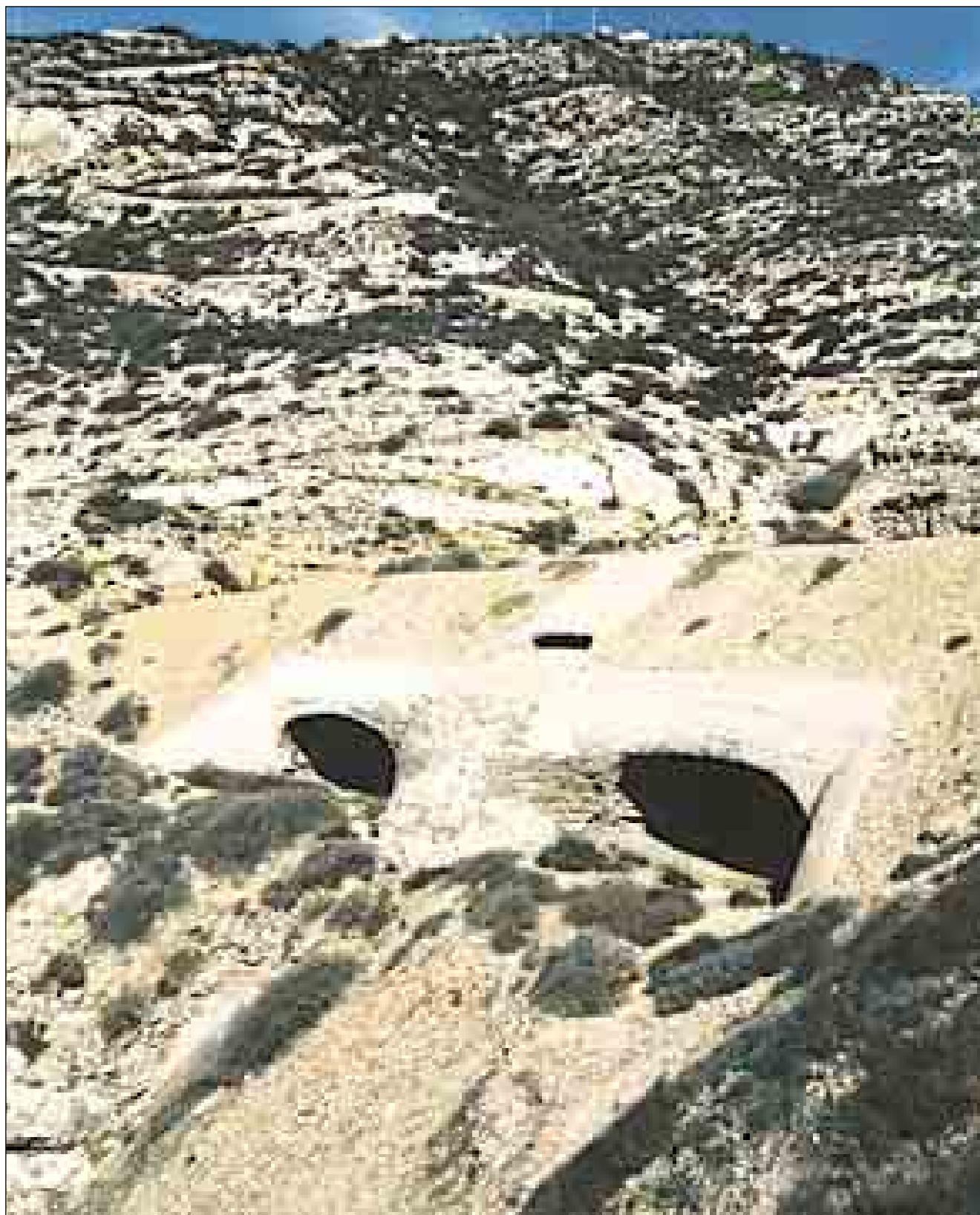
Lám. 11: La aparición de la pólvora sin humo facilitó la ocultación de las baterías, creando casi una construcción mimética, escondida en el terreno que dificultaba su avistamiento y neutralización. Un excelente ejemplo lo constituye la llamada batería del Collado, que forma parte del complejo defensivo Fajardo.
