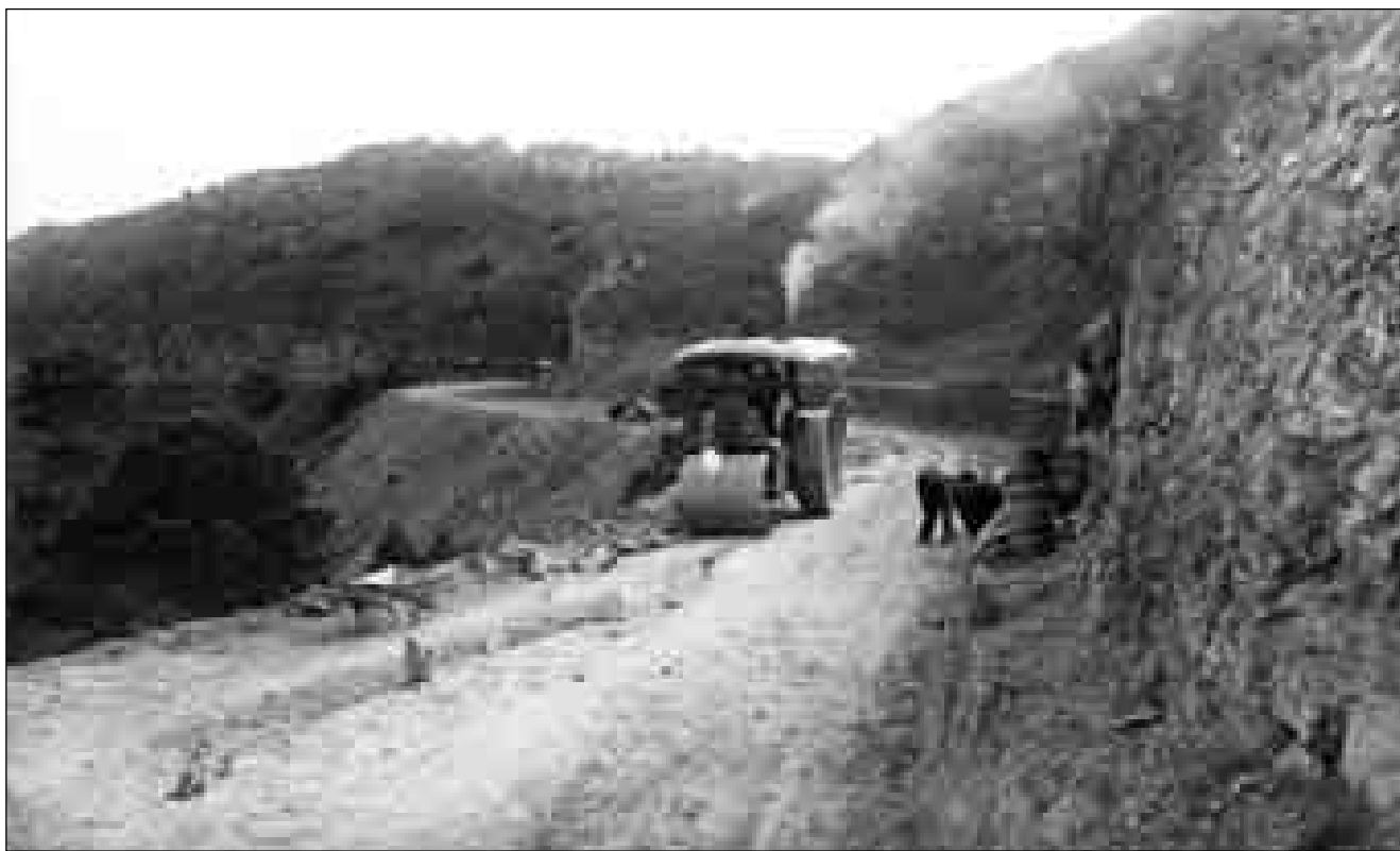
Lám. 100: Las primeras obras de consideración que requirieron las baterías levantadas conforme al Plan de Defensa de 1926 fue la habilitación de los caminos. En la imagen, la construcción de la carretera que subiría a Cenizas, la apisonadora trabajando y los operarios abriendo los drenajes.
