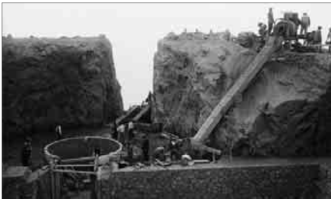
Lám. 113: Tras la apertura del pozo, comenzaba su acondicionamiento con hormigón y cantería.
