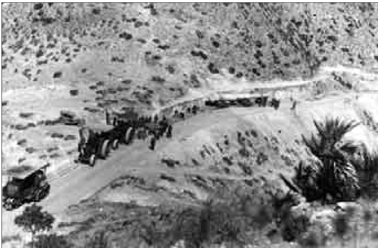
Lám. 92: Excelente imagen del transporte de una de las cañas del 38'1 que iban a ser montadas en Castillitos. Las locomóviles y el tractor semioruga tiran de la gigantesca pieza que circula por vías ferroviarias recuperables; precisamente en el cambio de las vías están ocupados los operarios en esta fotografía, ayudados por un pequeño tractor.
