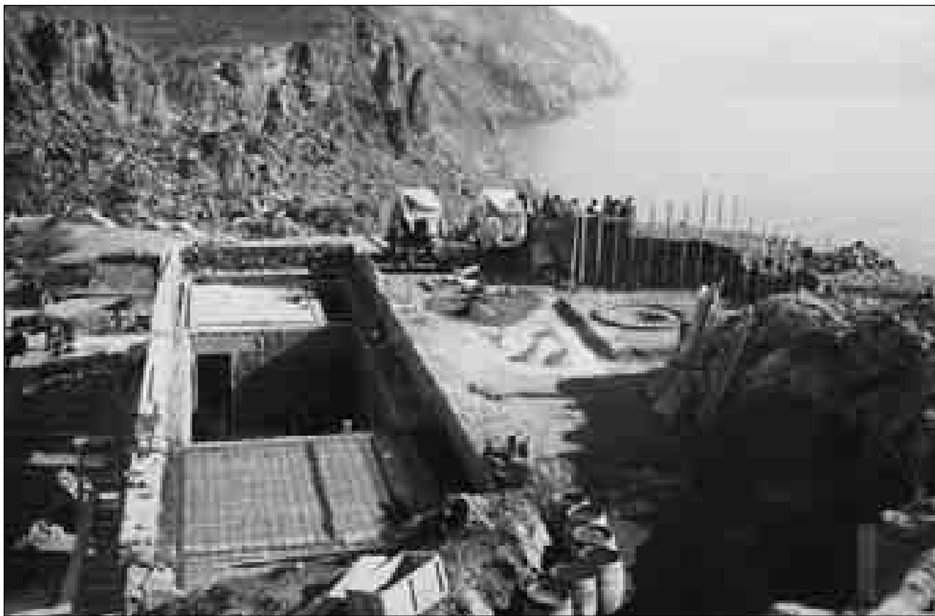
Lám. 121: Detrás de la ensenada de Escombreras, en la punta de Aguilones, se montarían otras cuatro piezas del 15'24. En la imagen, la construcción de uno de los emplazamientos de cañón en esta batería.
