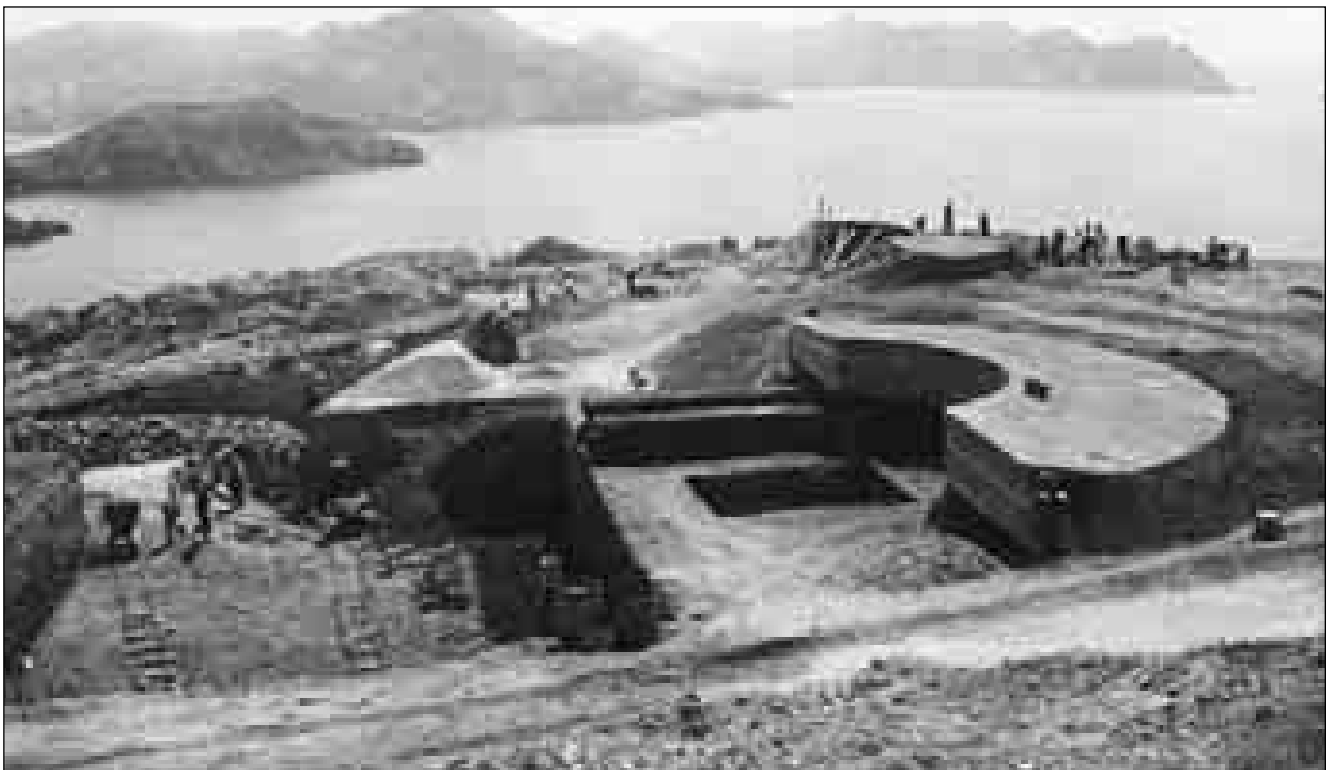
Lám. 97: La magnitud de las obras que se iban a comenzar para establecer las baterías iba a ser impresionante. En la imagen, la construcción de La Parajola.
