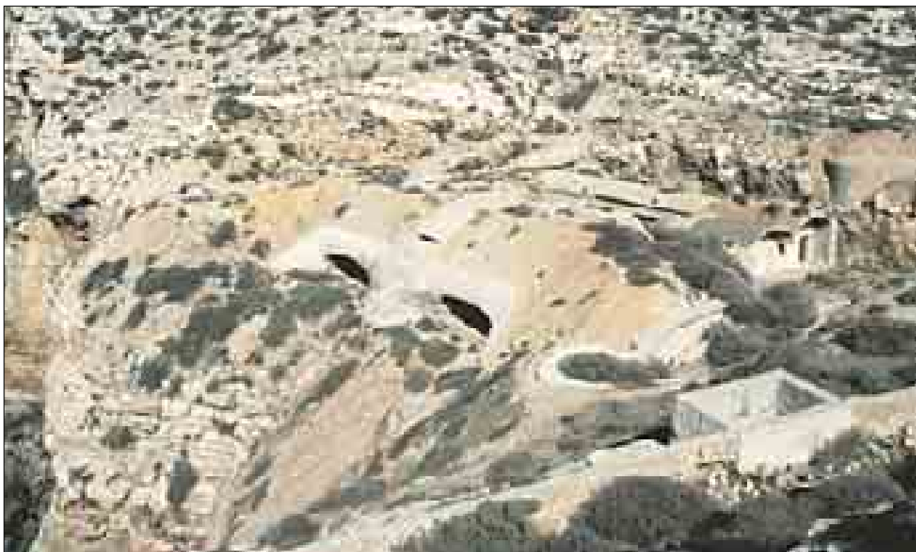
Lám. 69: Una de las baterías donde la arquitectura se adaptó perfectamente al terreno ocultando los emplazamientos de las piezas, acasamatadas en bóvedas a prueba: la batería del Collado o 47 baja.
