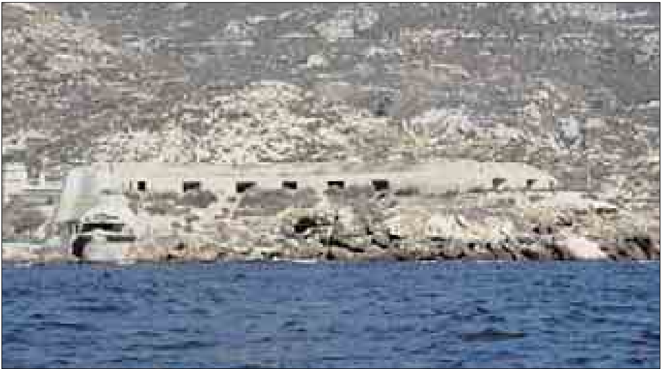
Lám. 12: Como siempre, las baterías cartageneras constituyen un excelente ejemplo de la evolución de la artillería. La antigua batería de San Isidoro y Santa Florentina, una explanada artillera del siglo XVIII, fue cubierta gracias al Plan de Defensa de 1860, y en su gola se abrieron grandes arquerías para ventilar la pólvora. Con el desarrollo de este propelente, y cuando se consiguió que no produjera un denso e irrespirable humo, se acasamató, cerrando aun más los vanos y facilitando consecuentemente la defensa.
