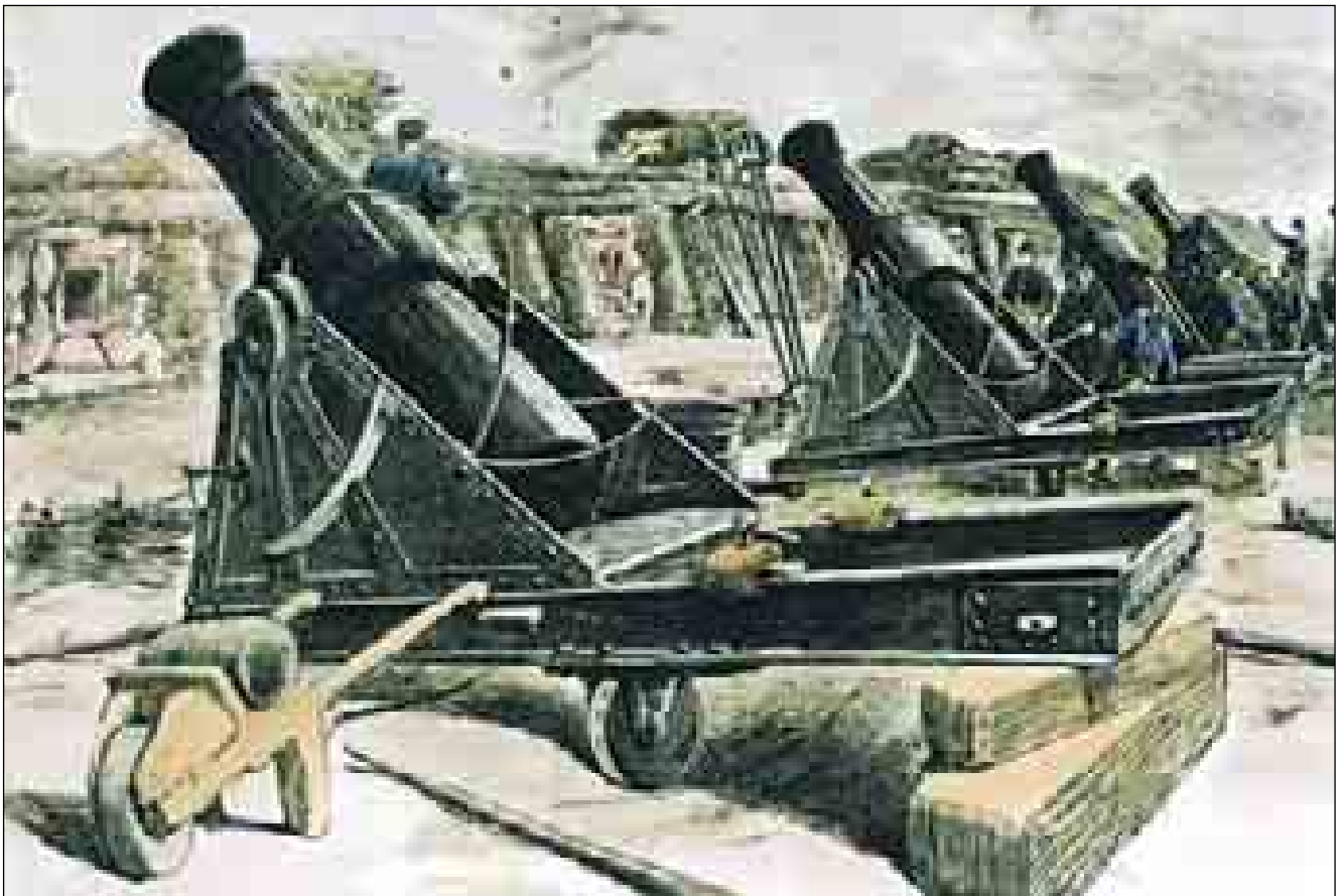
Lám.: Excelente pintura sobre un grabado de La Ilustración Española y Americana mostrando una batería centralista (la n° 2) durante las operaciones de sitio y bombardeo de la Plaza de Cartagena durante la Guerra del Cantón. Las piezas son obuses de hierro sunchado con ánima rallada de 21 cm modelo 1872; es decir, lo más moderno de lo que se disponía. Obsérvese el atrincheramiento de fajina.
