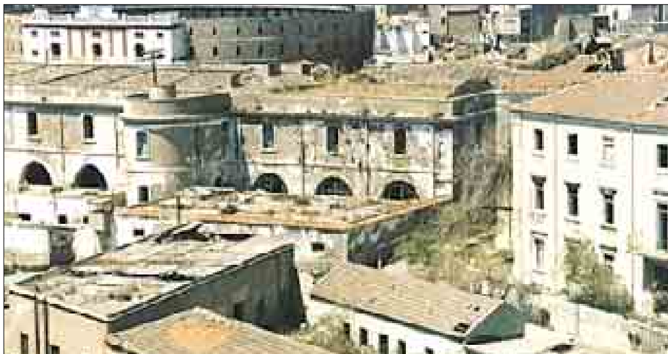
Lám. 8: Uno de los efectos inmediatos de la retirada de las tropas de la guarnición de la Plaza a finales del XX fue el abandono a su suerte de los edificios que ocuparon durante siglos. En el área de Despenaperros se agolpaban diferentes edificios, cuarteles y residencias, al amparo de Antiguones y el Hospital Militar, que han desaparecido con la rehabilitación de la zona y la apertura de una calle inexplicable en la falda este del cerro.
