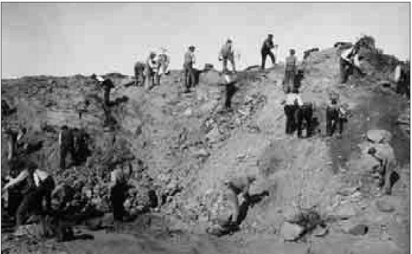
Lám. 108: Si bien se utilizó maquinaria moderna, la abundancia de mano de obra y la necesidad (y obligación como interés nacional) de dar trabajo a una sociedad deprimida, permitió unos duros trabajos de pico y pala. Cenizas.
