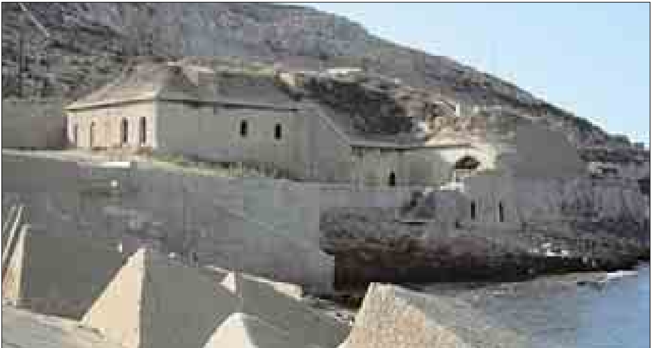
Lám. 28: Saliendo del puerto de Cartagena, la batería de San Leandro es la primera que nos encontramos en el frente izquierdo. Establecida en el siglo XVIII, fue remozada conforme al plan de Defensa de 1860. Su aspecto actual, con las tres casamatas a prueba, responde a su última remodelación a finales del siglo XIX.
