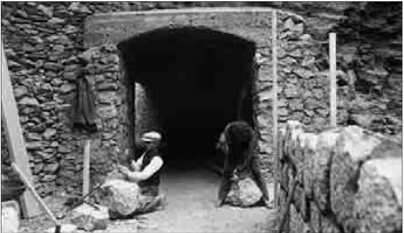
Lám. 107: En las construcciones, esta vez las ocultas de Cenizas, se utilizó el hormigón y la cantería.
