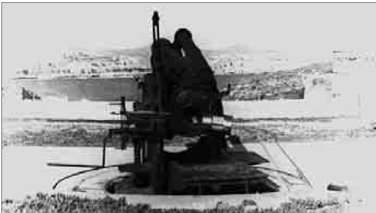
Lám. 70: El armamento más importante que se emplazó en Fajardo fueron los obuses. En la imagen, una de estas piezas de hierro sunchado de 24 cm Ordóñez modelo 1906 en montaje de cuna. Es evidente que se montaron también para batir la dársena (y si cabe, la Plaza). Obsérvese su recámara abierta con cierre de tornillo.
