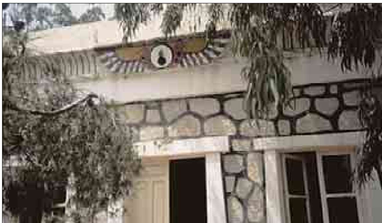
Lám. 157: La batería de La Parajola fue reparada totalmente tras la Guerra Civil, cuando apuntó estuvo de quedar totalmente fuera de combate a causa de los disparos que le hizo Aguilones durante los sucesos de marzo de 1939. Aquí, el "Ojo de Horus" corona todavía la construcción.
