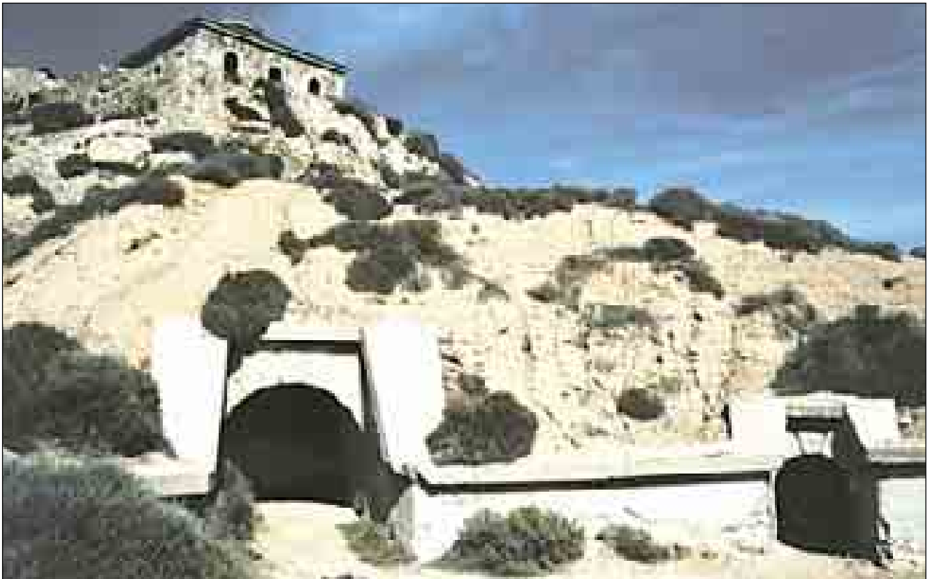
Lám. 47: Imagen de uno de los túneles de acceso y abastecimiento a la plataforma del Krupp de 26 cm establecido en La Podadera. En la zona superior, el faro del mismo nombre.
