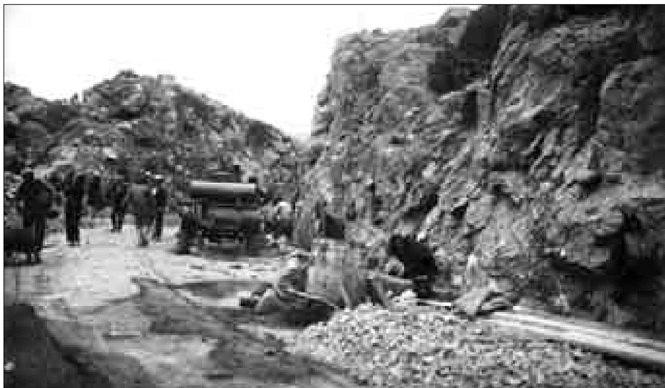
Lám. 105: Otra imagen de los desmontes requeridos para abrir las vías. Los operarios, trabajando en los drenajes de la carretera de Cenizas.
