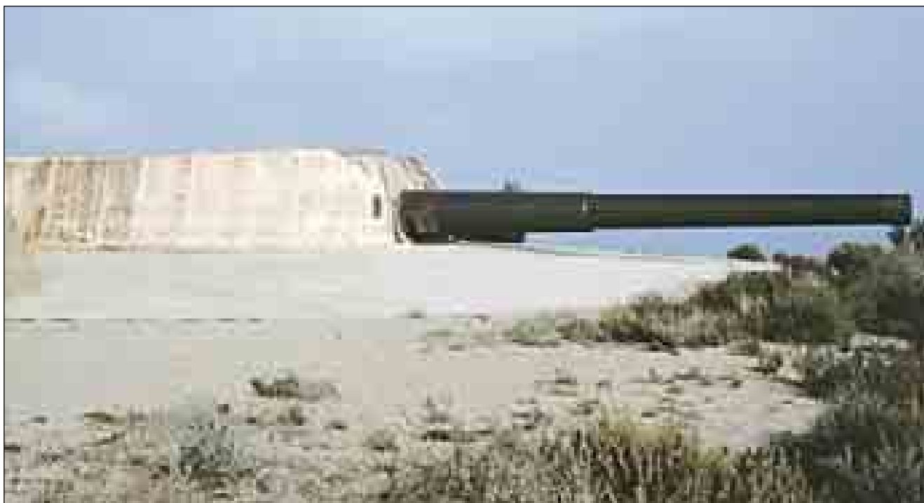
Lám. 116: Tras el montaje, fueron cubiertas con un gran carapacho que protegería a los servidores. La imagen, tomada en 1997, muestra una de las piezas del 38'1 montadas en Ceniza. Nótese el deterioro que ya presentaba por entonces; y hasta hoy, no se han adoptado medidas para evitarlo.
