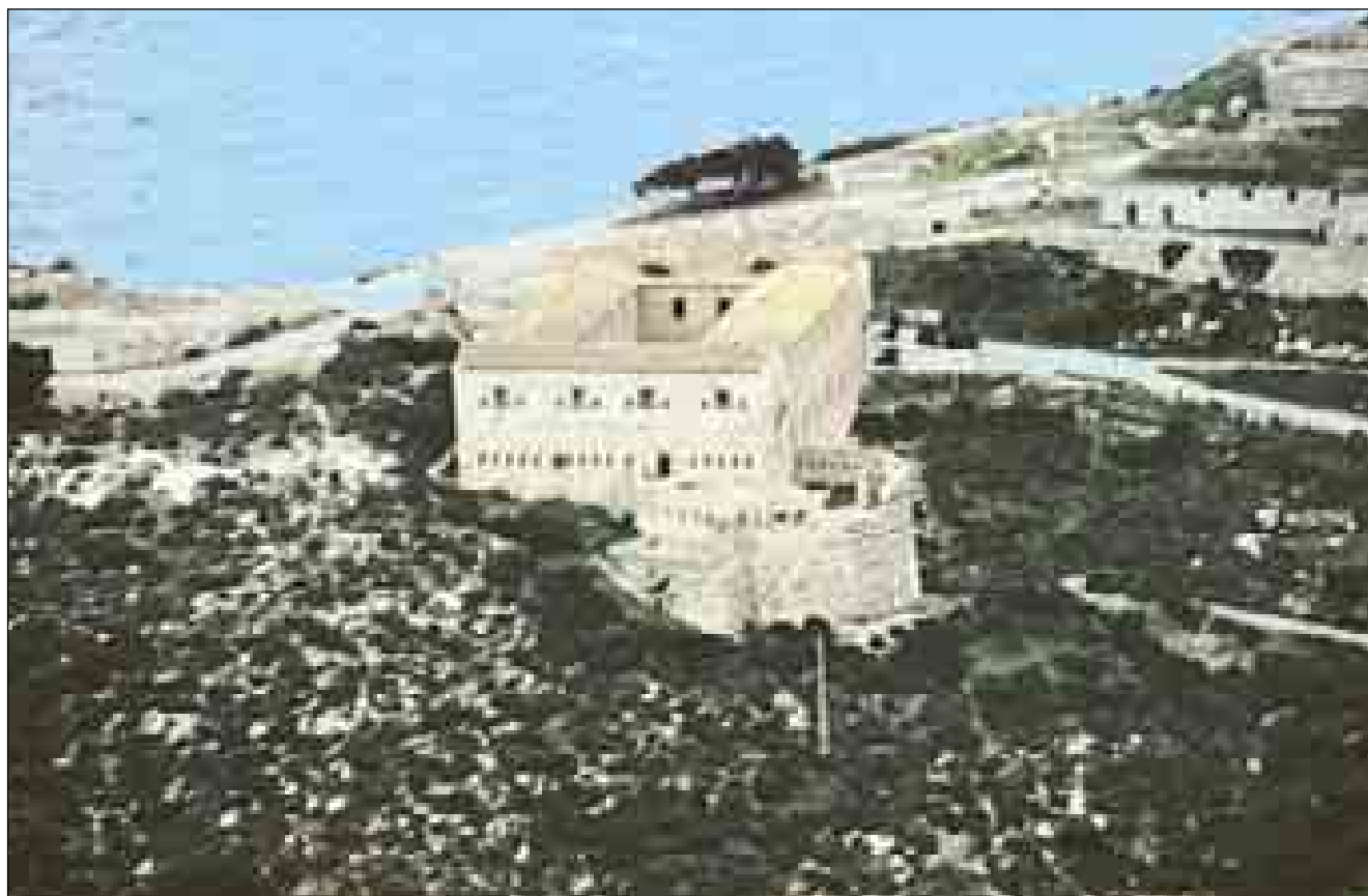
Lám. 36: En lo alto del monte de la Podadera, en las estribaciones de Galeras, se levantó este cuartel defensivo que, alejado de la Plaza, atendía y defendía a la gran cantidad de establecimientos artilleros que se colocaron en el frente derecho.
