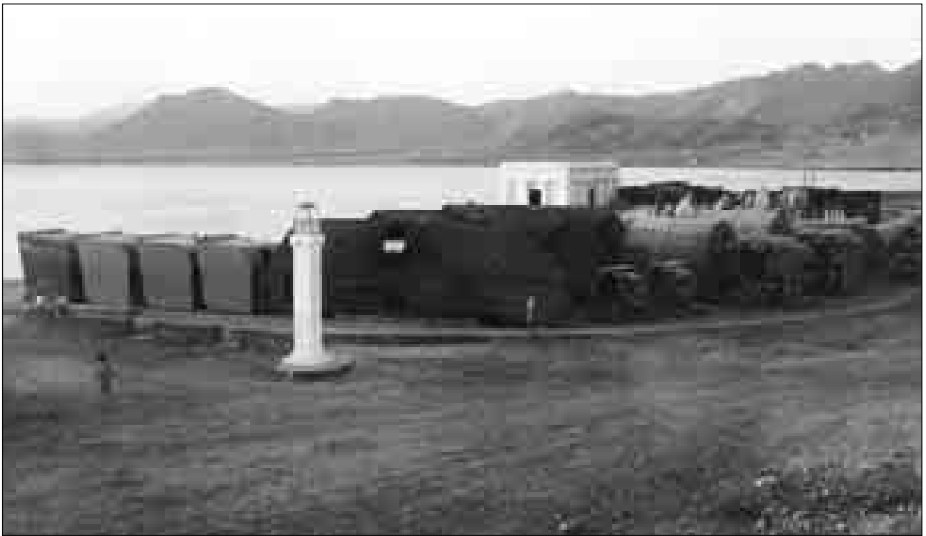
Lám. 95: En el recién construido muelle de La Azohía también se desembarcó el resto del material Vickers, en este caso para armar la batería del Jorel. Véanse los cuatro carapachos de las piezas 15'24 enfilados y ya desembarcados, junto a las cunas de los 38'1.
