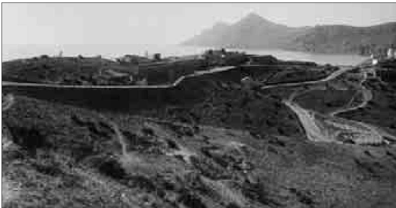
Lám. 120: En 1929 la batería de La Chapa estaba ya prácticamente ultimada. Véase, a la derecha de la fotografía, el faro de Portmán, donde anteriormente, a finales del siglo XVI, el concejo de Cartagena levantó una torre defensiva para cubrir la bahía.
