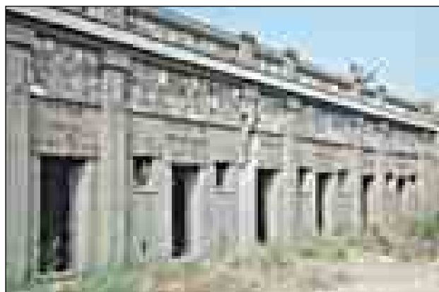
Lám. 173: Con el tiempo y el progresivo y lento recibimiento de material norteamericano, las posiciones antiaéreas fijas fueron las primeras que comenzaron a desartillarse. En la imagen, uno de los edificios construidos en El Conejo durante el despliegue Vickers.
