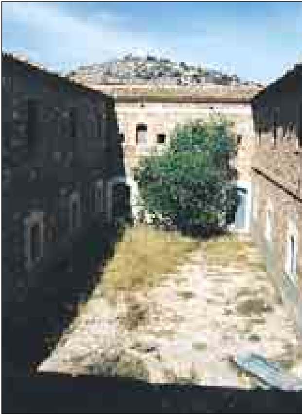
Lám. 56: Era el patio del Cuartel Defensivo Fajardo el que articulaba los espacios interiores del edificio, y como en casi todos los grandes edificios militares, en su centro se disponía el pozo del aljibe para el suministro autónomo de aguas. A pesar de estar protegido independientemente, el cuartel está dominado por el fuerte de Galeras.
