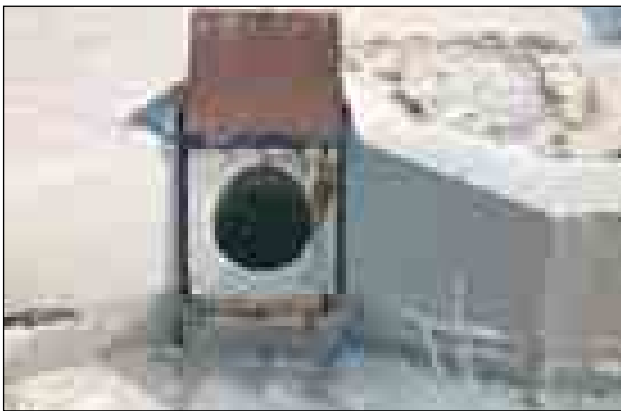
Lám. 162: El municionamiento de las baterías antiaéreas, en este caso la de El Conejo, se realizaba también a través de ascensores, cuya boca superior aparece en la imagen.
