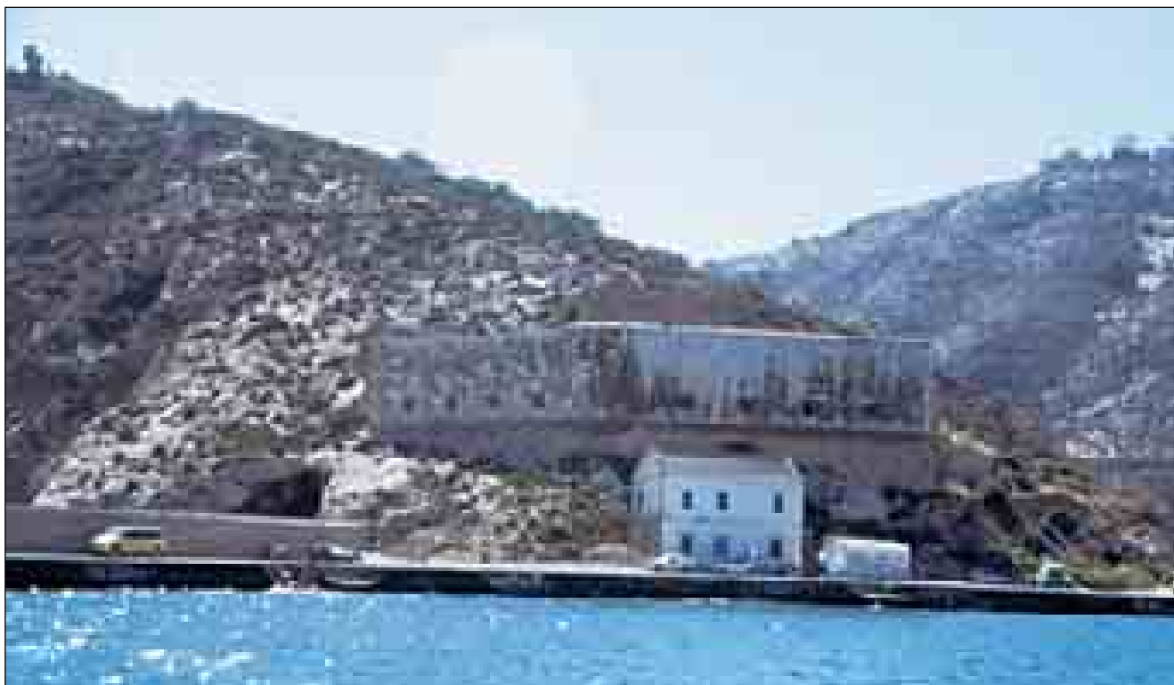
Lám. 35: Levantado sobre la batería del siglo XVIII, conforme al Plan de Defensa de 1860 se levantó este fuerte de estilo neoclásico para ocho piezas en el interior del edificio y otras tantas a barbata en el trasdós de las bóvedas.
