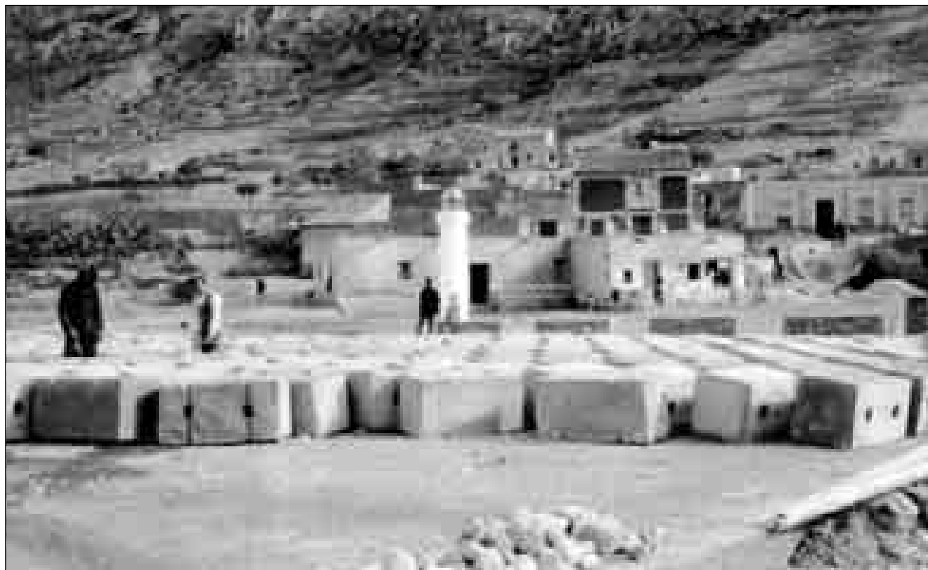
Lám. 86: Tras el trabajo submarino, se colocaron los bloques de hormigón. La Azohía era por entonces un reducido caserío de pescadores y algunos agricultores.
