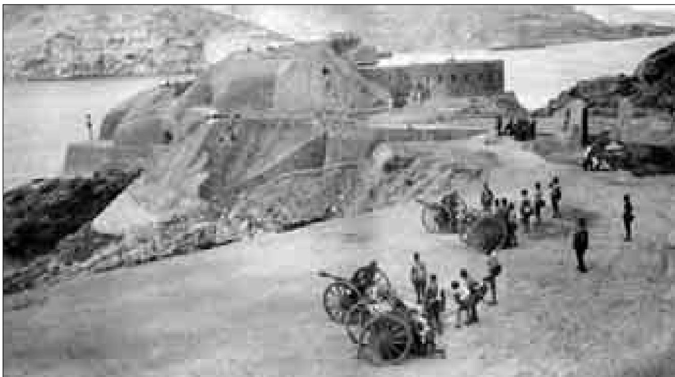
Lám. 48: Lo cierto es que, hasta hace pocos años, los dos frentes portuarios resultaron ser una zona exclusivamente militar, dedicados al cierre de la bocana portuaria. En la imagen, probablemente de comienzos del XX (los cañones parecen ser de campaña 75/28, modelo 1906), la explanada al sur de Santa Ana Acasamatada es aprovechada por la batería de salidas para las prácticas. Nótese las casamatas que reformaron el emplazamiento establecido durante el Plan de Defensa de 1860.
