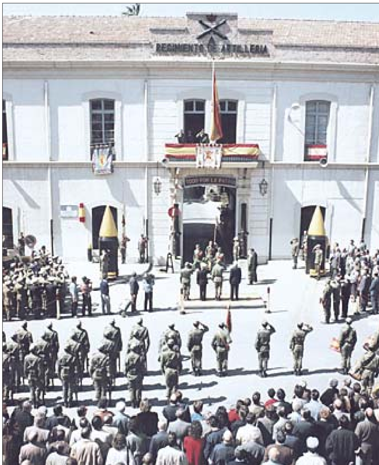
Lám. 4: El Parque de Artillería fue otro de los grandes edificios militares construido durante la segunda mitad del siglo XVIII, convirtiéndose desde aquel momento en una de las construcciones más admiradas de la ciudad. Su función puramente castrense, evidente hasta hace unos años, se ha diluido parcialmente –tras su brutal mutilación en las alas norte, oeste y sur– para formar parte del patrimonio visitable de la población, con el establecimiento del Museo Militar y, en un futuro cercano, el Archivo Municipal de Cartagena.
