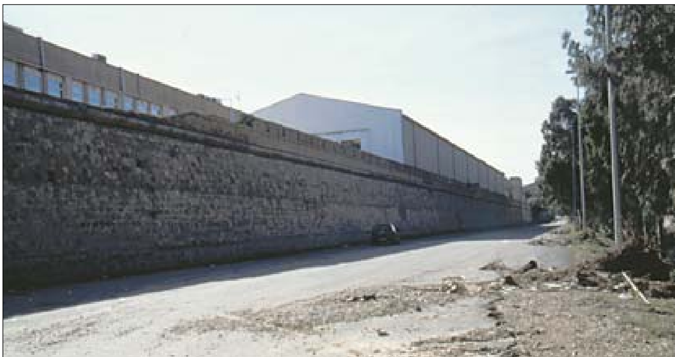
Lám. 13: Desde el principio de las obras para habilitar una dársena interior en el puerto de Cartagena, se tuvo claro que era absolutamente necesario desviar las ramblas que cegaban el mar de Mandarache. Por ello, la primera gran obra de ingeniería fue la construcción de un malecón por donde finalmente se desviarían las aguas de la rambla de Benipila hacia la Algameca Chica.
