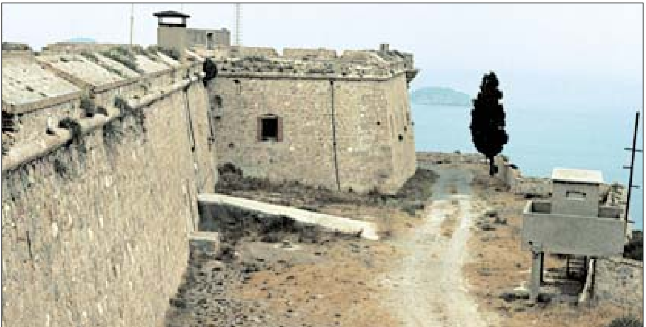
Lám. 52: Básicamente, al estar levantados en la misma época y por los mismos ingenieros, tanto los fuertes como la muralla del siglo XVIII presentan un estilo extraordinariamente homogéneo a pesar de sus diferentes funciones y lugares donde se levantan. En altura, esquemáticamente una cortina de piedra careada da paso a un cordón que circunda toda la fortificación; sobre él se levantan los antepechos que protegen las piezas de artillería y sus sirvientes. No obstante, cuando un siglo después se acabó el fuerte de San Julián, y a pesar de presentar en algunos sectores una técnica que ya no utiliza los baluartes, los ingenieros encargados siguieron manteniendo, en esencia, esta disposición vertical de los muros. En la imagen, cortina, baluarte y foso de Galeras; el muro interior de este último elemento constituye, en sí mismo, un camino cubierto que rodea la fortificación.
