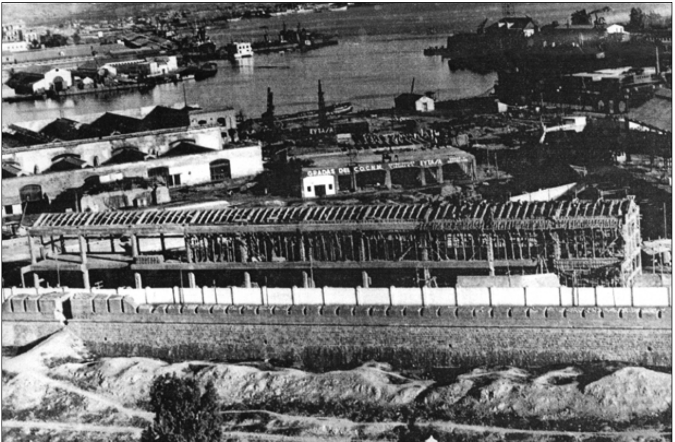
Lám. 74: Las cortinas del frente de Benipila se prepararon para la defensa a base de fuego de fusilería, por lo que presentaba un coronamiento aspillerado en toda la parte superior del muro.
