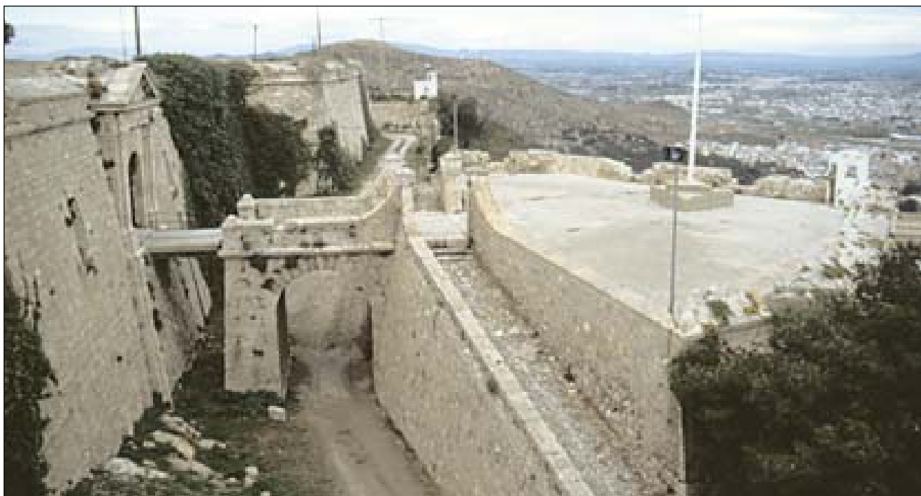
Lám. 55: El complejo defensivo de la puerta de Galeras, constituido por el revellin y sus rampas, el foso, el puente levadizo (actualmente desaparecido y sustituido por una pasarela de obra), y el vano de medio punto por el que se accede al fuerte, constituye uno de los conjuntos más bellos de las fortificaciones cartageneras.
