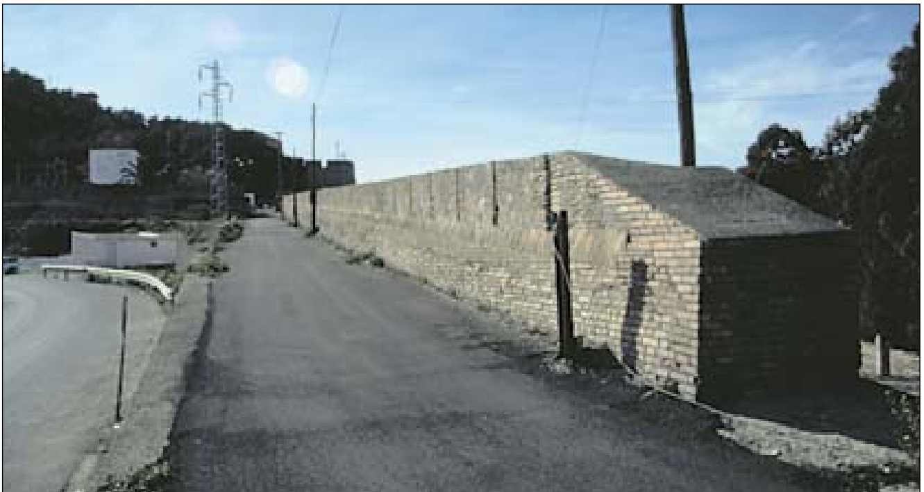
Lám. 75: Muy degradados, en ciertos tramos aún hoy se conservan las estrechas aspilleras del frente de Benipila.
