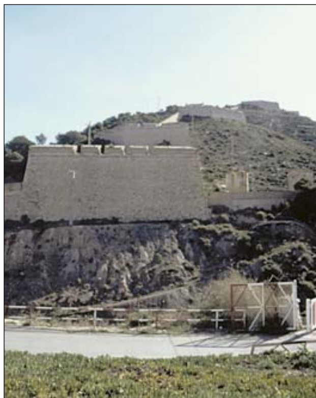
Lám. 45: En todos sus tramos existe la constancia del intento continuo de los constructores de la muralla por adaptar la construcción al terreno y no al contrario. Por ejemplo, en el frente de Galeras, los caballeros de la muralla, casi fuertes por sí mismos, ascienden a lo largo de toda la pendiente del monte hasta llegar al castillo, prácticamente sin alterar el terreno.
