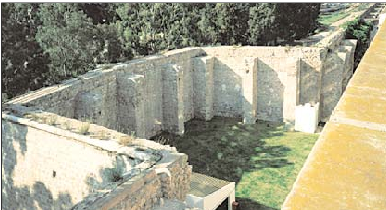
Lám. 44: Uno de los aspectos más interesantes del sistema constructivo de los baluartes de la muralla es que realmente eran construcciones de tierra apisonada, material que era capaz de absorber la fuerza de un disparo. Primero se creaba el molde, con un muro de piedra sujeto con contrafuertes, y después se rellenaba con tierra. La continua presión antrópica a la que ha sido y es sometido el frente de Benipila, da como resultado continuas transformaciones (cuando no agresiones) de la construcción del XVIII.
