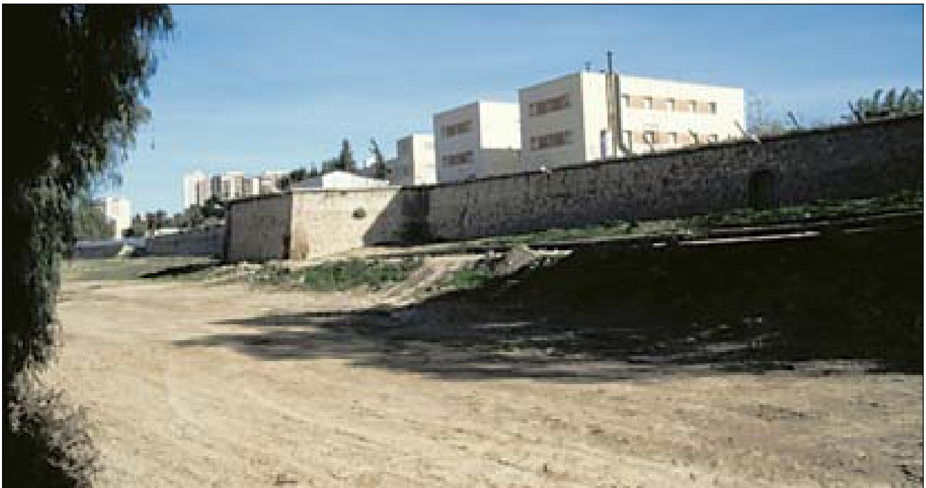
Lám. 33: Aprovechando el malecón construido para desviar las ramblas que cegaban el mar de Mandarache, se construyó bajo las recomendaciones de Llobet (y anteriormente de Zermeño) una muralla que cerraba el frente del Arsenal, y que también –al margen de funciones defensivas haría frente a las terribles avenidas de agua durante las lluvias estacionales que afectan a la ciudad, tal y como lo hace en la actualidad.
