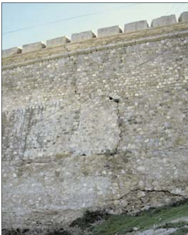
Lám. 43: En ciertos tramos de la muralla y de alguno de los fuertes que rodean la ciudad, aún se conservan los vestigios de portillos que se dejaban abiertos durante la construcción de la muralla para introducir materiales o para diversos menesteres, y posteriormente, cuando dejaban de tener función o las obras finalizaban, eran convenientemente cegados. En la imagen, una puerta o poterna tapiada en el frente de Benipila.
