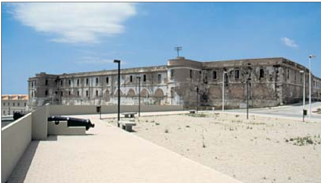
Lám. 6: Al lado del Hospital Militar, y para dar cabida a la numerosa guarnición establecida en Cartagena, se levantó el llamado Cuartel de Antiguones. Siguiendo unas líneas similares al edificio hospitalario, muy pronto achacó problemas de cimentación que alargaron el tiempo de su construcción, y ha sido uno de los puntos previos que han debido de solucionar los arquitectos para su futura rehabilitación para la Universidad Politécnica.
