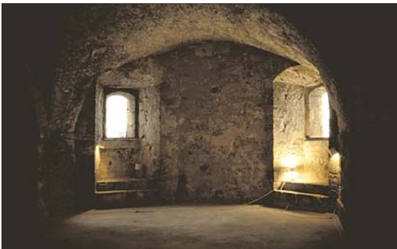
Lám. 56: Los espacios internos de los fuertes cartageneros son generalmente amplios, y mucho más desde que se vaciaron ciertos baluartes para ser habitados por las diferentes guarniciones que pasaron por ellos. En el caso de la imagen, Galeras presenta unas grandes bóvedas de crucería que cubren enormes galerías. Con los años, los castillos del XVIII se convirtieron, cuando ya casi habían perdido la función estratégica para la que fueron construidos, en alojamientos de los soldados destinados en la Plaza.
