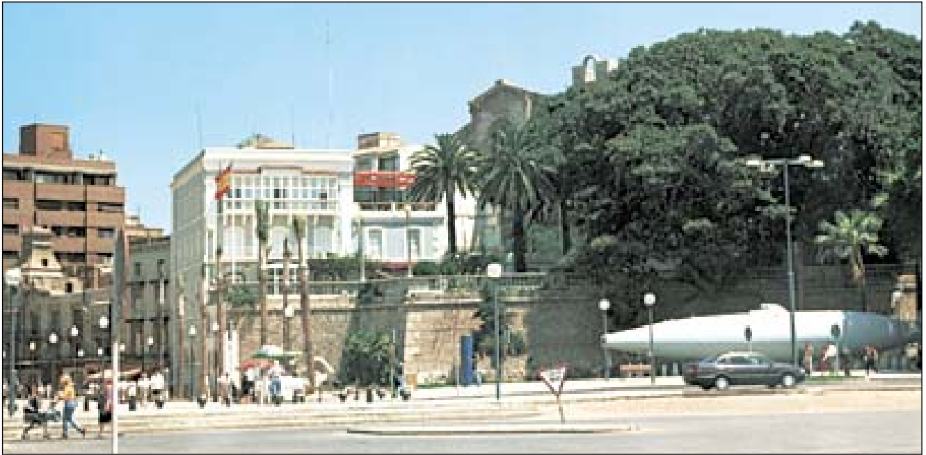
Lám. 46: La fachada marítima de la muralla se diferenciaba de la terrestre tanto en la factura de sus materiales como en la disposición de distintos elementos defensivos que la componen, diferencias que se repiten en todos los frentes de la muralla, ya que cada sector cumplía una función. En los últimos años esta situación se ha visto agravada por la falta de un criterio único de intervención en la rehabilitación de lienzos y coronamientos. En la imagen, tomada hace unos años, se observa aún la balaustrada que coronaba la muralla del Mar, y que por su transparencia respetaba la altura original de sus muros. Lo privilegiado del área ha producido una continua transformación urbana de la zona no siempre con los criterios más racionales.
