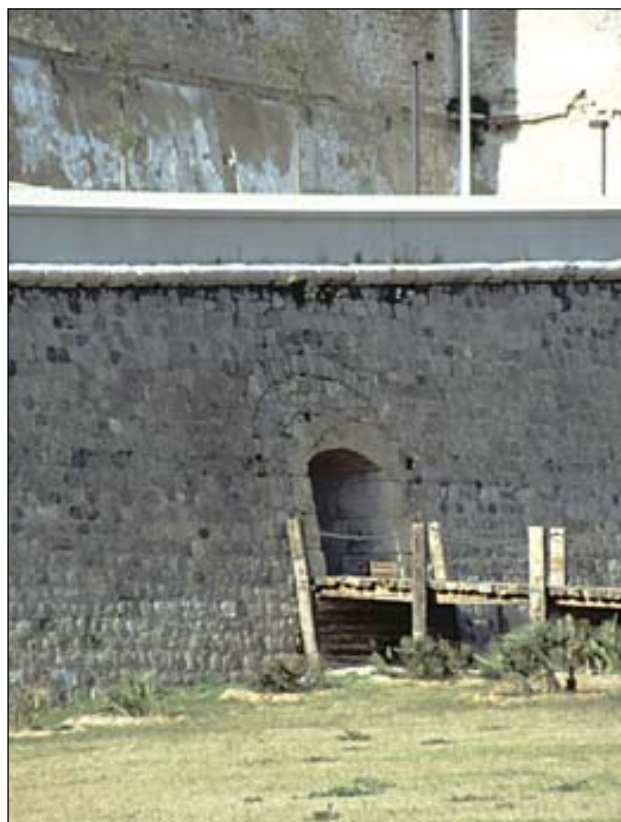
Lám. 48: En el frente del Batel se abría esta puerta, recientemente rehabilitada para uso universitario, que daba paso a un camino cubierto cuya función era auxiliar el fuerte de Moros. Como todas las puertas de una fortificación, presenta unas características funcionales muy concretas. En este caso, por ejemplo, el tramo interior del vano es curvo (para evitar la entrada directa de tropas o un proyectil), y además su salida al exterior está elevada sobre el suelo.
