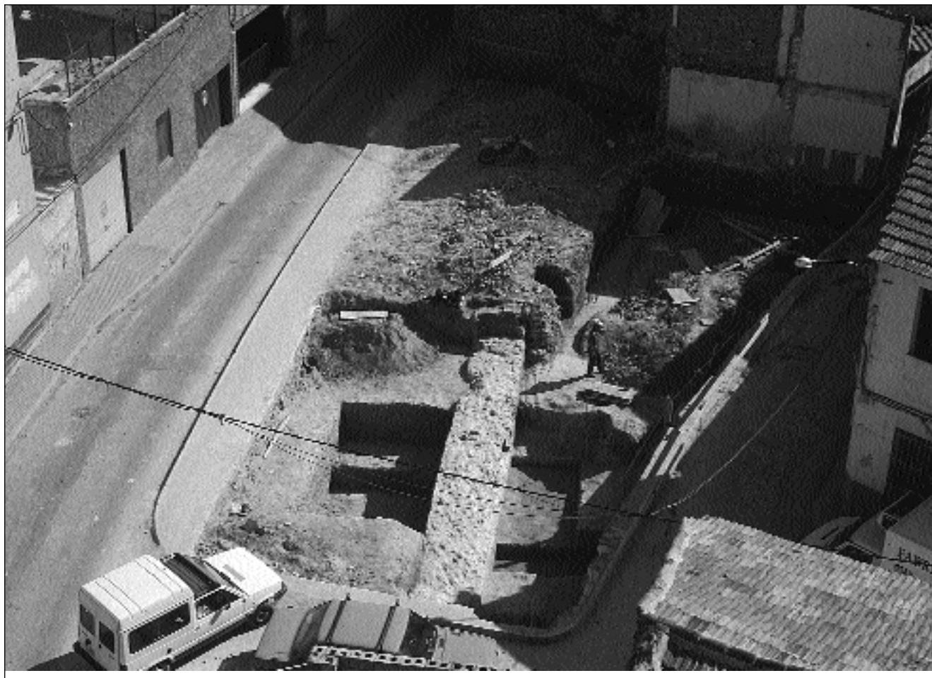
Figura 1. Vista general. Lienzo de muralla, solar n.º 19.
