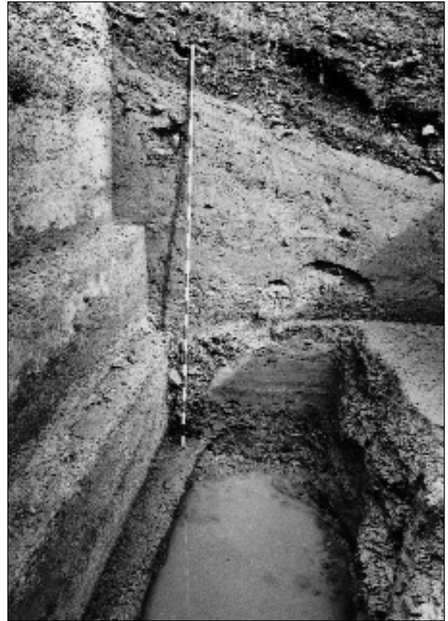
Figura n.º 5: Detalle del sistema de cimentación del bastión.
