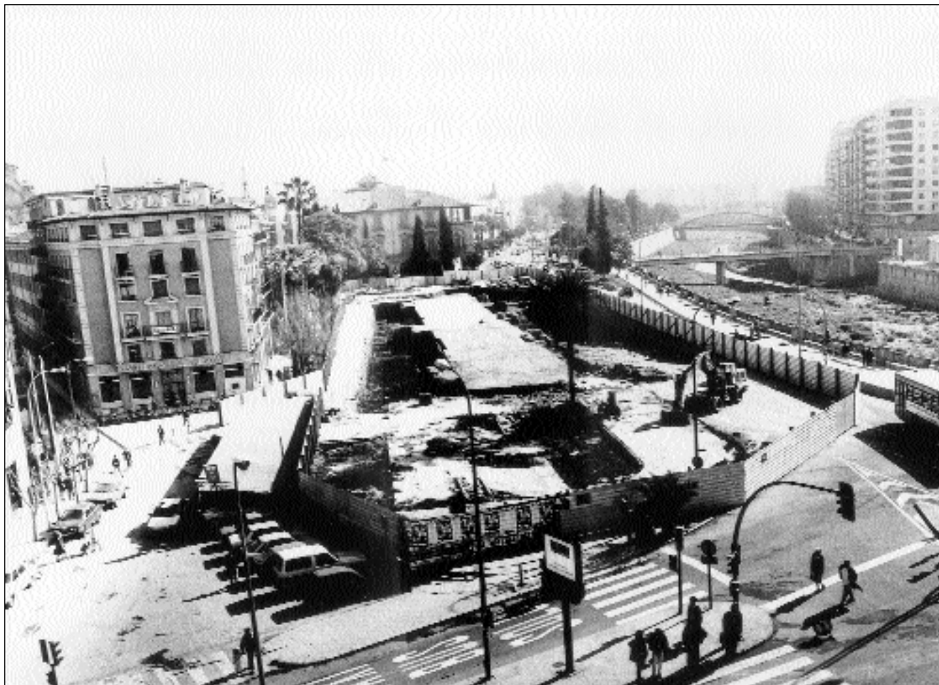
Figura 1. Panorámica de La Glorieta desde el Edificio Victoria. Los refugios antiaéreos son visibles en el centro una vez iniciadas las obras.
