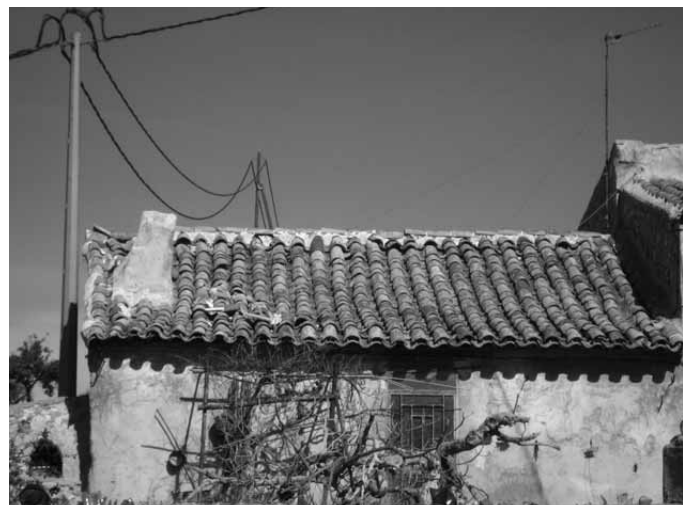
Lámina 2. Casa de la Tía Ana María (Gebas). Casa-tipo de familia muy pobre: una sola planta, sin patio, sin divisiones internas, etc. Autora: Aurora Lema.
