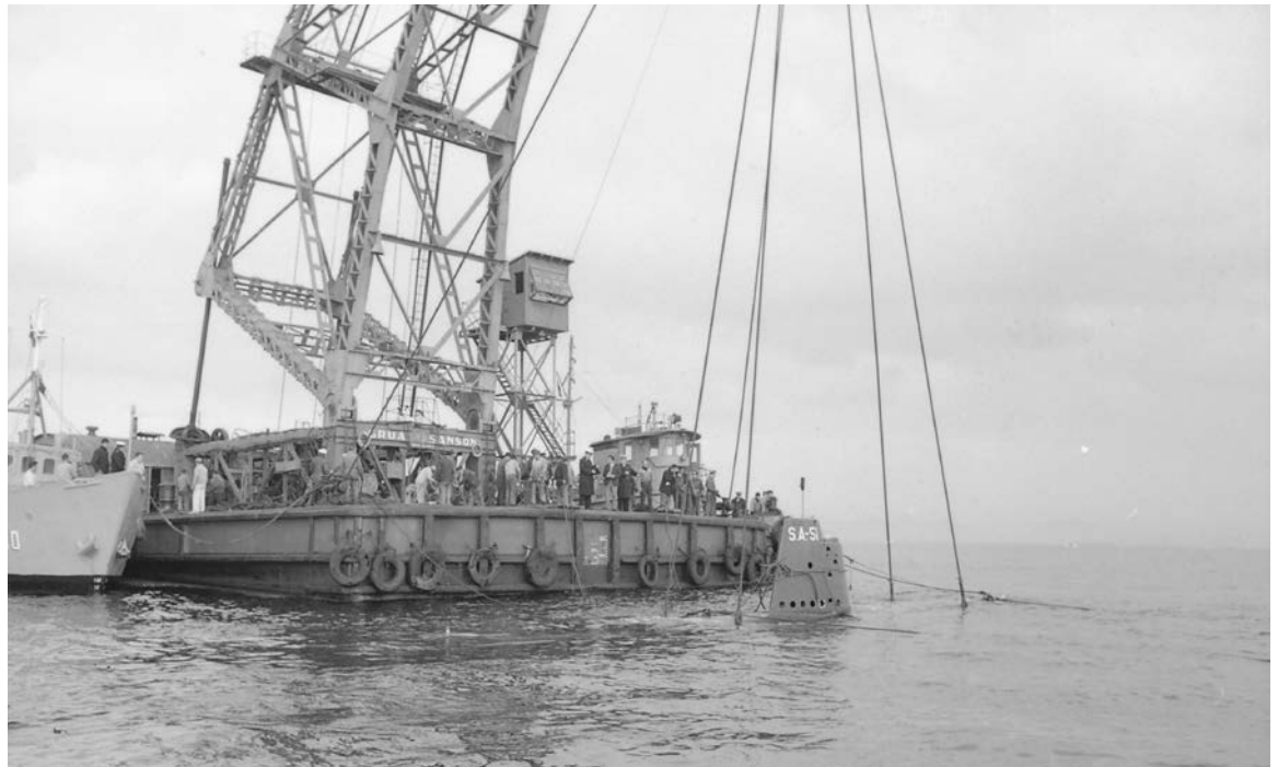
Figura 4. 1967. Prueba de flotación del SA-51 Tiburón . (Fuente: Archivo de NAVANTIA)
