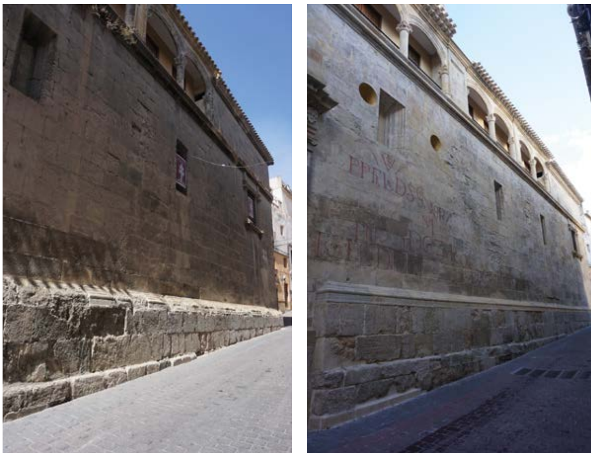
Figuras 1 y 2. Fachada sur de la iglesia del Salvador en Caravaca de la Cruz, antes y después de los trabajos.
