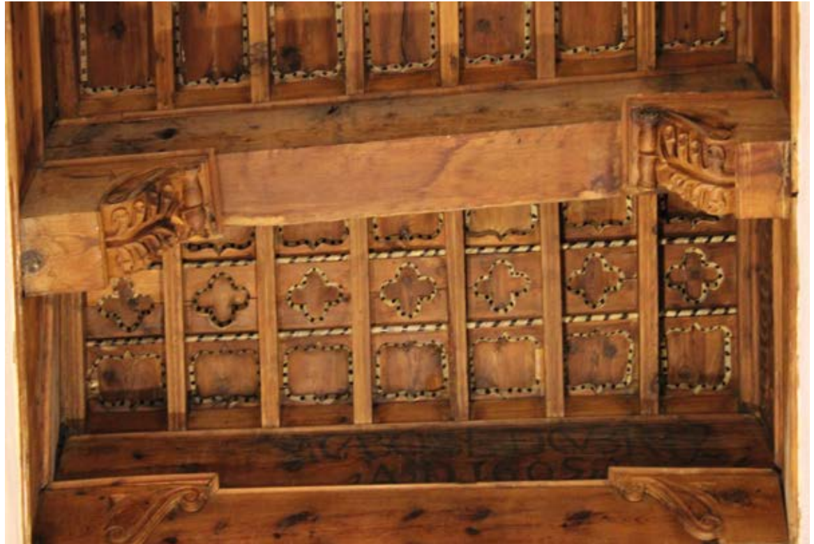
Figura 2. Detalle del arranque del faldón del tramo 0 (techumbre del coro), con el texto “ acabose de cubrir año de 1605 ” en el lateral de la primera la viga.
