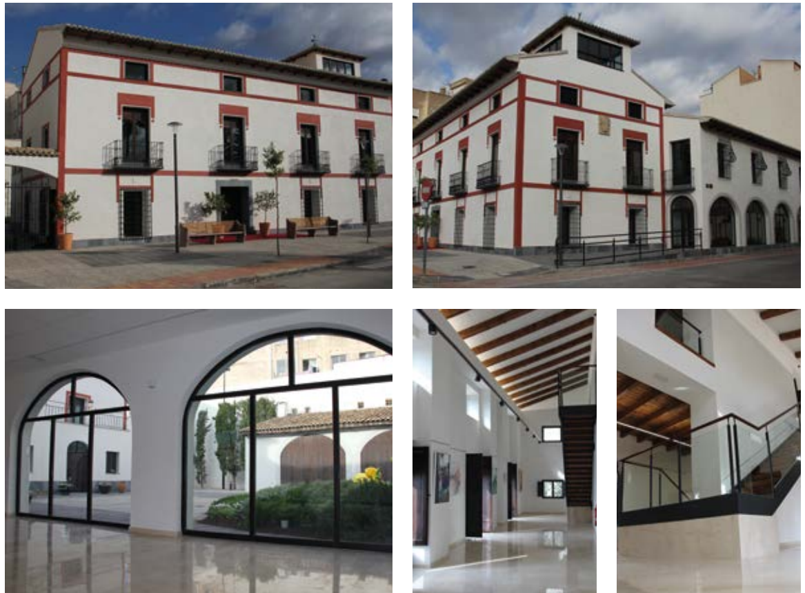
Figura 4. Vistas generales de las fachadas rehabilitadas e interiores de la sala a doble altura con su fachada interior.
