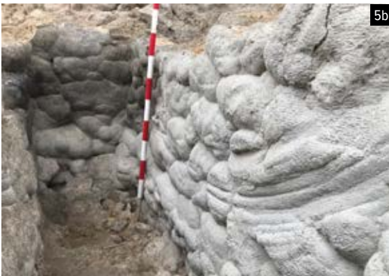
Figura 4. Vista del muro de regularización del salto hidráulico e inicio del canal de la noria. (Foto: autoras)
