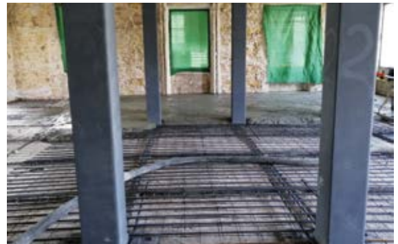
Figura 8. Imagen durante los trabajos de hormigonado, en forjado primero del Pabellón I.
