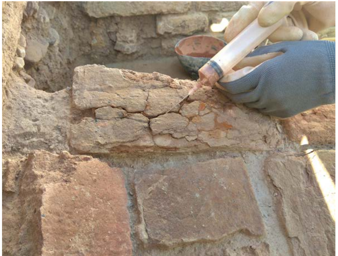
Figura 4. Inyección del mortero.
