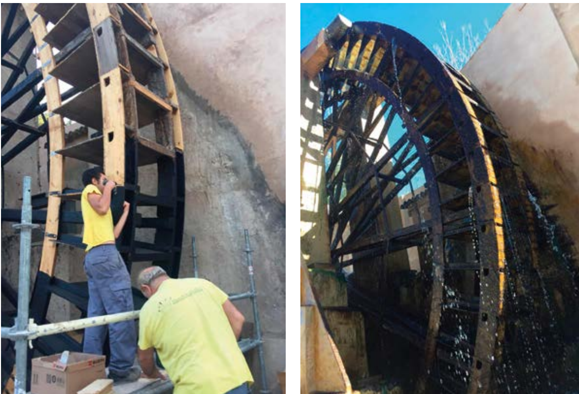
Figuras 7 y 8. Detalles de los trabajos de las partes de madera de la noria. (Fuente: Elaboración propia)
