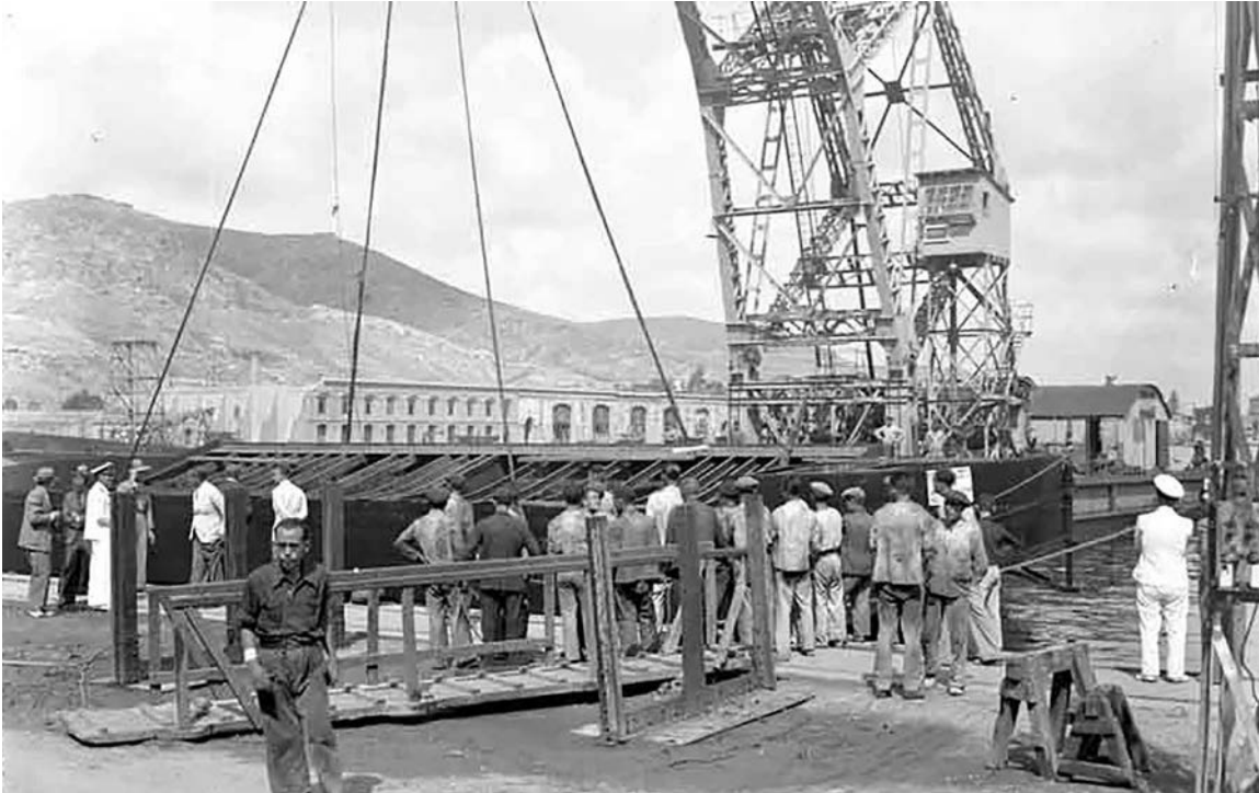
Figura 3. 1941. Imagen depositando una barcaza basculante de 250 toneladas en la dársena del Arsenal de Cartagena. (Fuente: Archivo de NAVANTIA)
