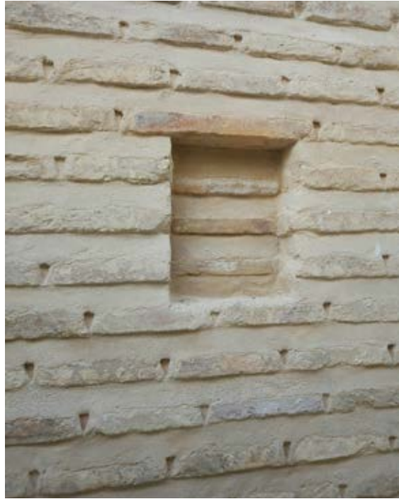
Figura 1. Detalle de uno de los paños recuperados en Santa María de Gracia, con los tendeles horizontales ejecutados a punta de paleta y las juntas verticales rehundidas en forma de triángulo.
