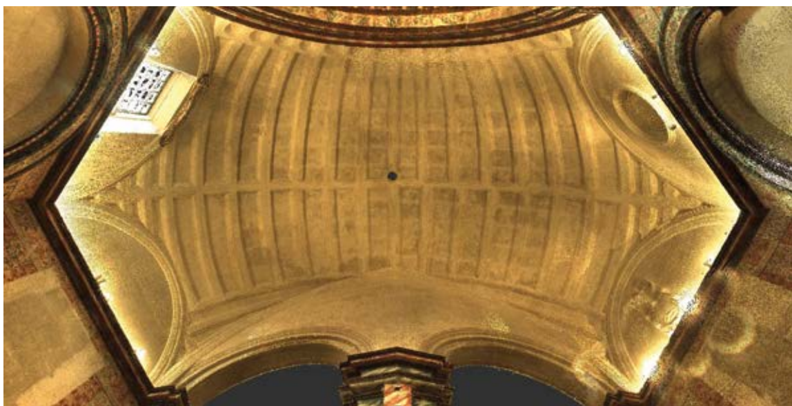
Figura 6. Nube de puntos de la bóveda de la capilla Virgen del Alcázar. Colegiata San Patricio (Lorca). (Fuente: Arquivera, www.arquivera.com)
