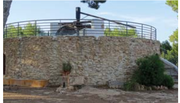
Figura 8. Vista general de la noria tras su restauración. 2020.
