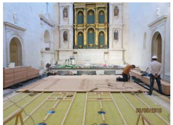
Figura 14. Montaje suelo de tarima Dinesen de Pino Douglas.
