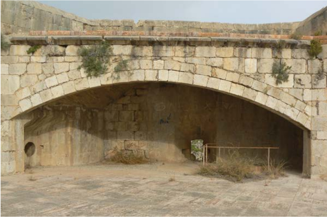
Figura 2. Arco escarzano levantado para sostener la tribuna de la plaza de armas.
