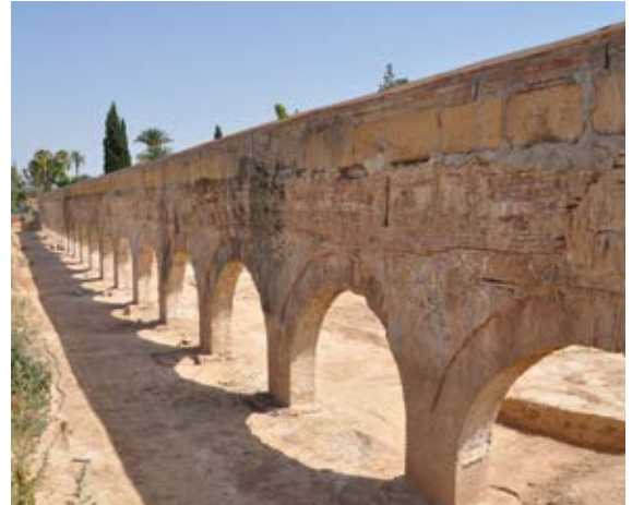
Figura 3. Visión del acueducto tras su excavación. (Autor: J. A. Ramírez Águila)
