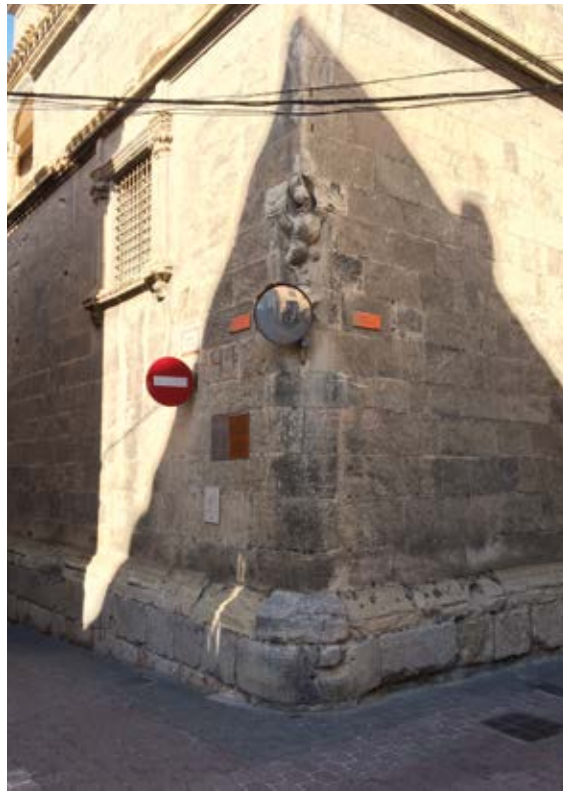
Figuras 7 y 8. Vista de la esquina sureste antes y después de los trabajos. A la izquierda puede apreciarse cómo la arpa y todo su entorno estaban completamente degradados, no solo por la erosión y los agentes climáticos, sino también por la colocación de diversas señales. A la derecha, una vez retirado todo ello, consolidada la piedra, ejecutadas las prótesis, así como los vitores más vistosos que son justo los que se encuentran entre la arpa y la ventana.
