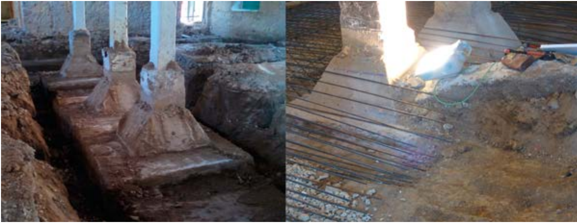
Figura 3. Cimentación en Pabellones I y II durante los trabajos de refuerzo por recalce.
