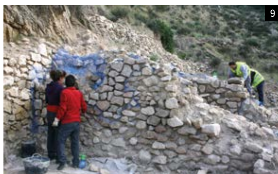
Figura 7. Consolidación química de las estructuras con aplicaciones de agua de cal (Salto de la Novia-Ulea).
