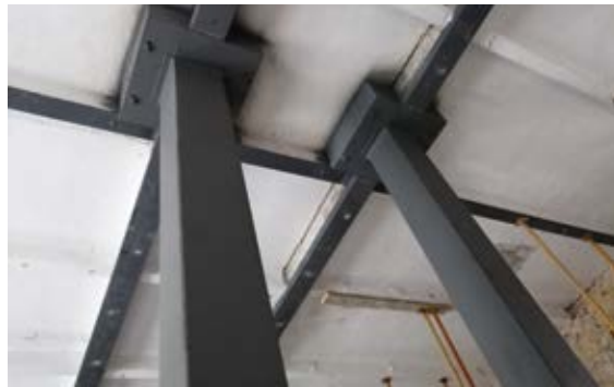
Figura 7. Detalle encamisado metálico, Pabellón I.
