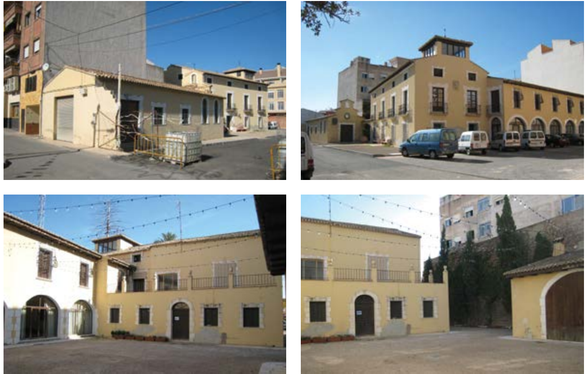
Figura 2. Vistas de la edificación. Estado pre-existente antes de la intervención.
