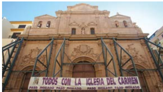
Figura 4. Apeo de la fachada barroca. Iglesia del Carmen (Lorca).
