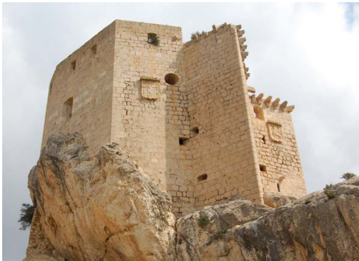
Figura 3. Esperonte situado en la fachada oeste del castillo.
