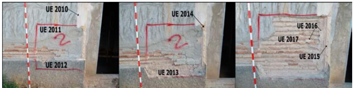
Figura 4. Ejemplo de proceso de trabajo, Cata 2. Se observa cómo se ha ido ampliando manualmente el tamaño de la cata para ir desgranando las diferentes unidades constructivas.
