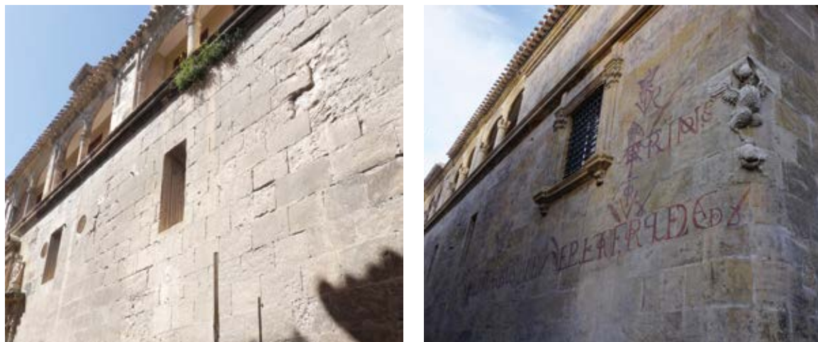
Figuras 5 y 6. La fachada sur vista desde la esquina oriental, antes y después de las obras.
