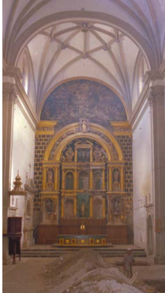
Figura 5. Comienzo del Proyecto, año 1981. Interior de la iglesia todavía con revestimiento.
