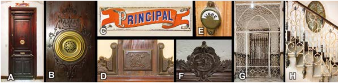
Figura 4. Diversos detalles de carpinterías, letreros y cerrajerías del edificio. A. Puerta de acceso a vivienda. B. Detalle de mirilla de puerta de acceso. C. Cartelería indicativa del piso. D. Detalle en carpintería de las iniciales CM del propietario en el aseo principal del piso primero. E. Detalle de indicación de libre/ocupado en aseo de una de las viviendas. F. Trabajo de tallado en la puerta del despacho de planta baja. G. Rejería de la segunda puerta del edificio. H. Vista parcial de la barandilla de la escalera y óculo de escalera.
