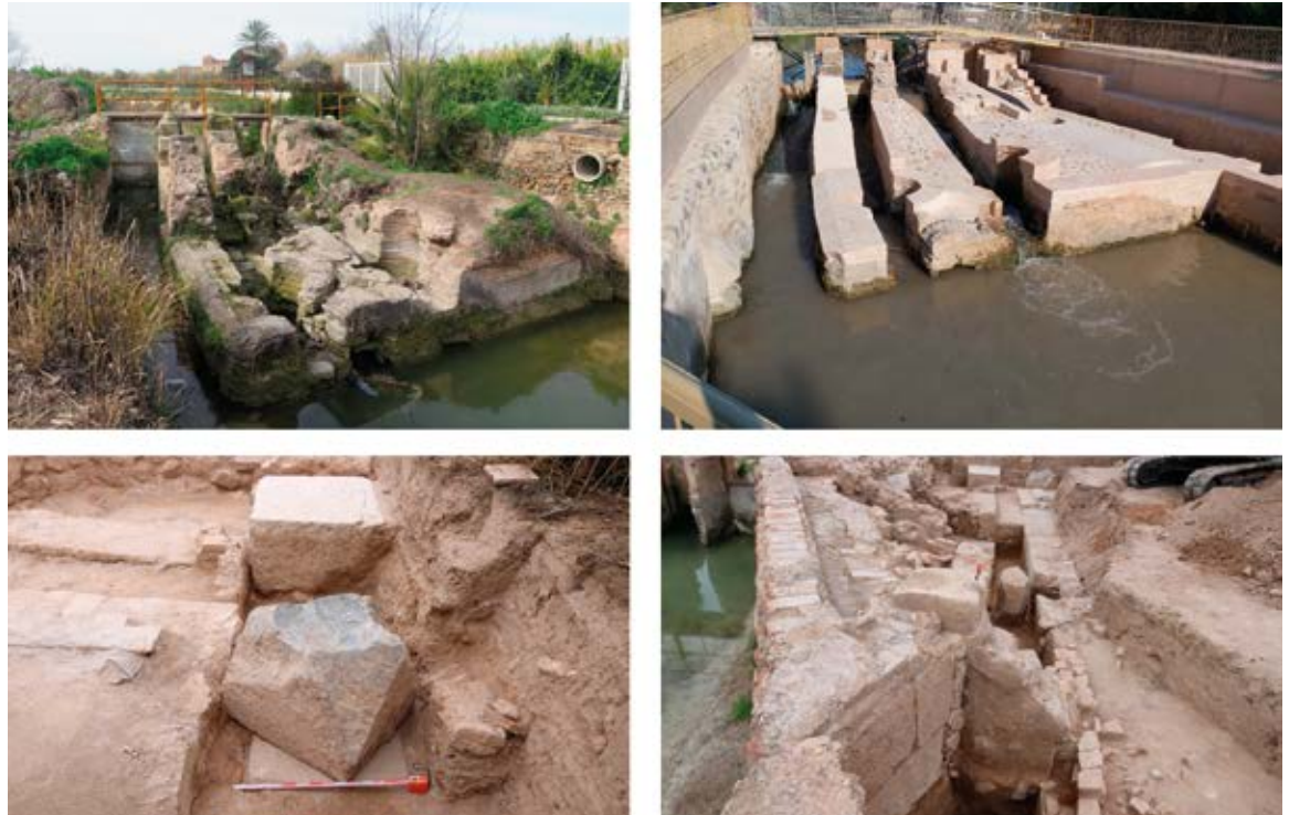
Figura 4. Estado inicial y final de las estructuras hidráulicas (arriba). Abajo: “sala de pica” con mortero y zapata de caliza gris (izda.). Tajamar y canal de impulsión del molino de pólvora (dcha.).
