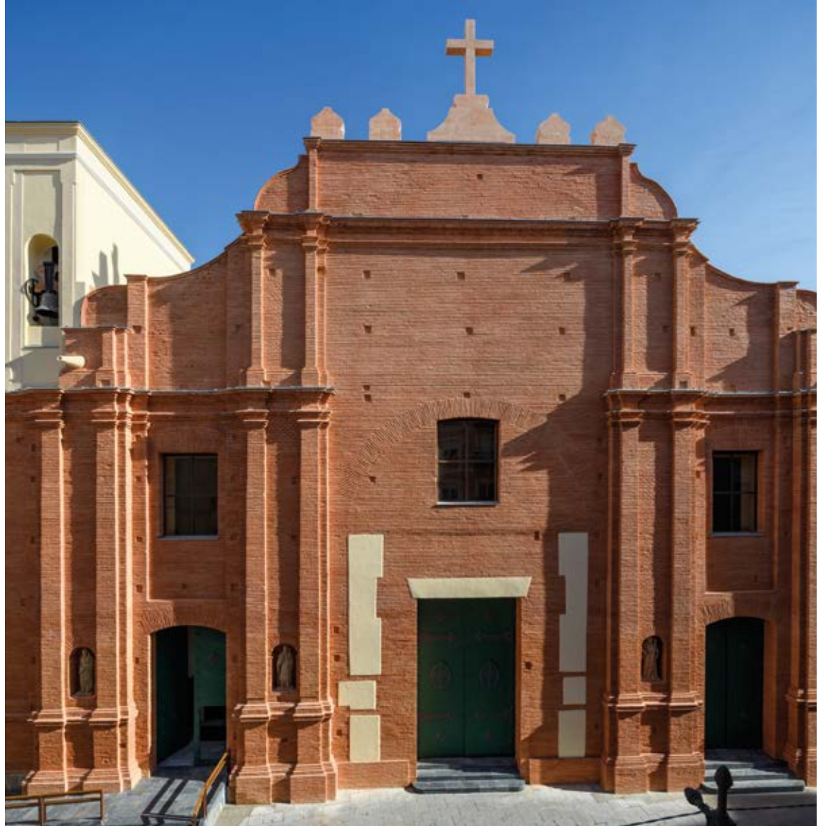
Figura 8. Fachada de Santa María de Gracia finalizadas las obras. A la izquierda, la nueva rampa (esquina inferior) y el cuerpo de campanas (esquina superior). Sobre el zócalo, las cuatro hornacinas descubiertas y, en su interior, los Cuatro Santos de Cartagena: San Leandro, San Fulgencio, Santa Florentina y San Isidoro. Toda la fachada muestra los aparejos de fábrica de ladrillo recuperados, quedando únicamente cubierto con mortero de cal el entorno de la puerta principal, pues aparecieron restos de unos cajones de mampostería (no pensados para ser vistos), que probablemente se correspondan con restos de posibles enjarjes que se dejaron preparados en la fachada para poder colocar una portada que cubriera el hueco central de la fachada. Aunque no se aprecia en la imagen pues son prácticamente invisibles, se ha instalado una línea de protección frente a las palomas en las cornisas, así como iluminación mediante tiras de led (estas últimas se combinan con la iluminación procedente de los focos instalados en las fachadas opuestas de la iglesia). (Fotografía: Joaquín Zamora)
