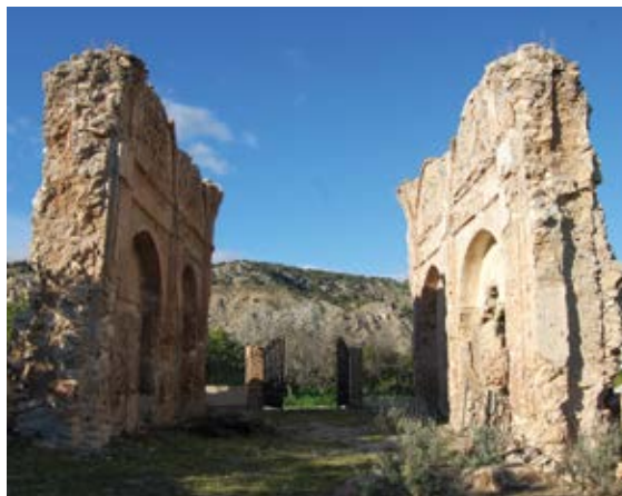
Figura 5. Muros laterales longitudinales este y oeste conservados de la ermita (Ricote).
