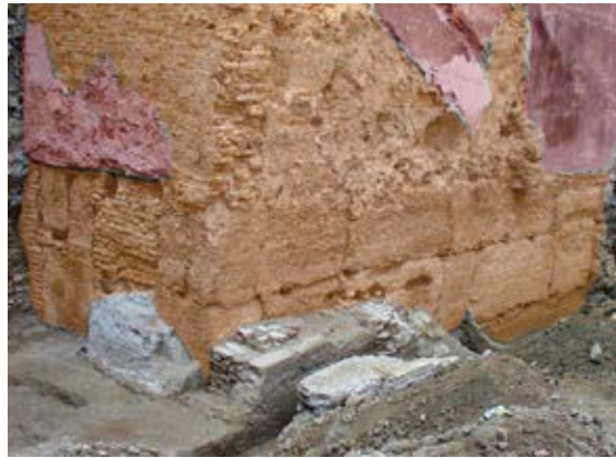
Figura 4. Alzado documentado durante la excavación de 1999. En rojo, trabajos de retirada de enlucidos, llagueado, limpieza y consolidación. En naranja, trabajos de llagueado, limpieza y consolidación. (Muñoz López, 2006)
