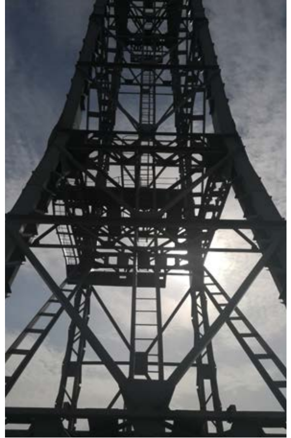
Figura 6. Estado actual de la grúa Sansón . (Fotografía: J. M. Chacón Bulnes)
