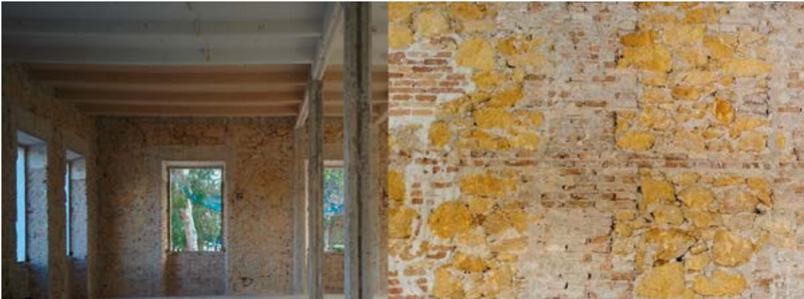
Figura 4. Estructura formada por sistema porticado y muros de carga, durante la rehabilitación del Pabellón I.
