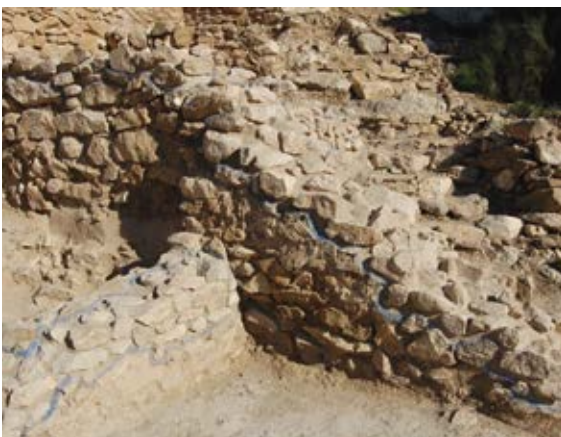
Figura 10. Hiladas de protección con interposición de malla de fibra de vidrio (Salto de la Novia-Ulea).
