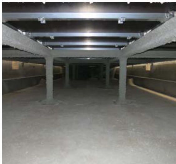
Figuras 9 y 10. Consolidación estructural en Fase II. Cimentación, estructura y forjado suelo técnico.
