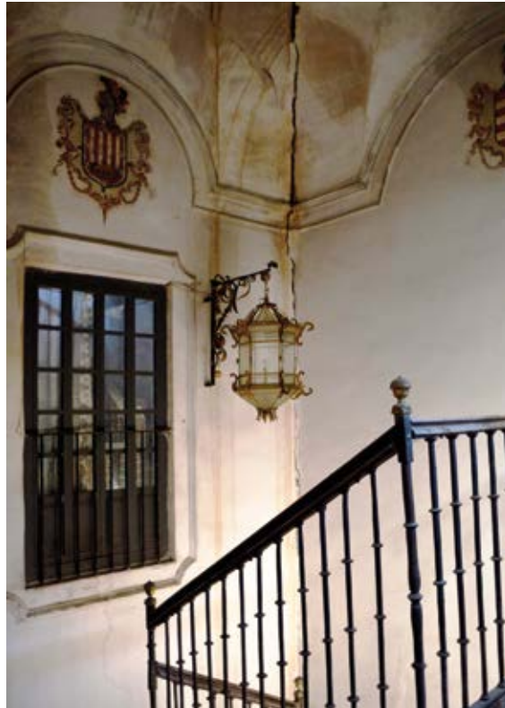
Figura 3. Hueco de escalera.
