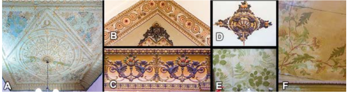
Figura 3. Distintos detalles de artesanados y techos del edificio. A. Techo del salón principal del tercer piso en chapa estampada. B, C y D. Artesonados de distintos techos de las viviendas que mantienen las pinturas originales. E. Papel pintado original del edificio. F. Pintura modernista del piso principal.
