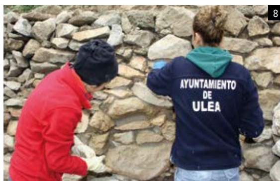
Figura 7. Consolidación química de las estructuras con aplicaciones de agua de cal (Salto de la Novia-Ulea).
