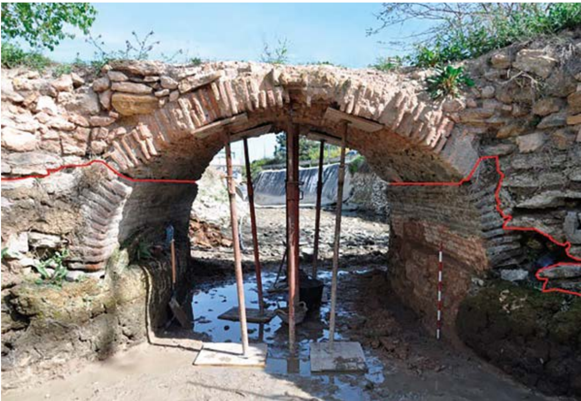
Figura 1. Puente de las Pilas. Fachada de poniente.
