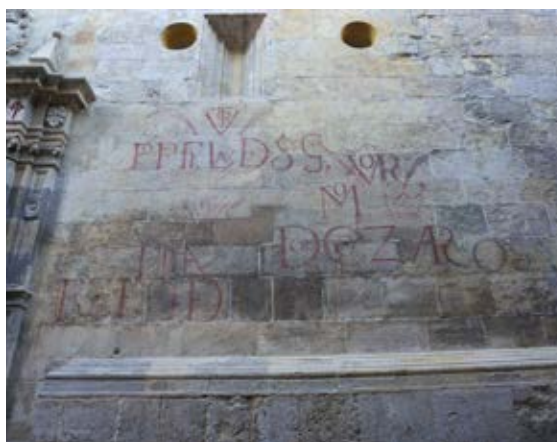
Figuras 3 y 4. Detalle de un tramo de la fachada sur (junto a la portada de acceso), antes y después de los trabajos de limpieza. A la derecha se aprecian los vítores que previamente estaban prácticamente ocultos al cien por cien, así como el tratamiento realizado sobre la sillería, tanto en las juntas, como en la limpieza y, principalmente, en la reducción del impacto de las costras negras.
