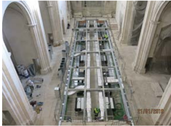
Figura 11. Desmontaje de suelo técnico para introducir las instalaciones.
