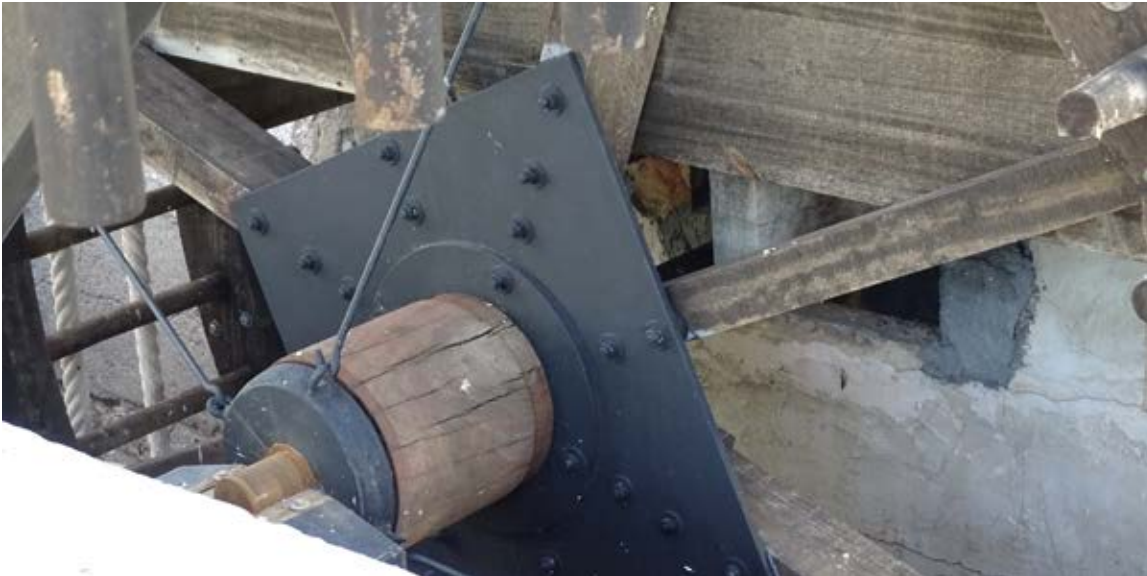
Figura 6. Detalle del nuevo eje horizontal. 2020.
