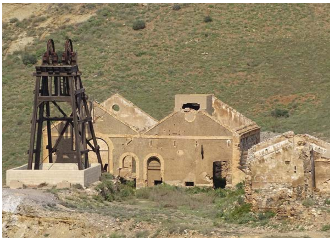
Figura 4. Castillete y casa de máquinas de la Mina María Jesús, en el Cabezo Agudo. Sector II. 2019.
