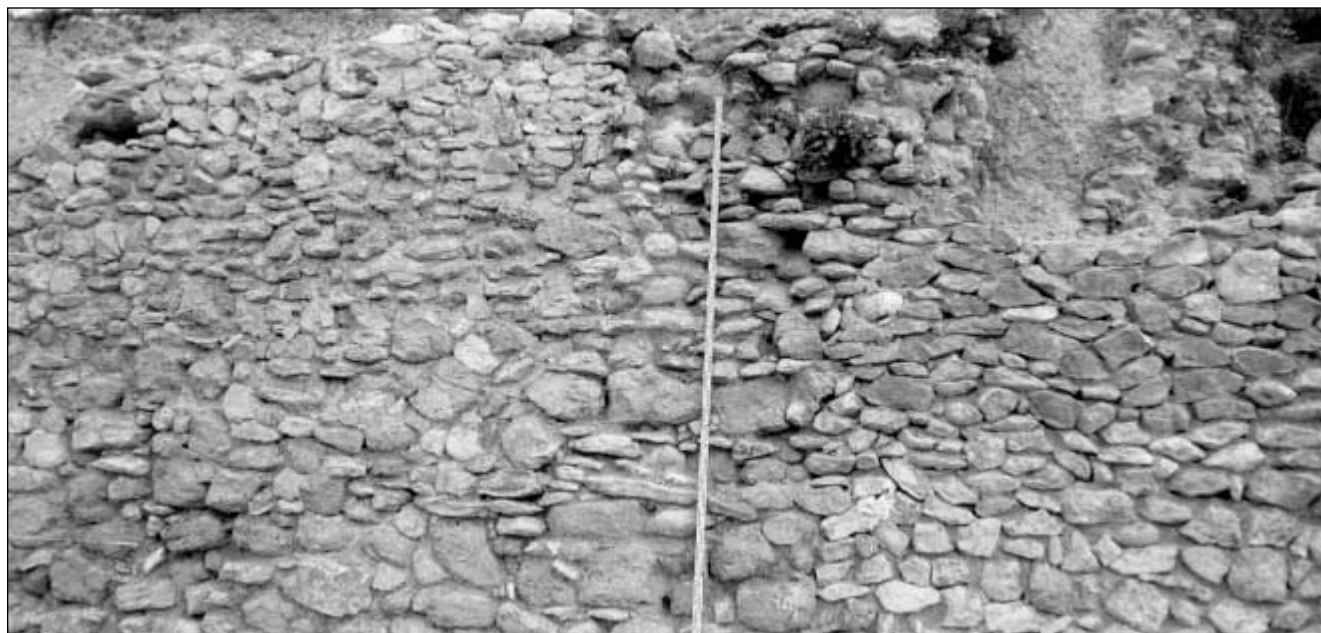
Lám. 3: Paseo de la Umbría, Bullas (Murcia). Tramo de muro y zócalo antiguo conservado en la pedriza moderna.
