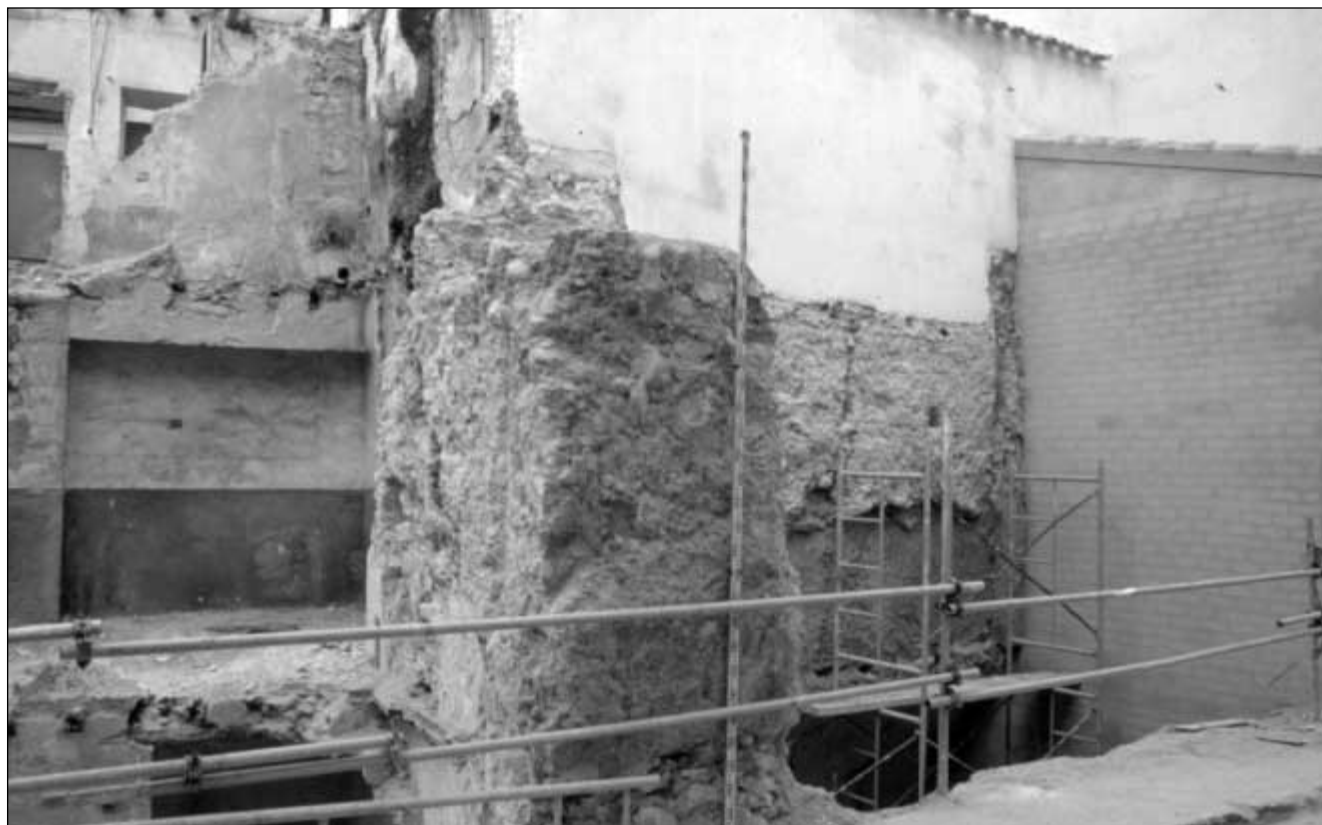
Foto 2: Puerta de Santa Ana. Estructuras murales.
