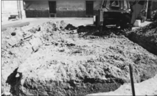
Lámina 1. Tanto el lienzo de muralla como el torreón se descubrieron en planta en un primer momento con medios mecánicos.
