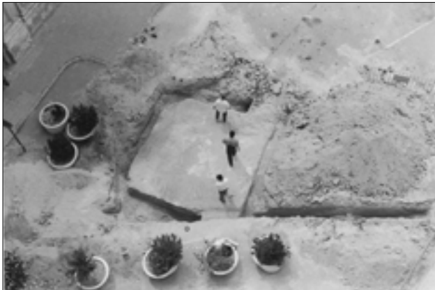
Lámina 7. Vista de la planta del torreón desde el edificio de los curas.
