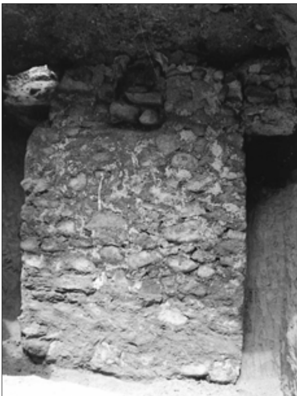
Lámina 3. Muro posible postigo o sostén de la muralla por reparación.
