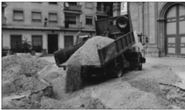
Láminas 4 y 5. Enterramiento de la muralla con zahorra después de la intervención.
