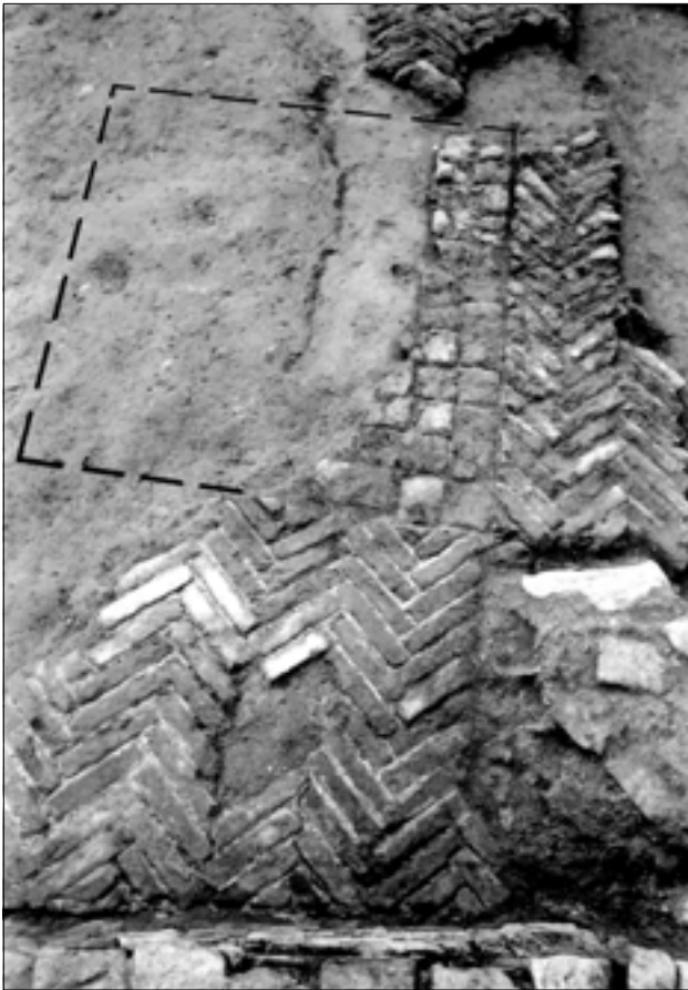
Lámina 8: Detalle del pavimento de la última fase islámica del patio de la Casa 3, con ladrillo a sardinel en los andenes y arriate simulado.
