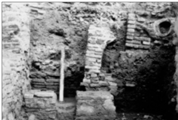
Lámina 18: C-7. Arranque de escalera (tercera fase).
