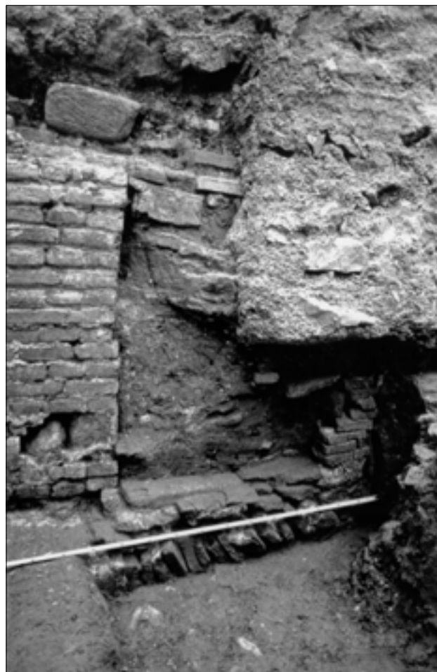
Lámina 25: Callejón de los Peligros. Fachada oeste del grupo de viviendas situado a levante de la calle. Adarve de ingreso a la casa 3.
