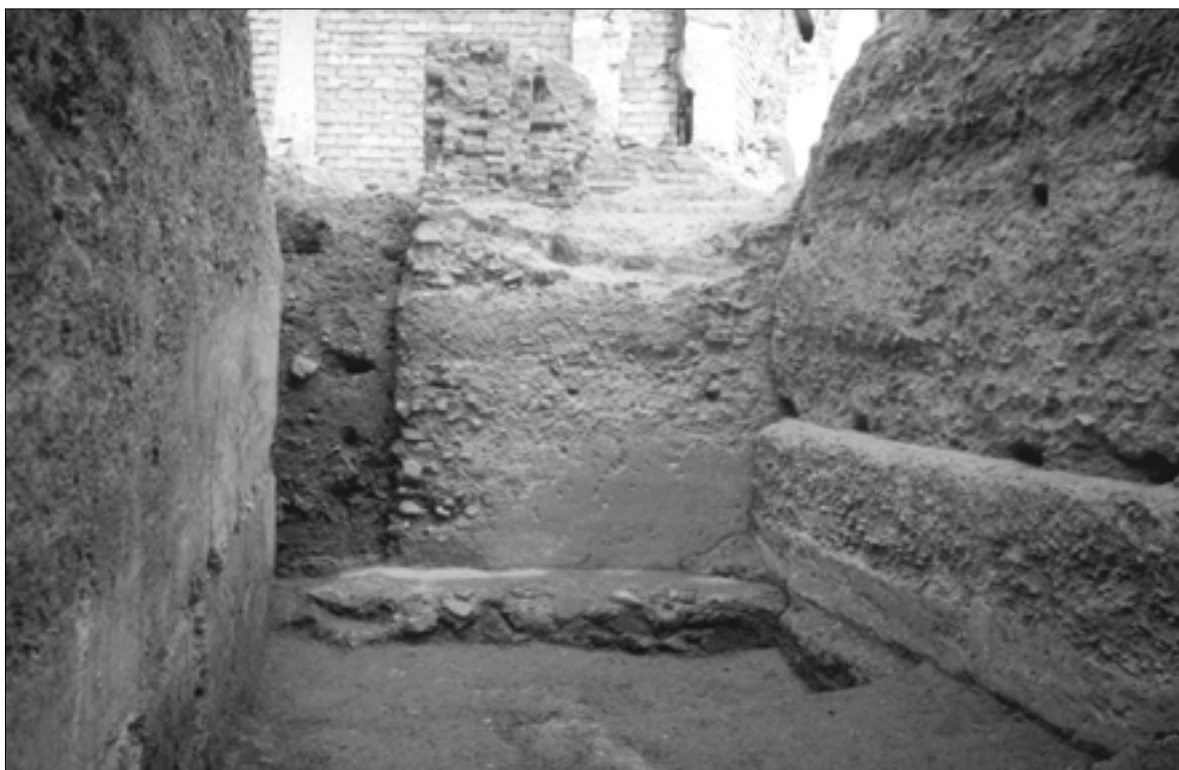
Lámina 1.- Vista de la barbicana desde el sur. Al fondo, el torreón; a la derecha, la muralla y a la izquierda, la antemuralla.
