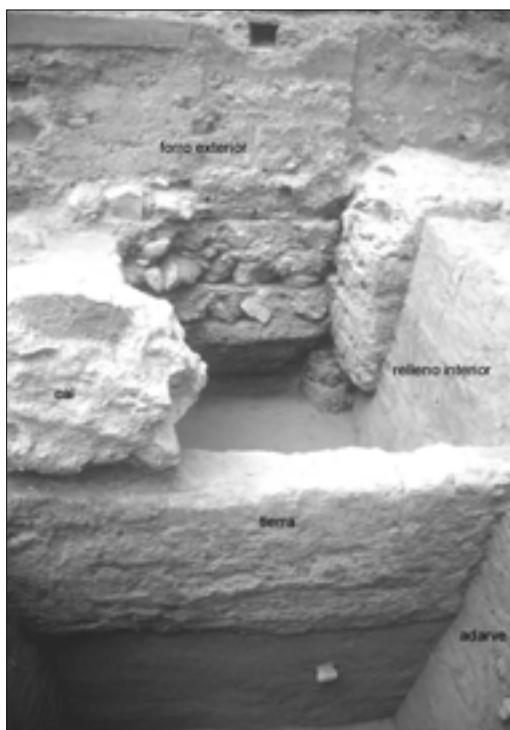
Lámina 2.- La muralla desde el adarve; en primer término el forro interior, compuesto por una fase más antigua de tierra (muro inferior) y otra más moderna de mortero de cal (superior); al fondo, el forro externo visto desde el interior.
