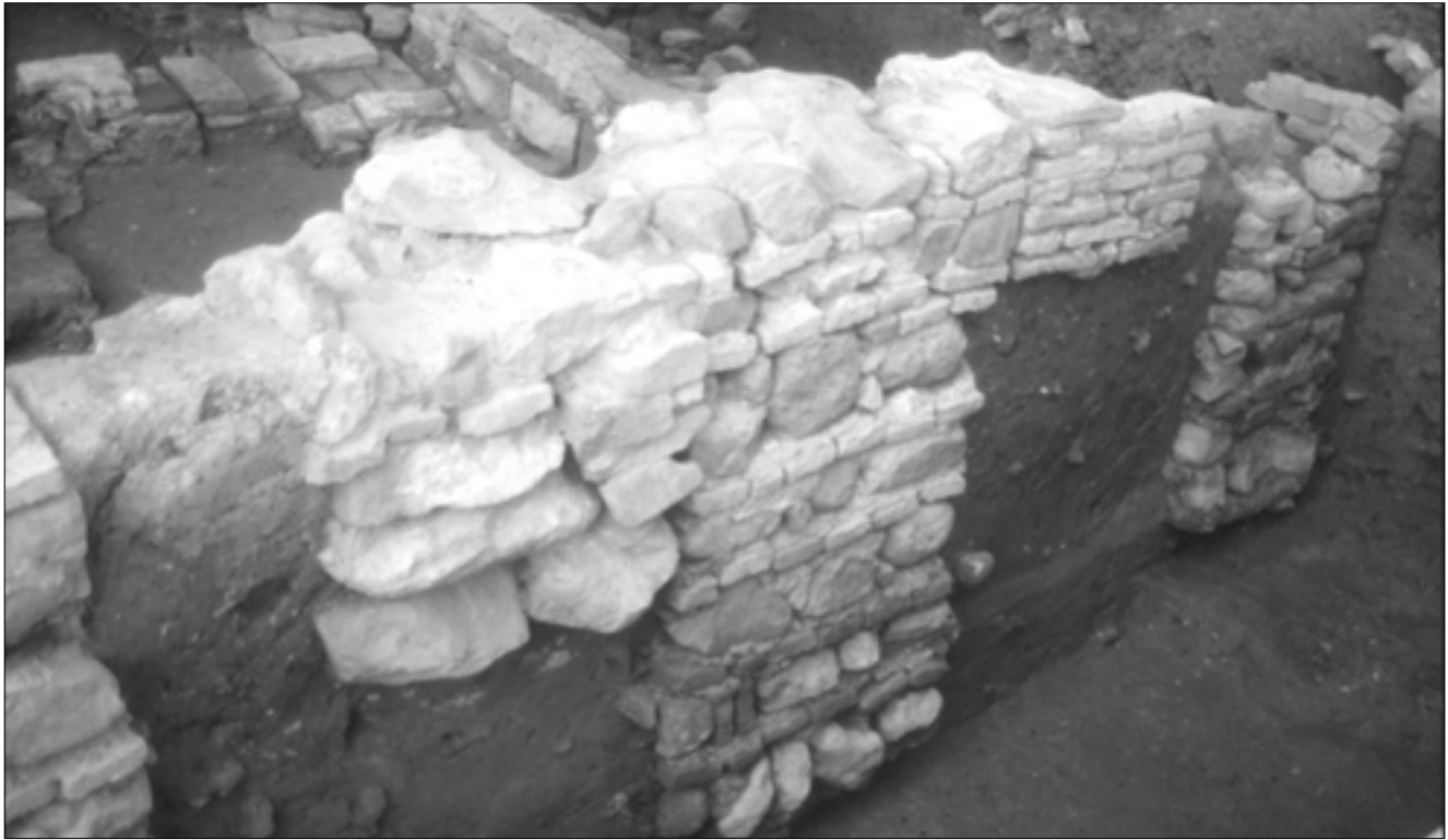
Lámina 14.- Detalle del muro que cierra la casa por el oeste; obsérvense los bataches con que fue reparada la fábrica original de tierra.
