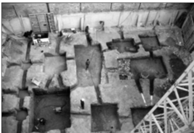
Lámina 1: Vista general del solar con las áreas de excavación.
