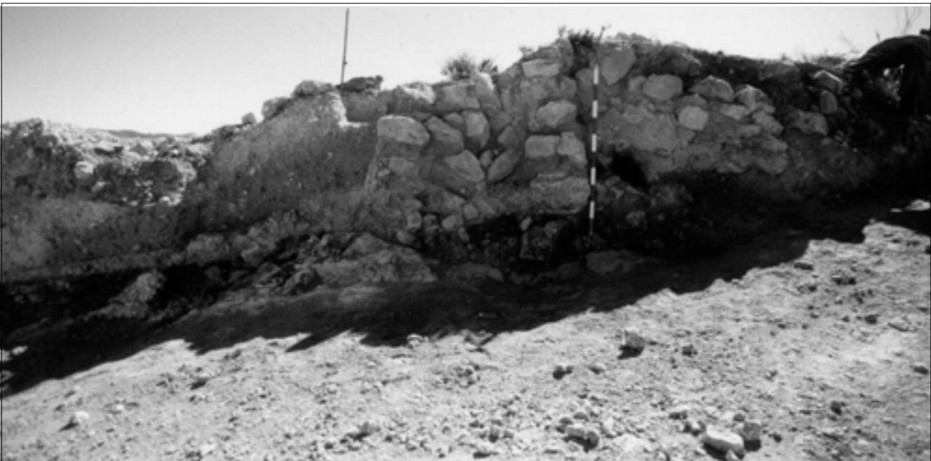
Lámina 2. Perfil abierto por la maquinaria para la realización del camino. Unidad de registro 6J. En el perfil se puede observar la muralla perimetral norte del poblado seccionada.
