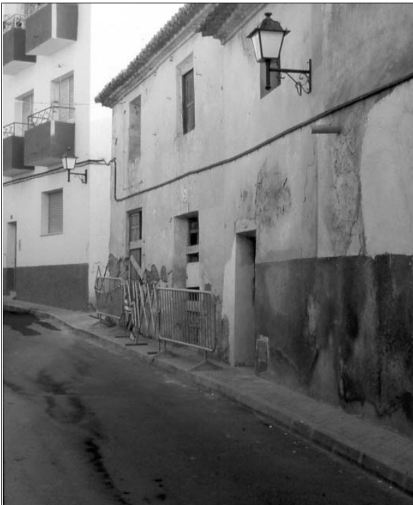
Lámina 1. Inmueble en c/ Fulgencio Cerón, nº 2 donde se realizó la excavación.
