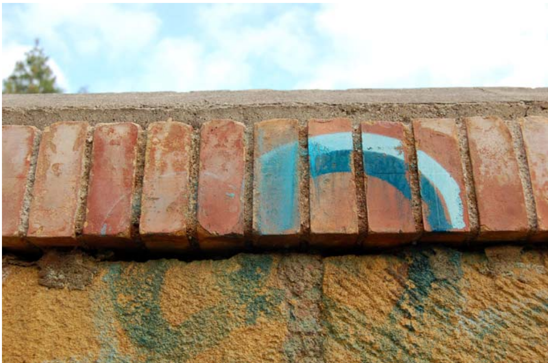
Proceso de eliminación de los graffitis del lado derecho de la valla histórica
