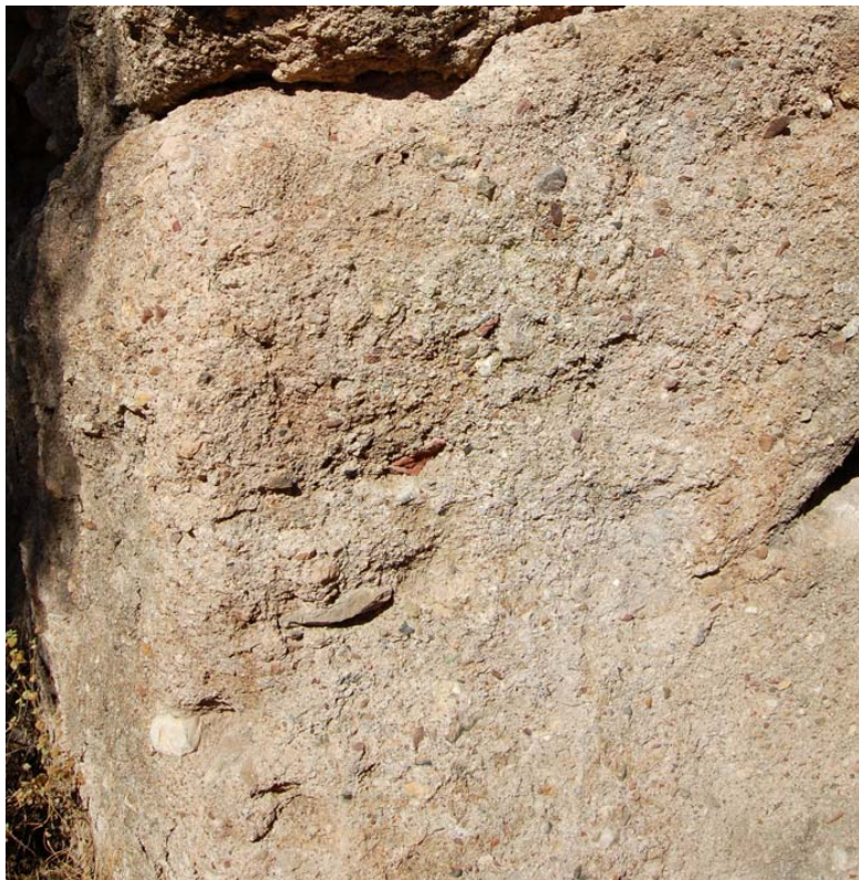
Estado inicial y final del graffiti nº 5
