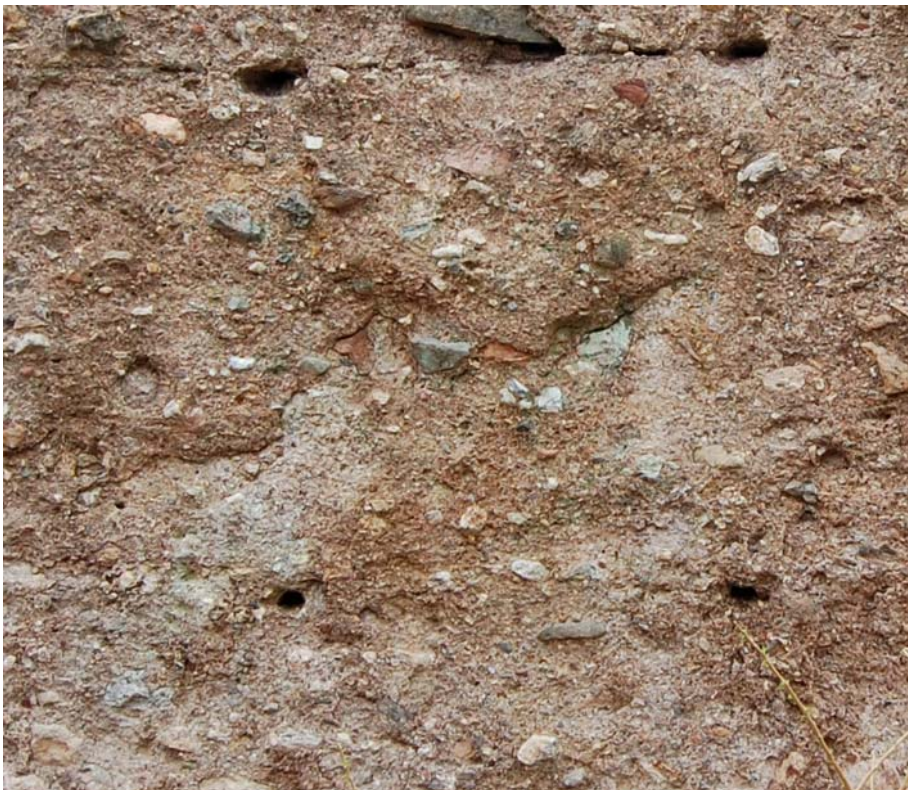
Estado inicial y final del graffiti nº 11
