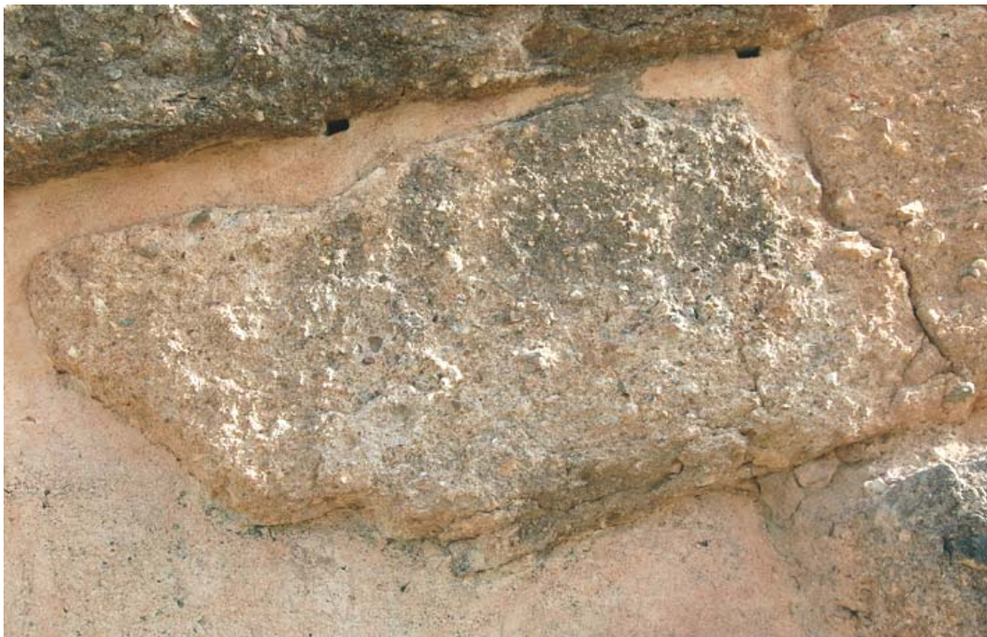
Estado inicial y final del graffiti nº 7
