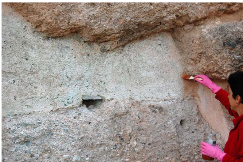
Proceso de eliminación y entonado cromático del graffiti nº 8
