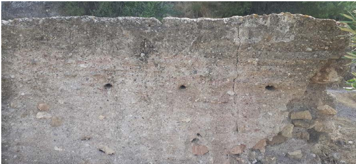
Estado inicial y final
