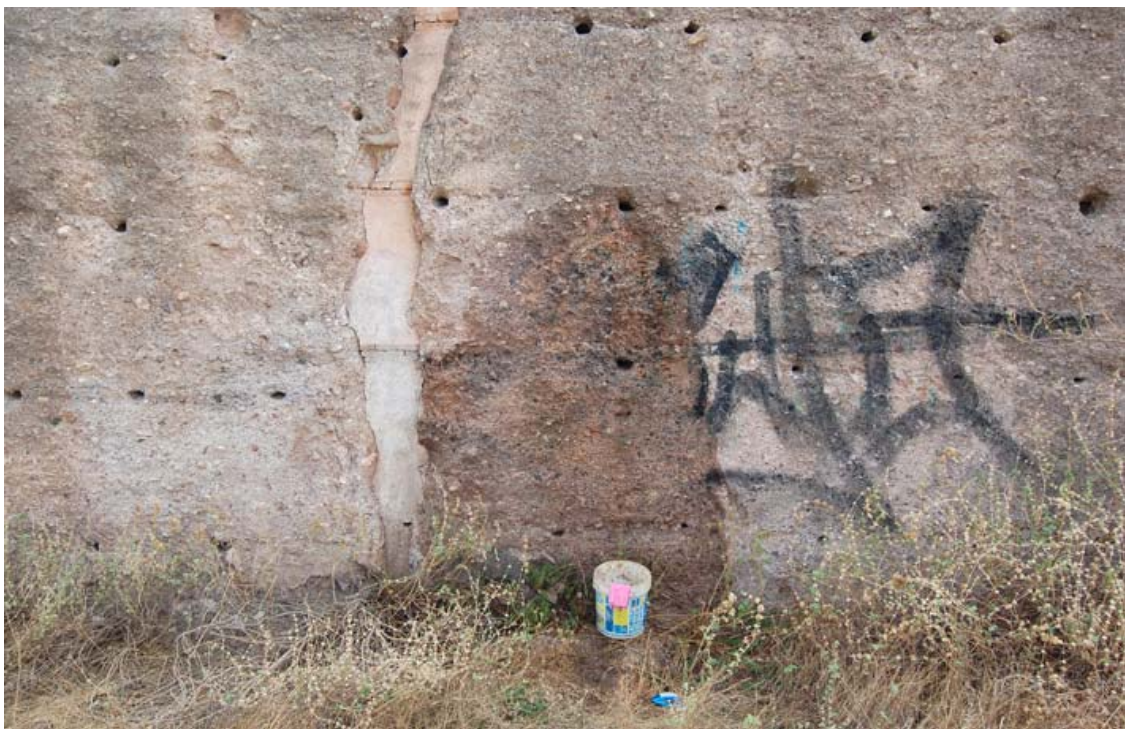
Proceso de eliminación del graffiti nº 10
