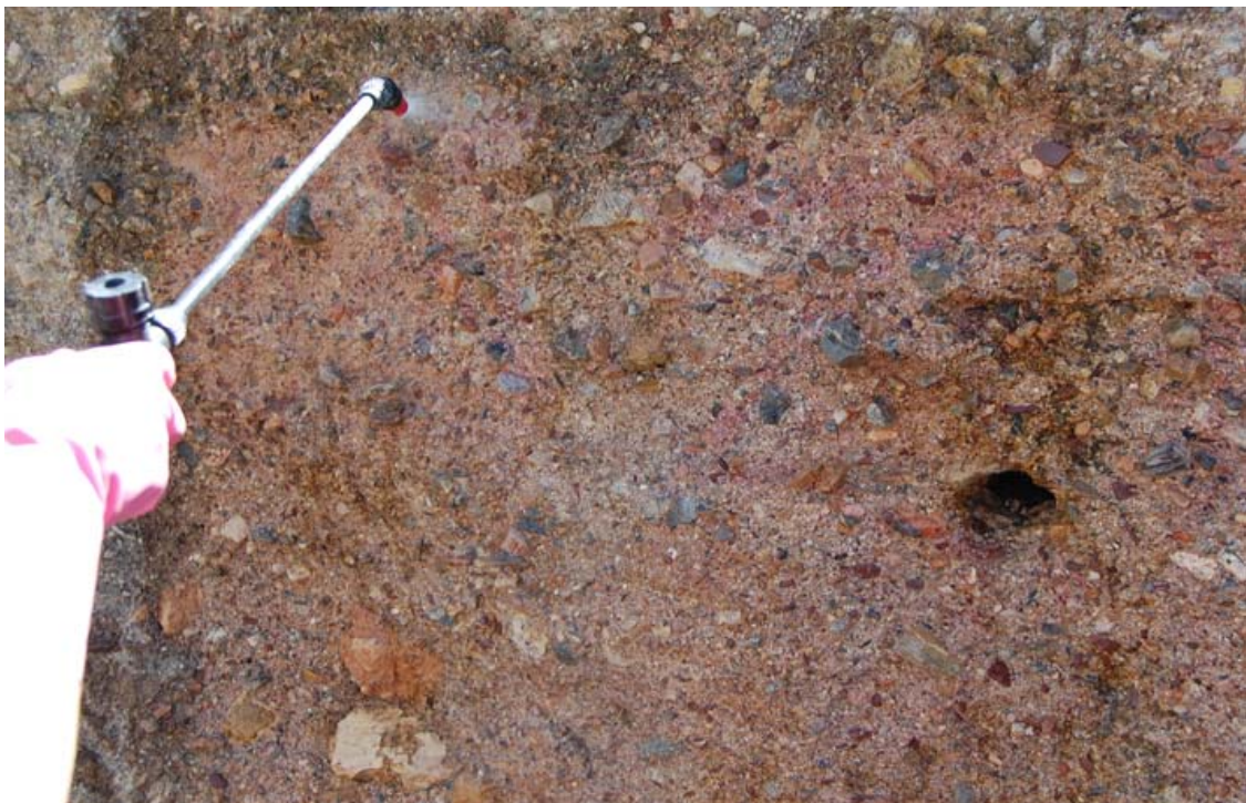
Proceso de eliminación del graffiti
