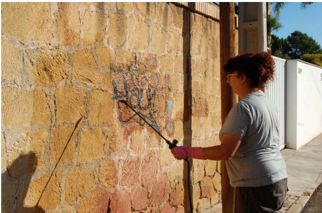
Proceso de eliminación de los graffitis del lado derecho de la valla histórica
