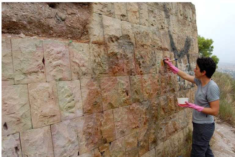
Proceso de eliminación de los graffitis nº 14, 15, 17, 18 y 19
