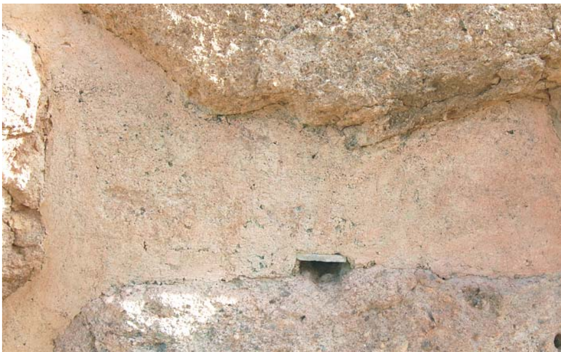
Estado inicial y final del graffiti nº 8
