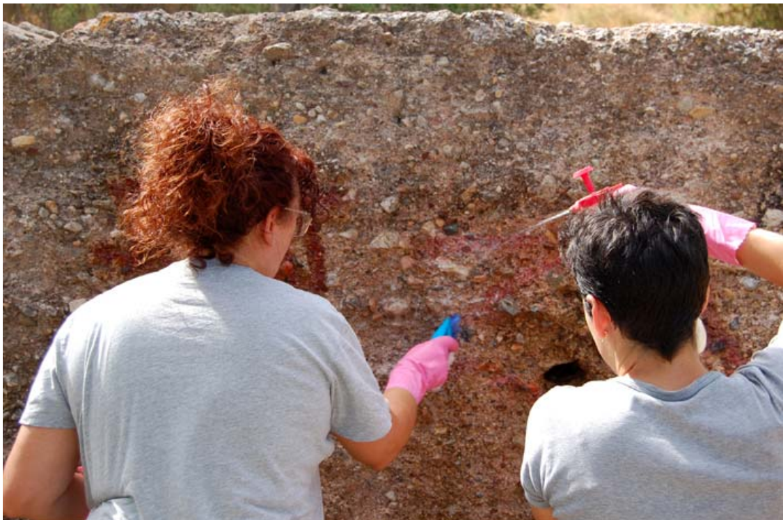
Proceso de eliminación del graffiti
