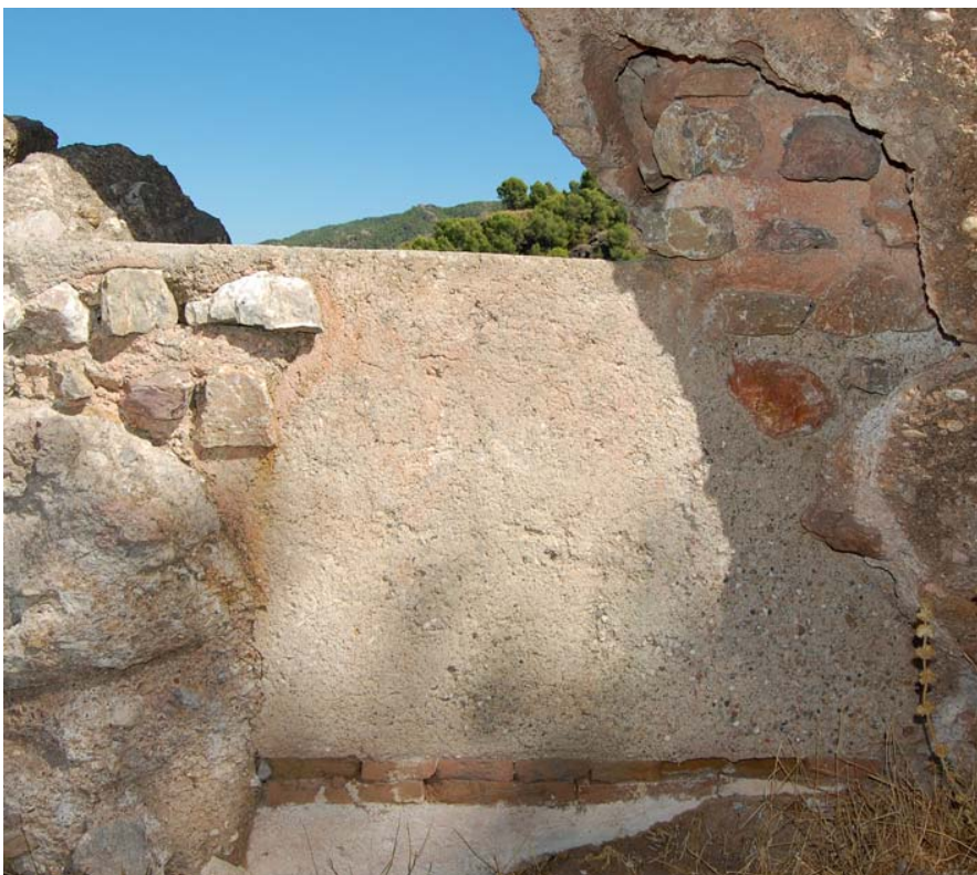
Estado inicial y final del graffiti nº 1
