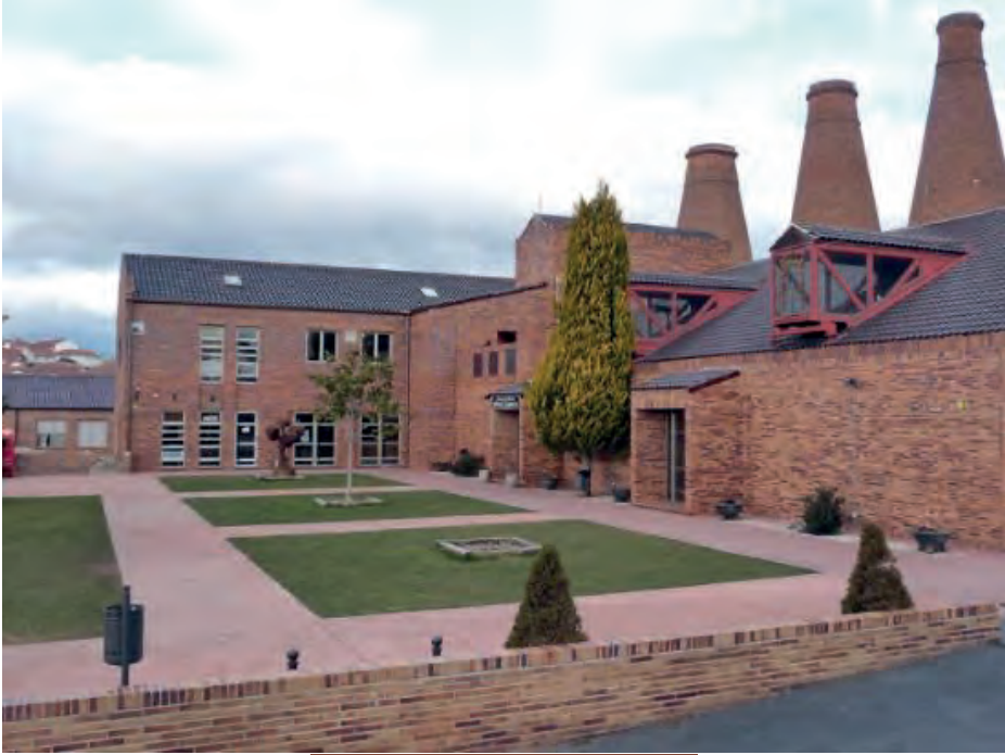
Fábrica de Valdemorillo tras la restauración. Actual Casa de la Cultura.
