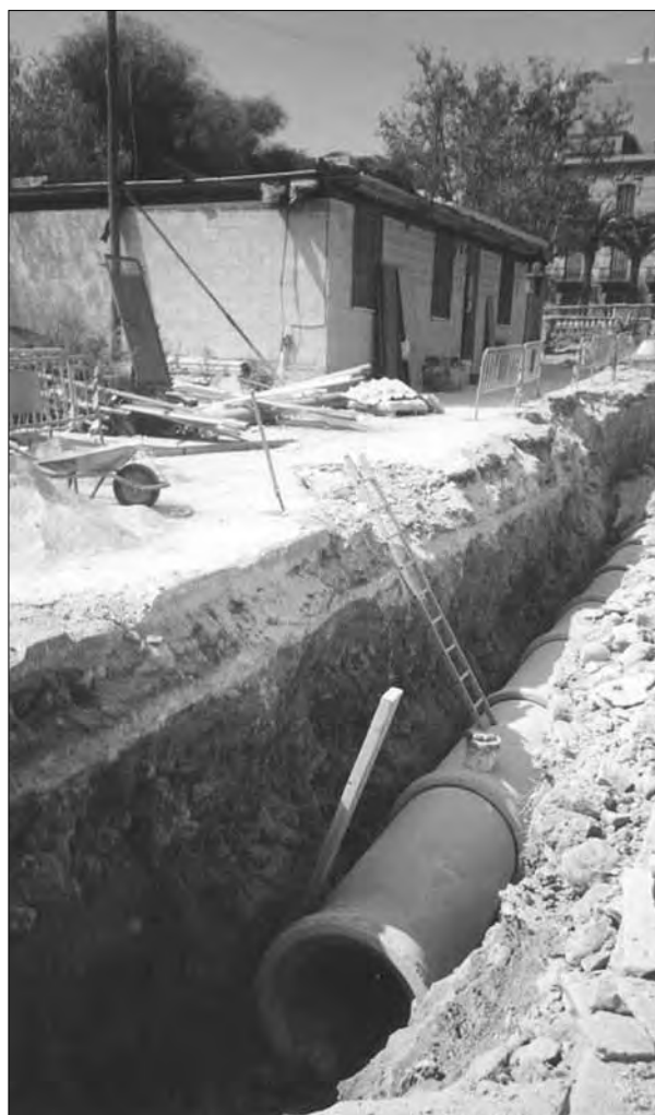
Lámina 7. Secuencia estratigráfica frente a la fachada principal del Hospital de Marina. Zanja de alcantarillado.
