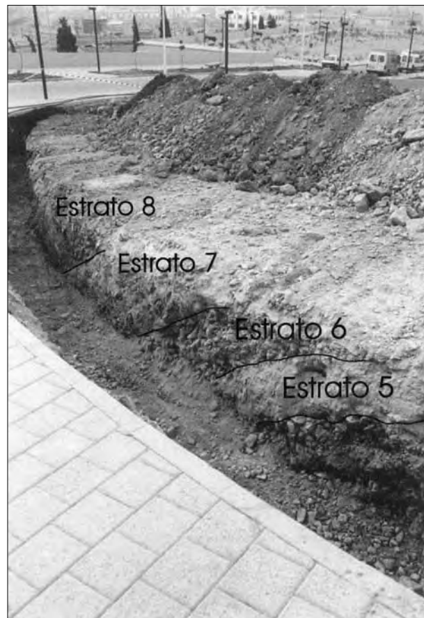
Lámina 5. Detalle de la secuencia estratigráfica localizada en la calle de nuevo trazado abierta entre Antiguones y el Hospital de Marina. Zanja de agua potable.
