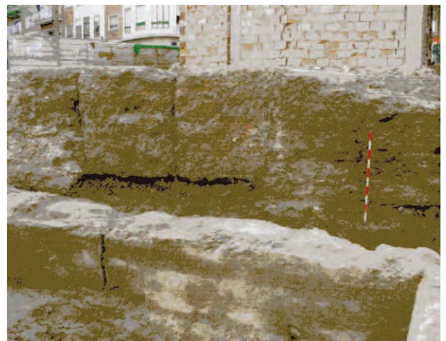
Lámina 16. Forro interior de la muralla.
