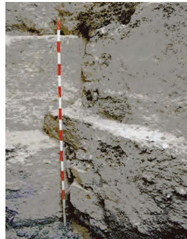
Lámina 14. Conexión entre las cajas del forro exterior, tramo oeste.
