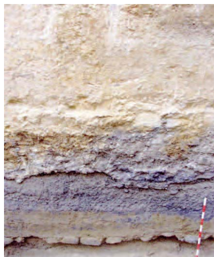
Lámina 8. Detalle de la cimentación de la muralla, sector Este.
