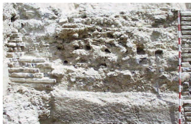
Lámina 6. Muralla 1 por tramos.
