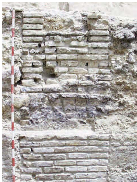
Lámina 7. Muralla 1 por tramos.
