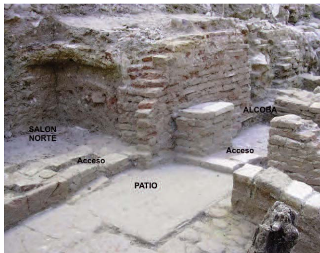
Lámina 14. Detalle de los materiales y técnicas constructivas empleadas en la Casa III.
